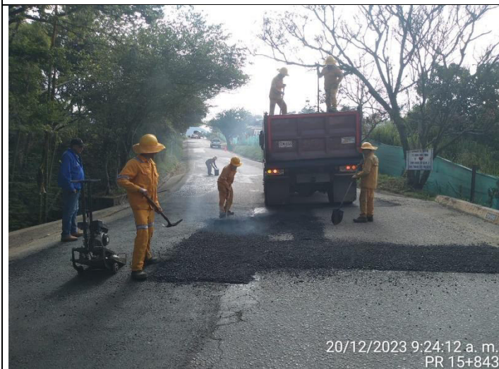
MEJORAMIENTO DE LA CAPA DE RODADURA PR15+0843
