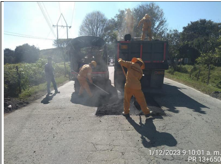
MEJORAMIENTO TAPA DE RODADURA PR 13+0650
