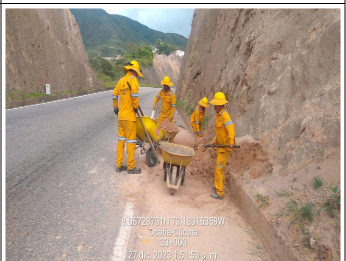
LIMPIEZA DE CUNETAS REVESTIDAS PR33+0000
