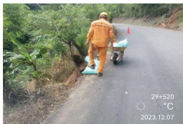
INSTALACIÓN DE BARRERAS PR 00+0160
