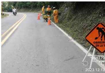
LIMPIEZA DE CUNETAS REVESTIDAS Y EN TIERRA PR 25+0170
