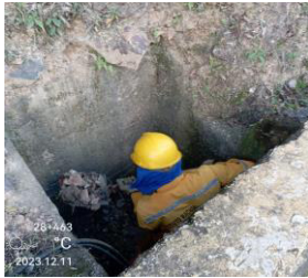
LIMPIEZA DE ALCANTARILLA PR28+0463
