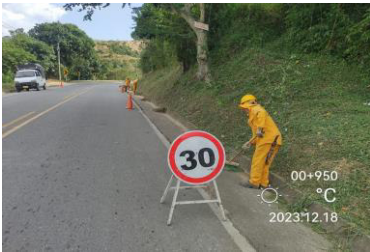
LIMPIEZA DE CUNETAS REVESTIDAS PR00+0950
