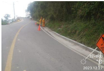
LIMPIEZA DE CUNETAS REVESTIDAS PR 32+0800
