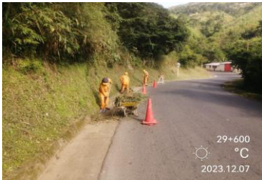
LIMPIEZA DE CUNETAS REVESTIDAS PR 23+0600
