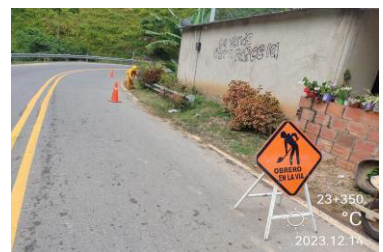
LMPIEZA DE CUNETAS Y LIMPIEZA DE DEFENSAS METALICAS PR 23+0350
