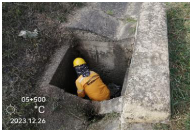
LIMPIEZA DE ALCANTARILLA PR05+0500
