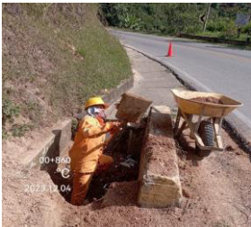
LIMPIEZA DE ALCANTARILLA PR00+0860
