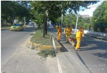
LIMPIEZA DE LA VIA PR 49+0230
