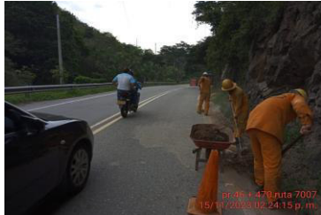
LIMPIEZA Y REMOCION DE DERRUMBES PR 46+0470
