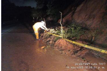
LIMPIEZA Y REMOCION DE DERRUMBES PR 46+0449
