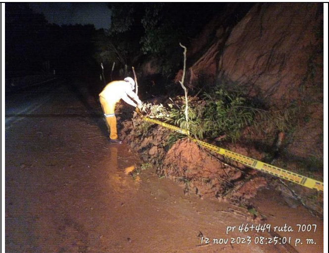
LIMPIEZA Y REMOCION DE DERRUMBES PR 46+0449
