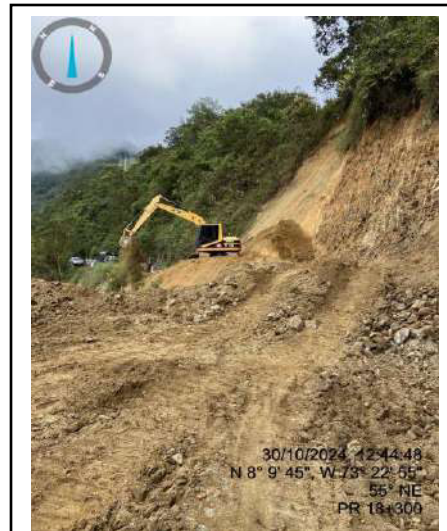
Excavaciones en el PR 18+300
