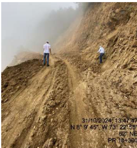
AMPLIACIÓN DE CALZADA PR 18+300
