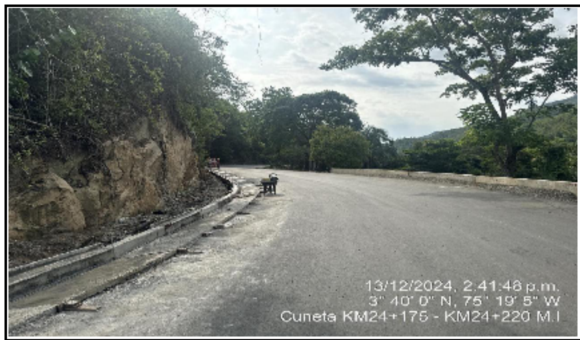
Foto 6. Instalación de concreto cunetas km 24+220 - Tramo 2
