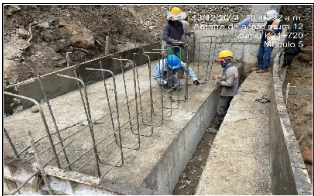
Foto 1. Instalación de acero dentellón muro km 21+720- tramo 1
