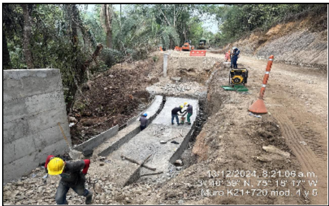
Foto 4. - Instalación de acero para vástago km 21+720 -Tramo 1
