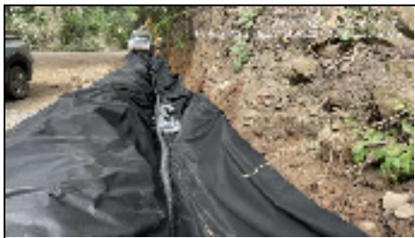
Foto 3. Instalación de filtro longitudinal km 22+000 - Tramo 1
