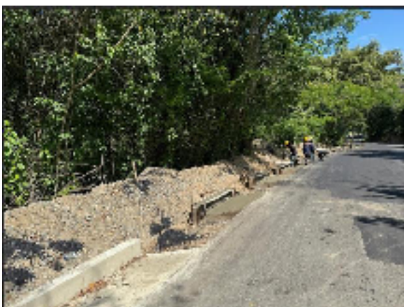
Fotografía 3. Conformación Construcción Cunetas
