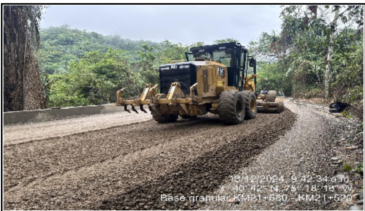
Foto 2. Instalación de base granular km 21+520 - Tramo 1
