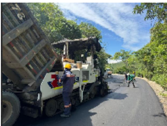
Fotografía 1. Pavimentación en Concreto Flexible
