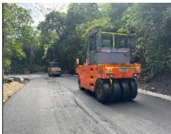
Fotografía 2. Pavimentación en Concreto Flexible
