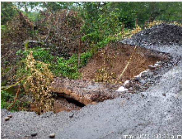
Figura 3 Aspecto K42+000 falla de estructura hidráulica.
