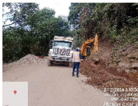
Fotografía 12. Verificación obras Tramo 1 Coyaima - Ataco
