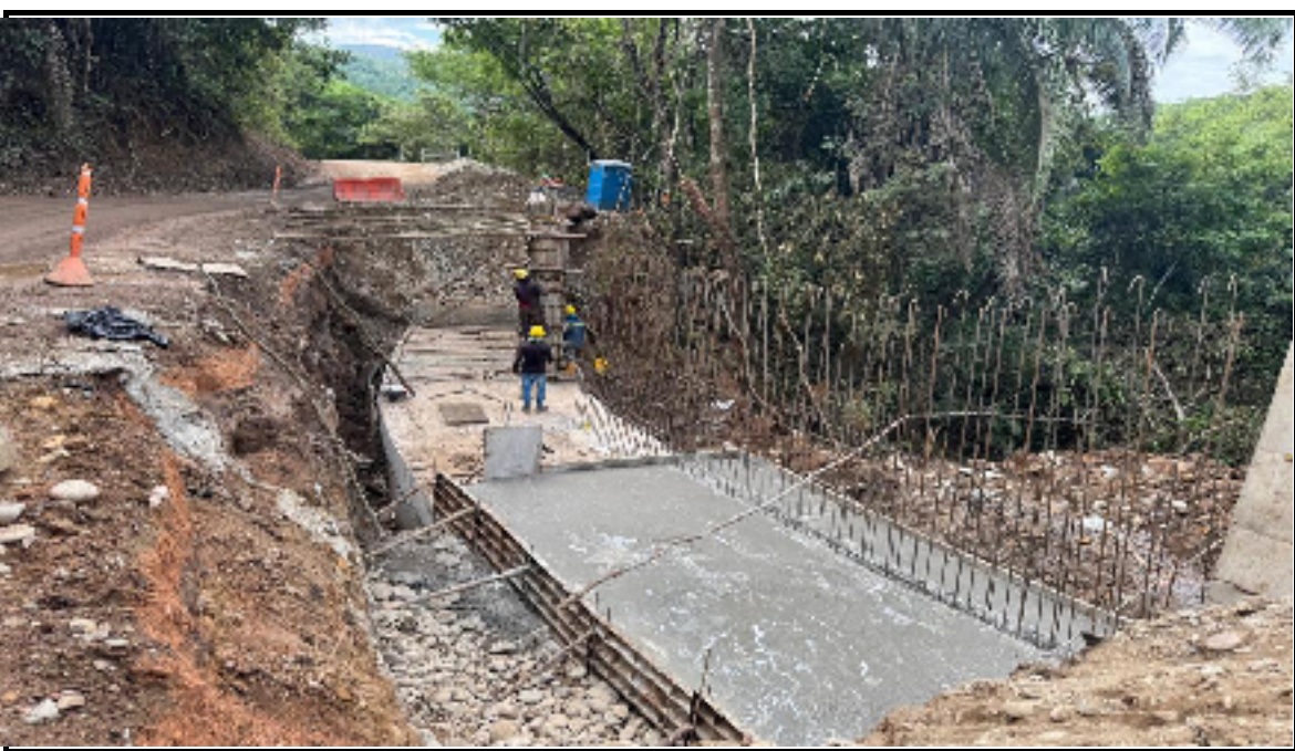
Foto 5. Figurado de acero muro km 21+720 - Tramo 1
