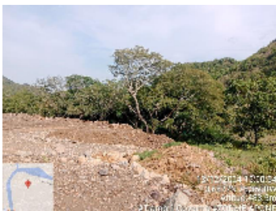
Fotografía 9. Verificación encerramiento ZODME APONE
