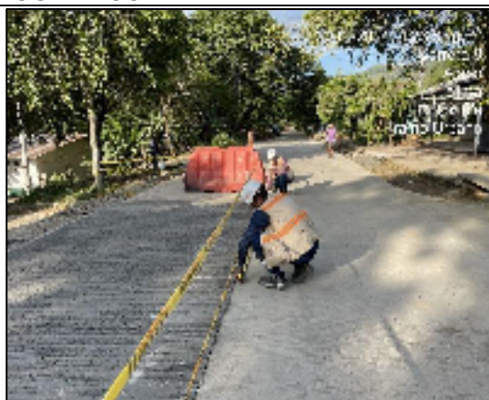
Foto 2. Concreto Tramo Urbano.
