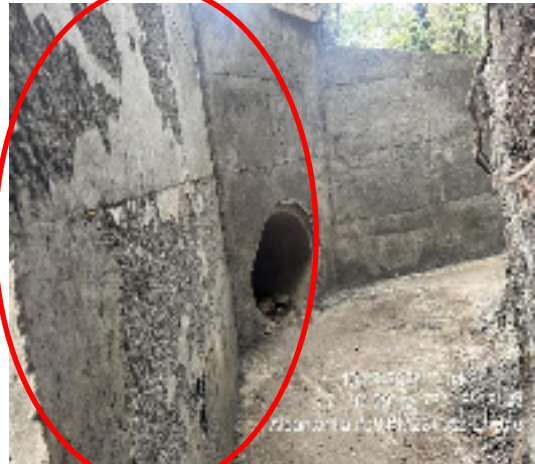
Hormigeo Alcantarilla No. 39 PR 22+053 Encole
