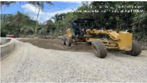
Foto 2. Instalación de base granular km 21+620 - Tramo 1
