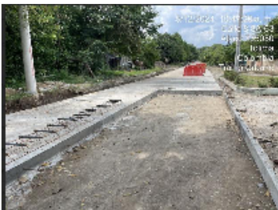
Fotografía 7. placas de Concreto Hidráulico Paso Urbano Ataco.
