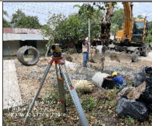
Foto 8. Chequeo de Pendiente e Instalación de Tubería k37+666..
