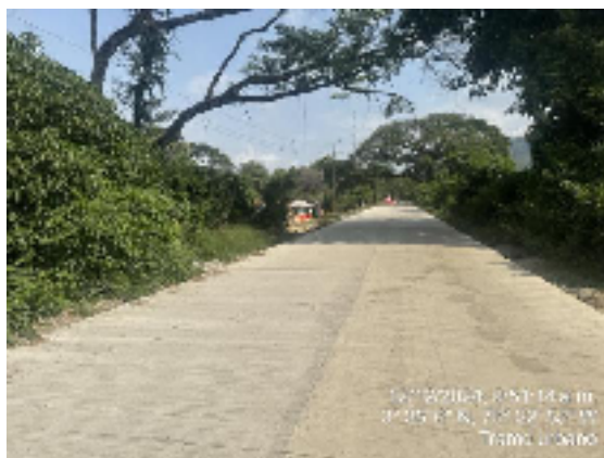
Fotografía 8. Placas Concreto Hidráulico Paso Urbano Ataco
