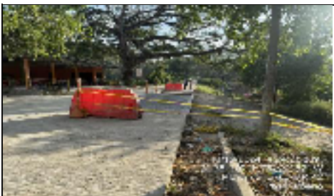
Foto 8. Instalación de concreto - Tramo 2
