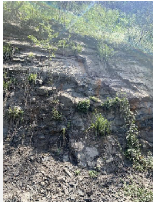
Reducción de ancho de calzada debido a procesos de erosión marginal del rio Saldaña, procesos de erosión diferencial en ladera de contrapendiente estructural.
