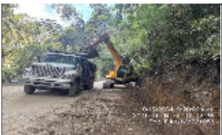
Foto 4. Excavación para filtro km 22+053 - Tramo 1
