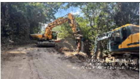
Foto 5. Excavación para muro km 21+720 - Tramo 1
