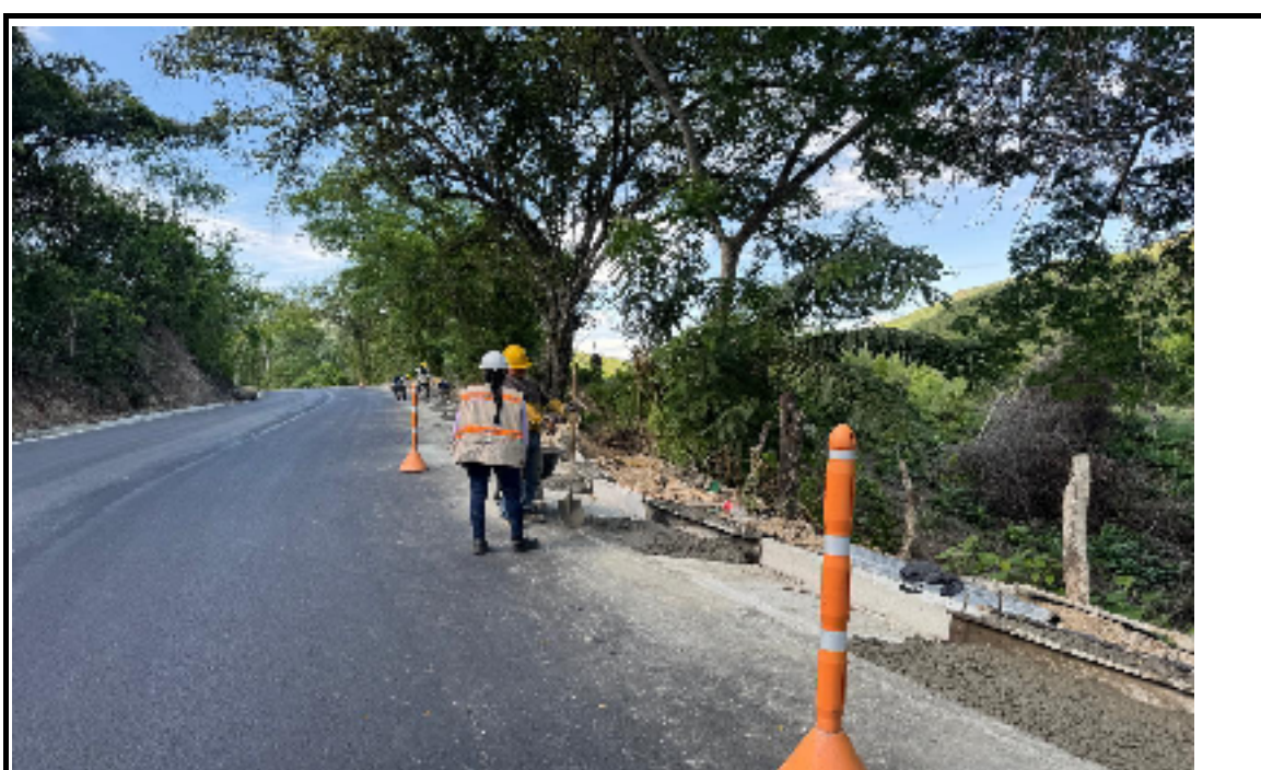
Foto 9. Verificación de actividades y cumplimiento ambiental Tramo 1 - Coyaima Tolima
