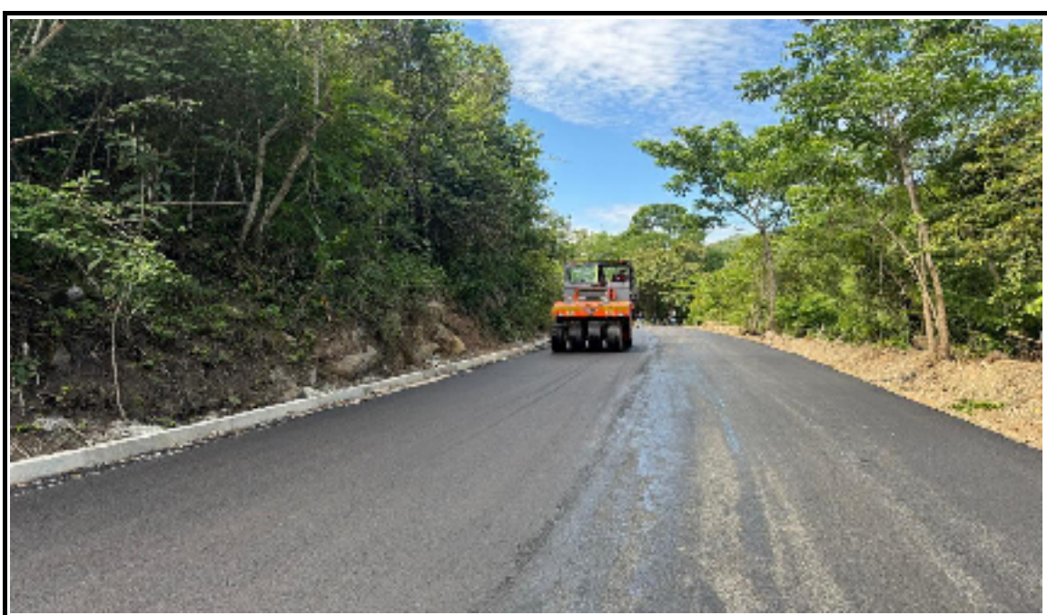
Foto 3. Instalación de base granular km 21+440- Tramo 1
