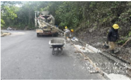
Foto 1. Instalación de concreto para cunetas km 24+220- tramo 1
