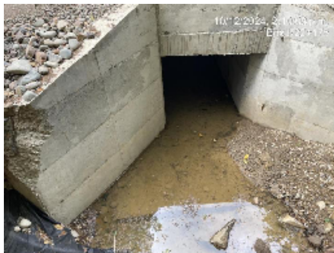
Hormigeo Alcantarilla No. 39 PR 22+053 Encole
