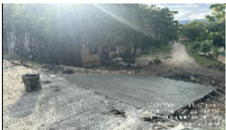
Foto 6. Instalación de concreto Paso Urbano - Tramo 2
