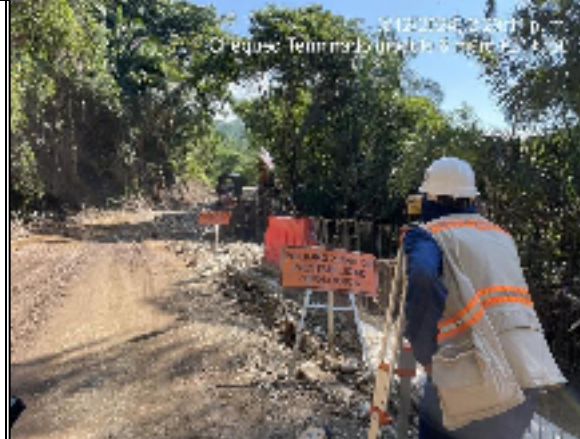
Foto 10. Chequeo de Terminado Muro 12 K21+720, Modulo 6.
