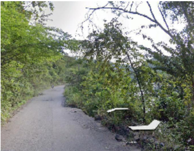
Reducción de ancho de calzada debido a procesos de erosión marginal del rio Saldaña, procesos de erosión diferencial en ladera de contrapendiente estructural.
