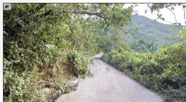
Figura 1 registro fotográfico K17+770 al K25+140 sitios de intervención con alcance a los estudios y diseños.
