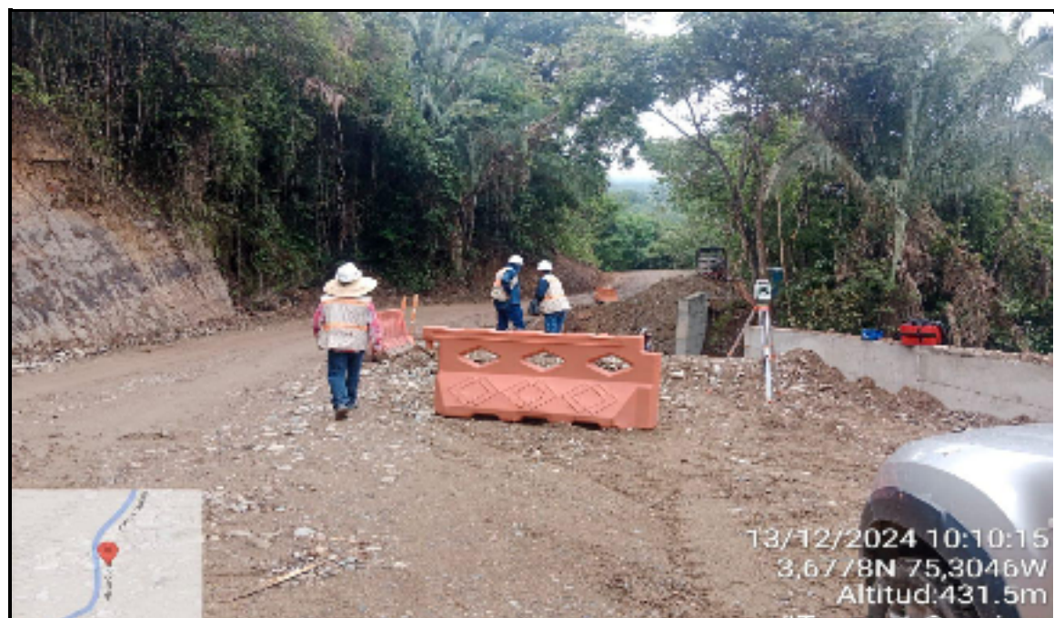
Foto 9. Verificación de actividades y cumplimiento ambiental Tramo 1 - Coyaima Tolima
