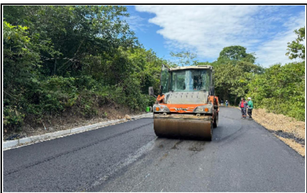
Foto 1. Instalación de acero dentellón muro km 21+720- tramo 1
