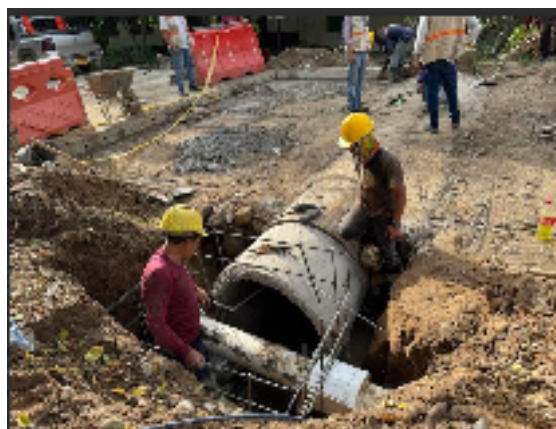
Fotografía 4. Encofrado e instalación de tubería 36" Alcantarilla 42 PR 21+440
