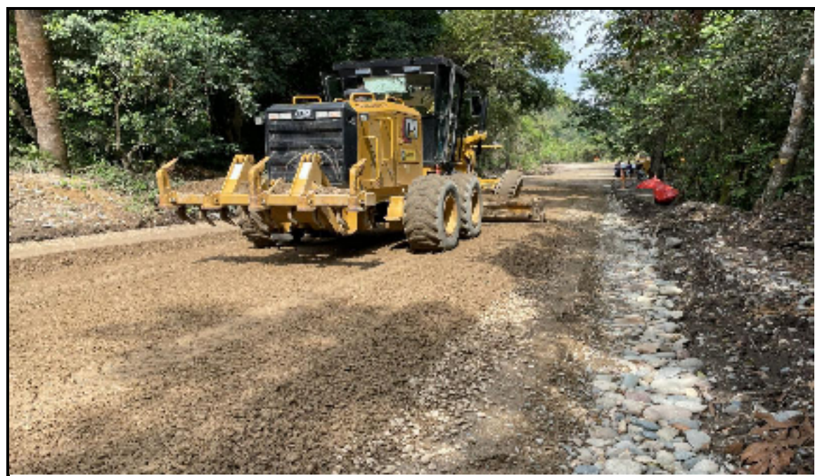
Foto 3. Instalación de base granular km 21+440- Tramo 1
