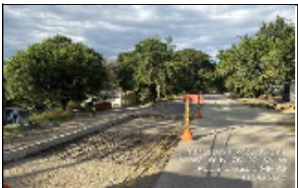
Foto 7. Instalación de acero de refuerzo - Tramo 2
