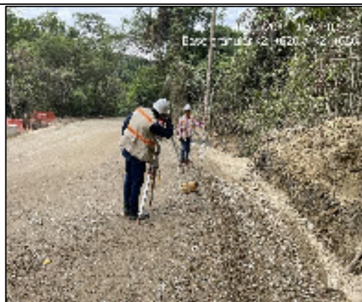
Foto 4. Chequeo Base Granular k21+620 al K21+680.
