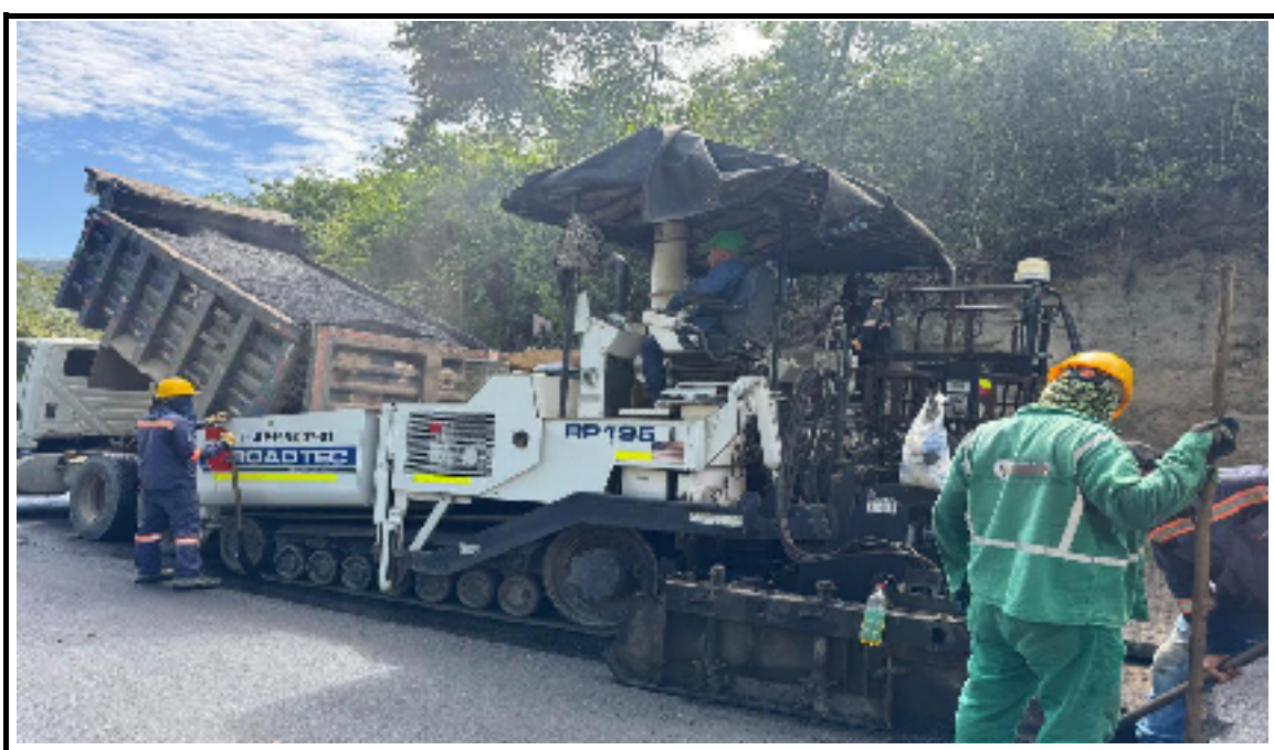
Foto 6. Instalación de concreto cunetas km 24+220 - Tramo 2
