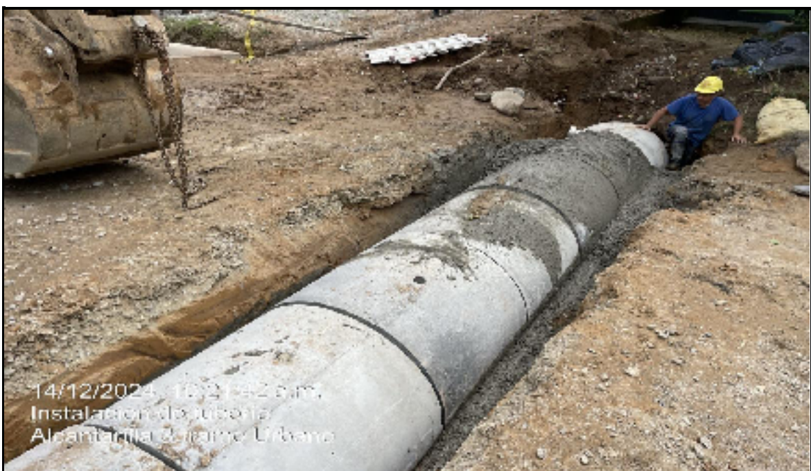
Foto 8. Instalación de tubería alcantarilla paso urbano km 37+666 - Tramo 2
