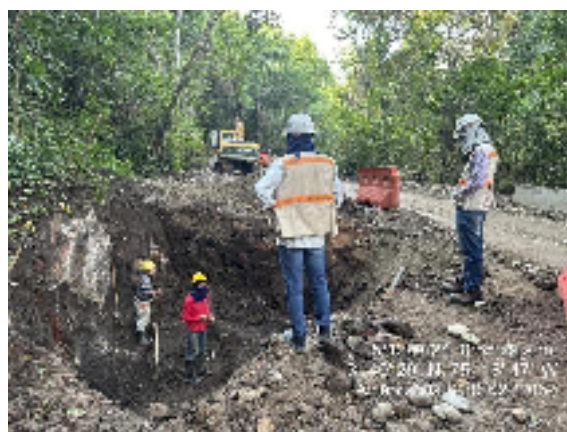
Fotografía 10. Verificación obras Tramo 1 Coyaima - Ataco
