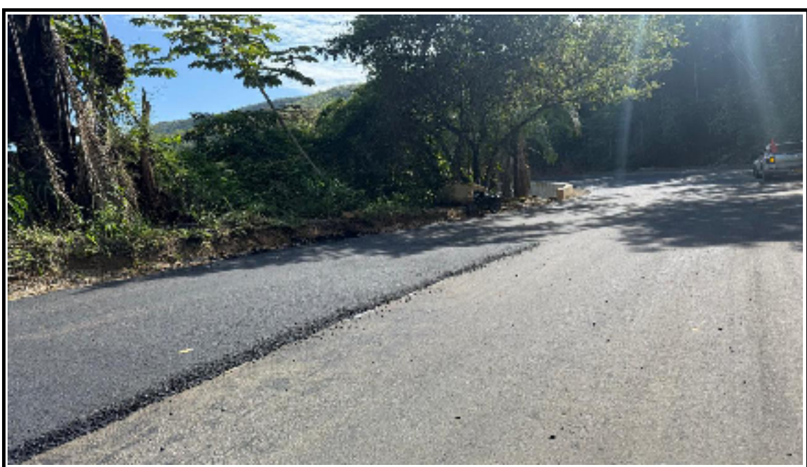
Foto 2. Instalación de base granular km 21+520 - Tramo 1
