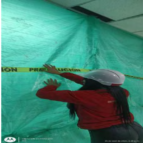
Señalización de obra
