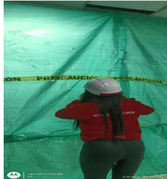
Señalización de obra
