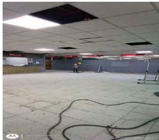
Actividades de obra
