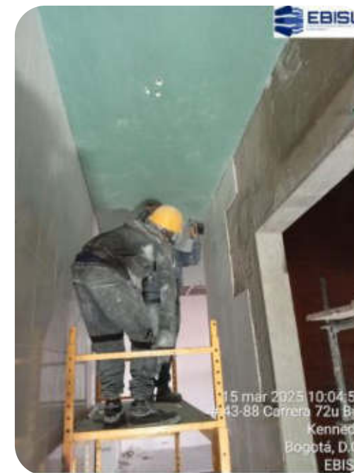
Instalación de cielo raso en cocina
