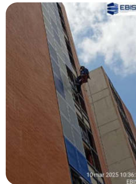
Instalación de malla microperforada fachada occidental
