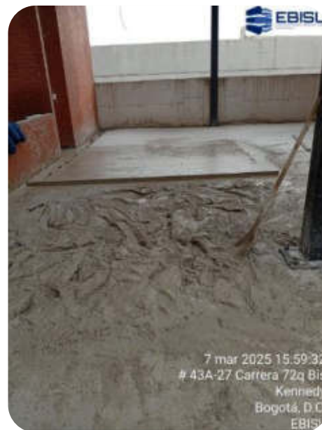
Alistado de piso impermeable cubierta
