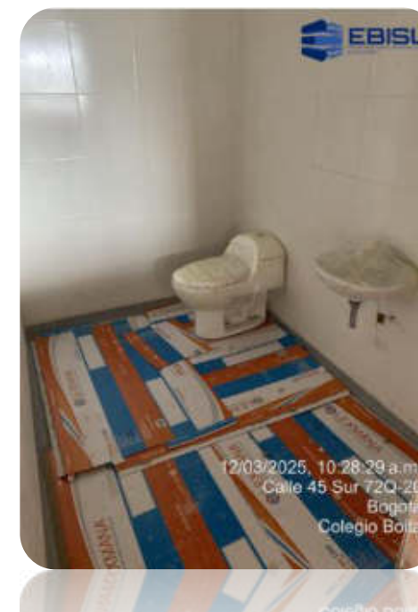
Instalación de aparatos sanitarios
