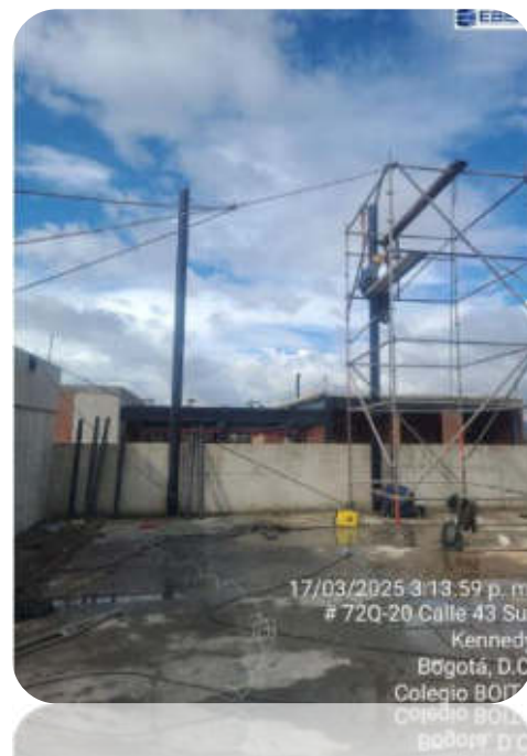
Instalación de estructura metálica para cerramiento de canchas
