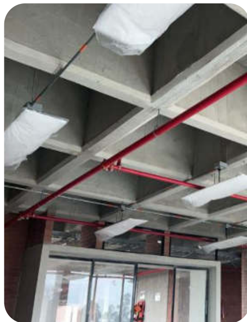
Instalación de luminarias
