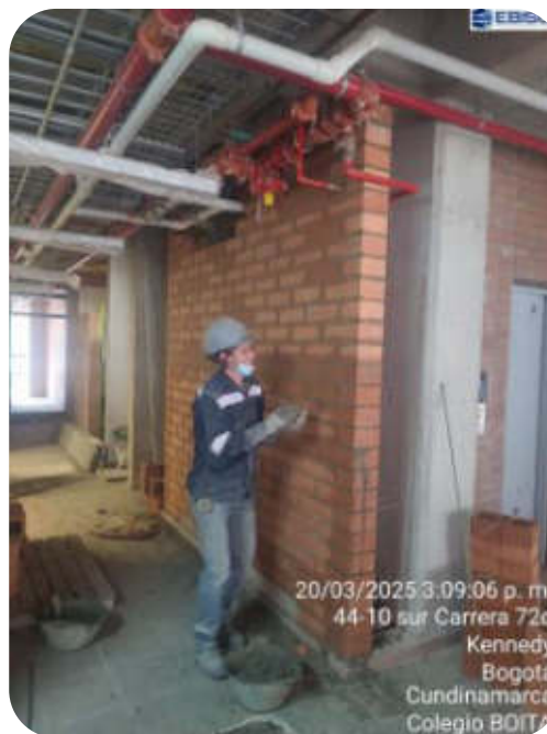
Muros de mampostería para ductos
