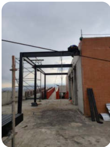
Instalación de estructura metálica cubierta
