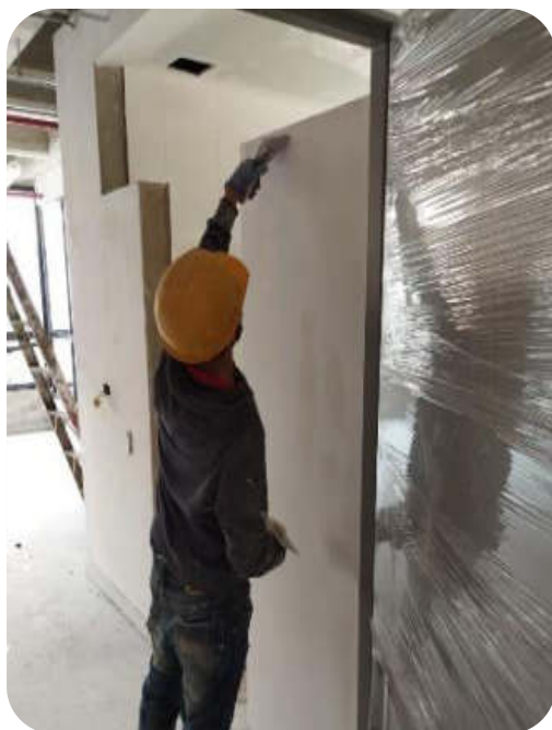
Pintura sobre muros de mampostería
