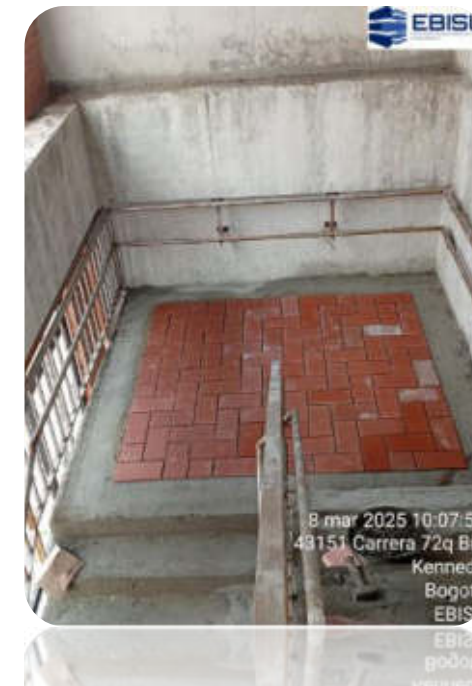
Enchape de escalera auxiliar en tablón de gres
