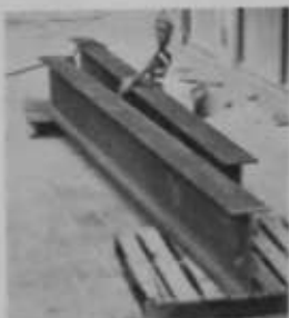
VIGA A IZAR
