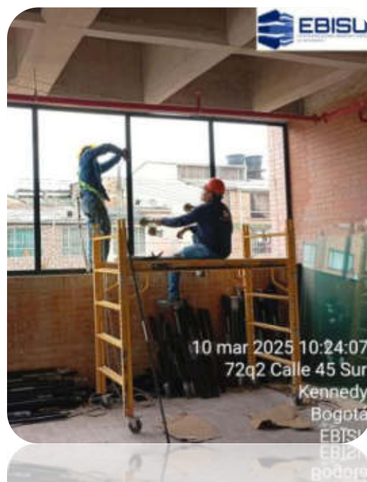
Instalación de ventanearía área de administración
