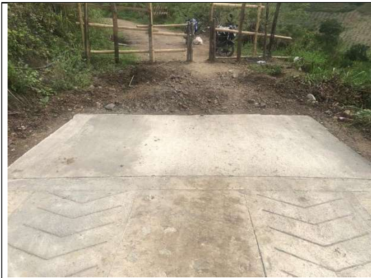
Fundida de rampa de acceso placa huella
