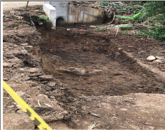
Excavación para muro de contención
