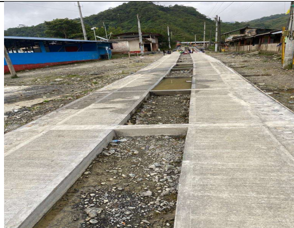
Fundida de concreto de 21 Mpa
