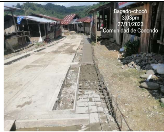
Fundida de concreto de 21 Mpa para cunetas
