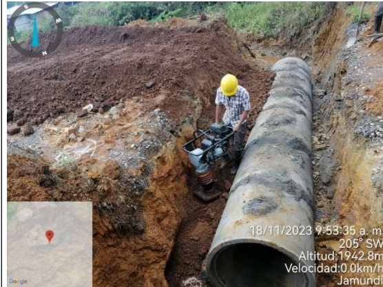
Foto 8 Compactación de material de suelo
