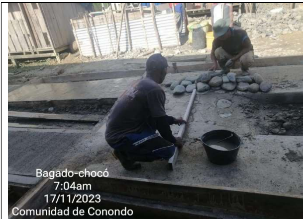
Fundida de concreto ciclópeo
