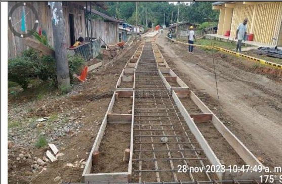
Instalación de acero de refuerzo y formaleta
