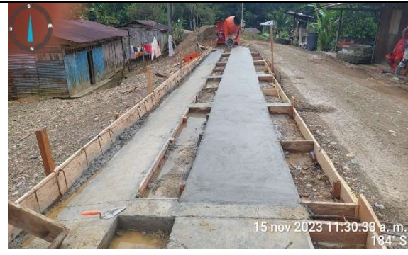
Fundida de concreto de 21 Mpa
