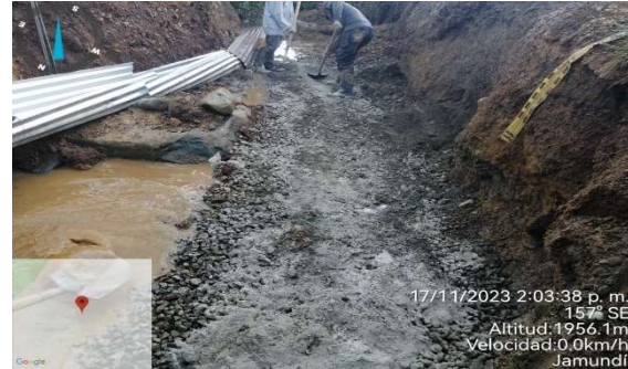
Foto 2 Fundida de concreto de Limpieza
