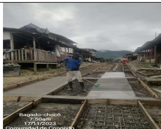
Fundida de concreto de 21 Mpa
