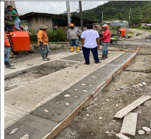
Fundida de concreto ciclópeo
