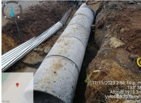
Foto 1 Instalación de Tubería alcantarilla 1
