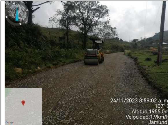
Foto 7 Compactación de SBG
