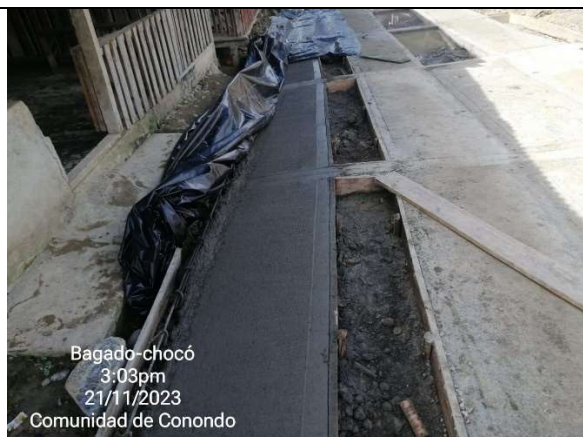
Fundida de concreto de 21 Mpa para cunetas
