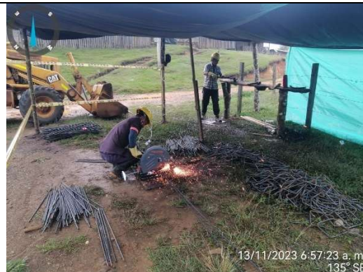
Foto 4 corte y figurado de acero
