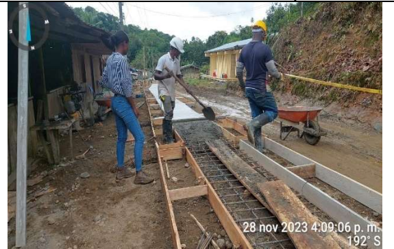
Fundida de concreto de 21 Mpa
