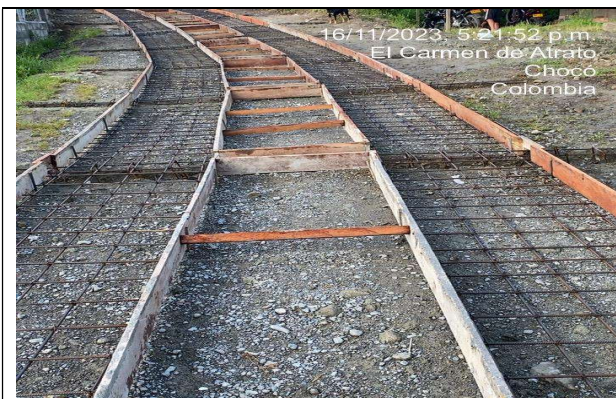
Instalación de acero de refuerzo y formaleta
