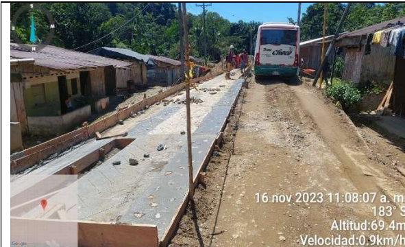
Fundida de concreto ciclópeo
