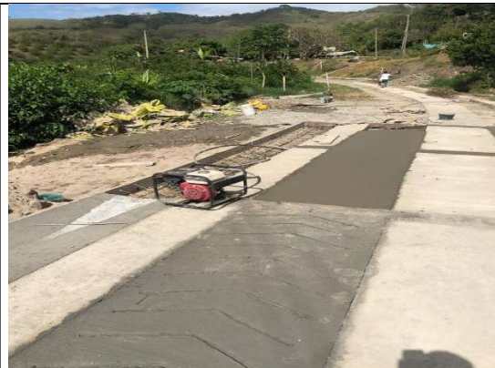
Fundida de concreto de huella de 3000 PSI
