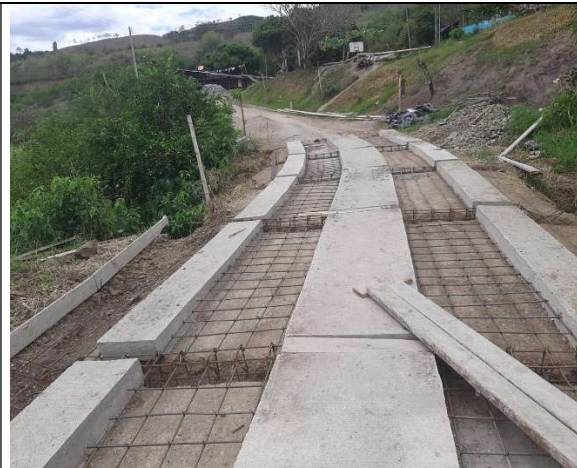
Instalación de acero de refuerzo
