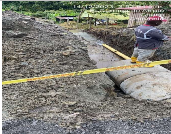
Instalación de concreto reforzado
