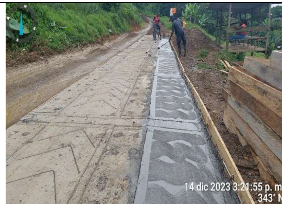
Fundida de concreto de cunetas
