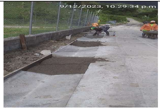
Fundida de concreto para cunetas
