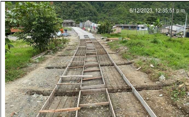
Instalación de acero de refuerzo y formaleta
