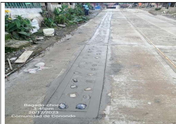
Fundida de concreto ciclopeo
