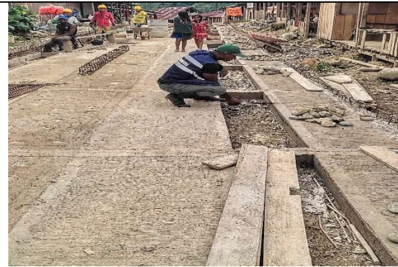
Fundida de concreto de 21 Mpa para cunetas
