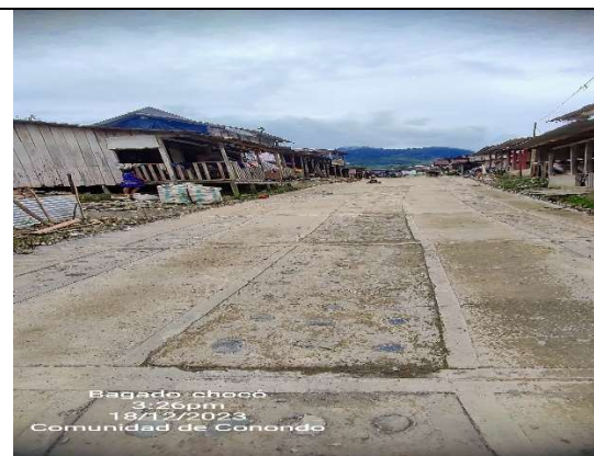
Fundida de concreto de 21 Mpa
