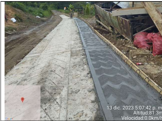
Fundida de concreto de cunetas
