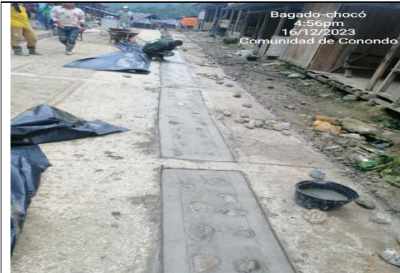
Fundida de concreto ciclópeo
