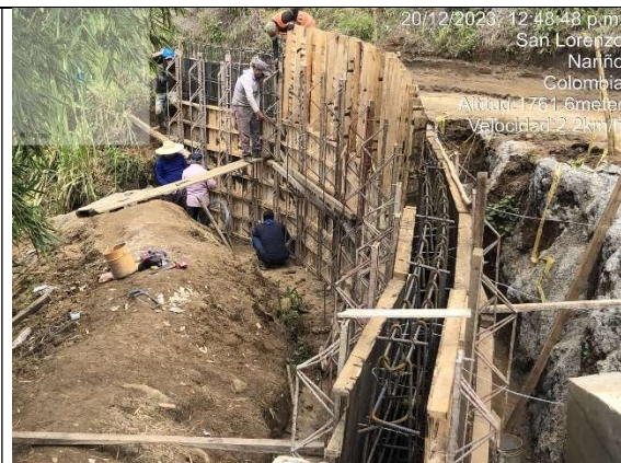
Fundida de concreto de muro de contención de 3000 PSI
