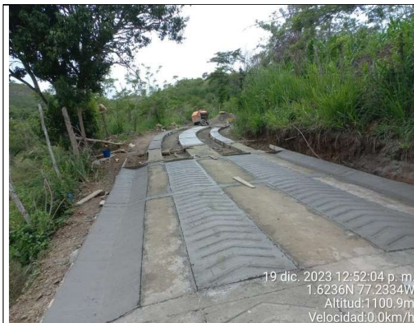
Fundida de concreto de huella
