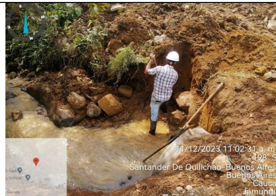
Adecuación de descole alcantarilla
