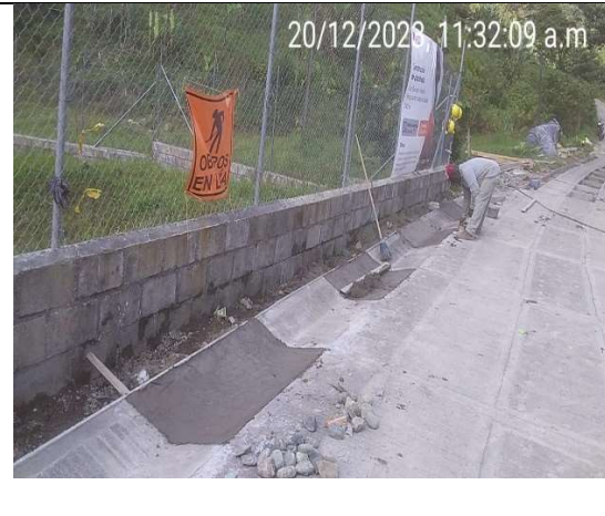
Fundida de concreto para cunetas
