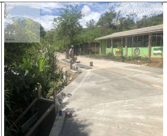
Fundida de cunetas
