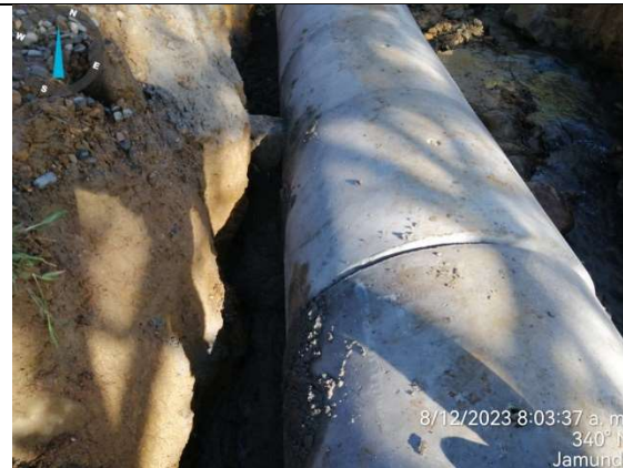
Fundida de atraque alcantarilla #2
