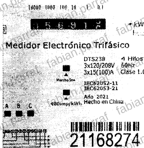
MEDIDOR ENERGÍA TABLERO PRIMER PISO
