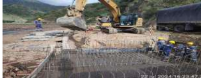
Encofrado y fundida de losa carril izq. de apoyo de tubería de alcantarilla del PR51+0440. Instalación de tubería de 36" de batería de alcantarillas en el PR51+0445.
