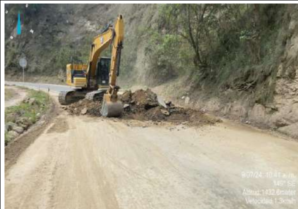
Fotografía 4: Excavación de pavimento en el PR52+0370 al PR52+0420.
