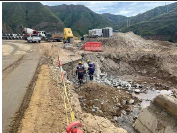
Fotografía 1: Demolición del muro para la construcción de alcantarilla en el PR 51+440.
