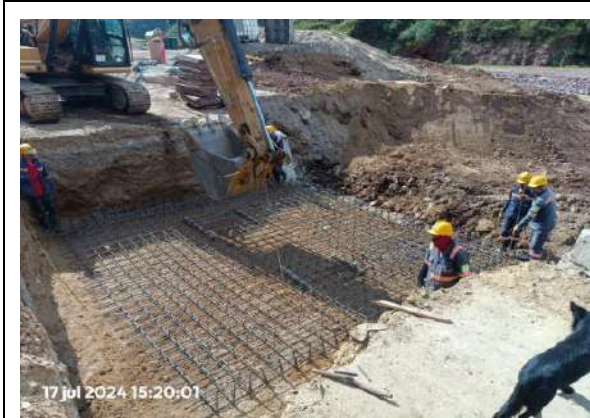
Fotografía 3: Instalación de parrilla de acero para losa de base de la tubería frente PR51+0440.
