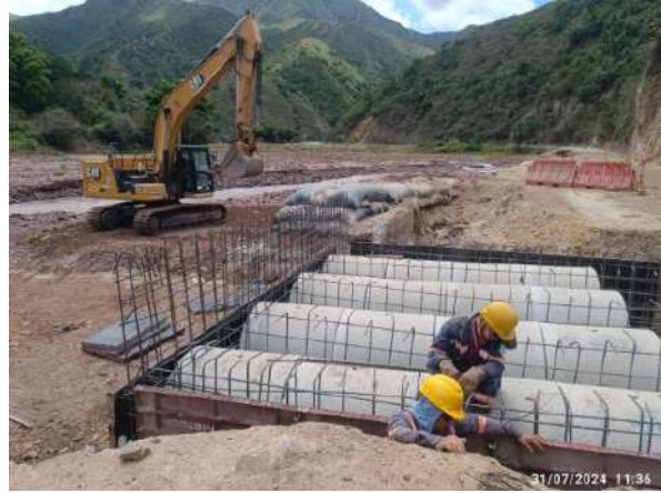
Fotografía 6: Instalación de acero y encofrado de alcantarilla en el PR51+0445.
