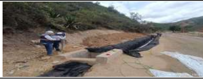
Construcción de filtro de 0,80x0,20m en el PR52+200. Instalación de geotextiles en el frente del PR51+0500.
