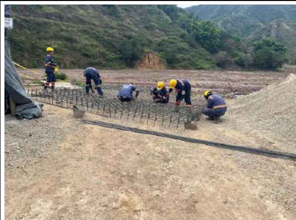
Fotografía 2: Armado de acero para losa de base de alcantarilla del PR51+440.
