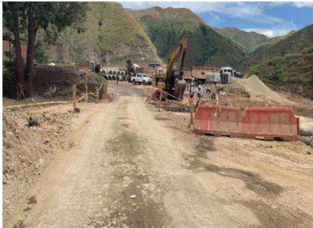
Imagen 1. Áreas de intervención maquinaria y equipos. Personal en obra 51+0445 MI RN7008.
