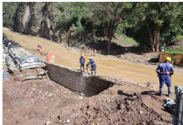
Fotografía 3: Demolición del muro para la construcción de alcantarilla en el PR 51+440.
