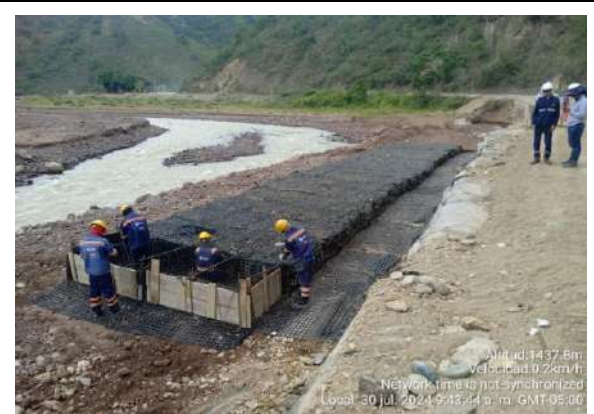
Fotografía 4: Instalación de geoesteras en el frente del PR51+0500.
