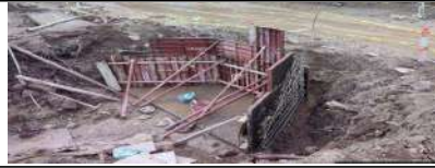
Armado de acero y encofrado de abutamiento de alcantarilla del PR52+241.
