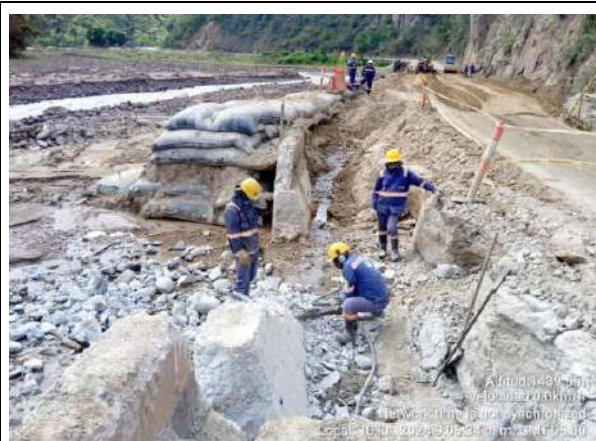
Fotografía 2: Demolición del muro para la construcción de alcantarilla en el PR 51+440.
