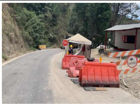
Fotografía 8: Control vial en los puentes Tarra y Turco.
