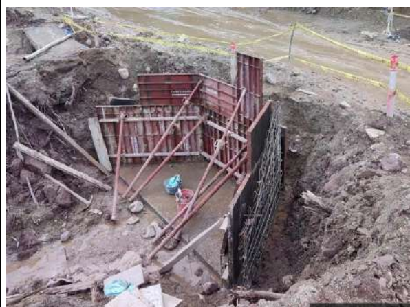
Fotografía 2: Encofrado de aletas de alcantarilla del PR52+241.
