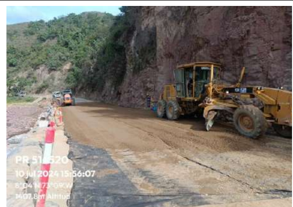
Fotografía 3: Instalación de base granular frente PR51+0500.
