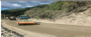
Cerco de base granular en el frente del PR52+200. Instalación de geosteras en el frente del PR51+0500.
