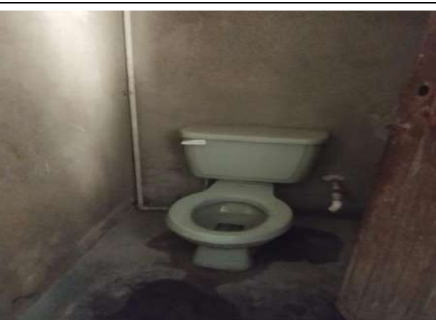
Imagen 12. Inspección sanitario ubicado en PR 50+700 MI.
