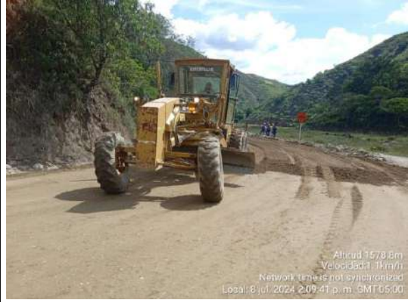
Fotografía 6: Instalación de material estabilizado con cemento para terraplén.
