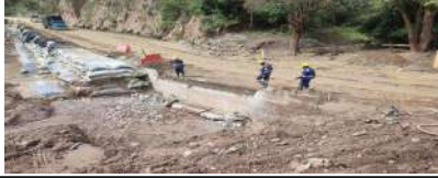
Demolición del muro para la construcción de alcantarilla en el PR 51+440, Limpieza de cabecera en PR 51+0440.
