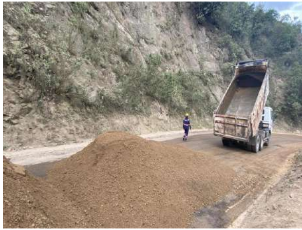
Fotografía 6: Instalación de material estabilizado con cemento para terraplén PR52+370.
