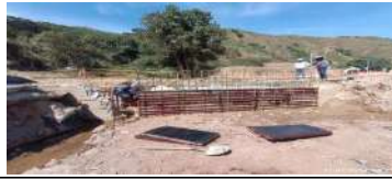
Instalación de geosteras en el frente del PR51+0500. Instalación de acero y encofrado de alcantarilla en el PR51+0445.
