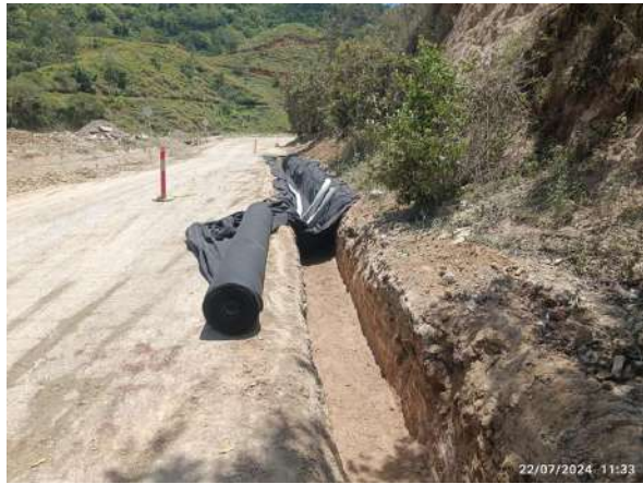
Fotografía 1: Construcción de filtro de 0.80x0.80m en el PR52+200.
