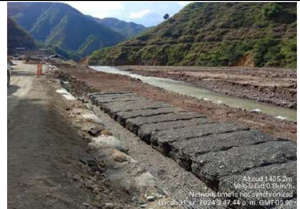
Fotografía 3: Instalación de geoesteras en el frente del PR51+0500.
