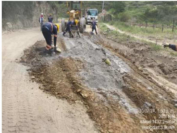
Fotografía 5: Instalación de material estabilizado con cemento para terraplén.
