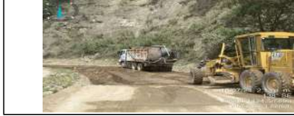
Construcción de filtro de 6,80x0,80m en el PR52+270. Instalación de material estabilizado con cemento y base granular para terraplen PR52+370.
