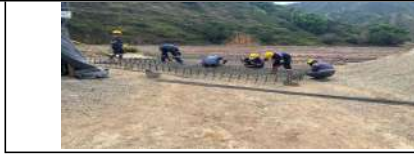
Demolición del muro para la construcción de alcantarilla en el PR 51+440. Instalación de parrilla de acero para base de la tubería frente PR51+0440.
