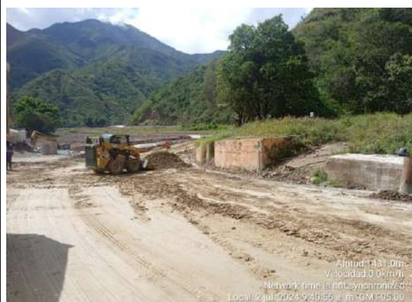
Fotografía 4: Demolición del muro para la construcción de alcantarilla en el PR 51+440.
