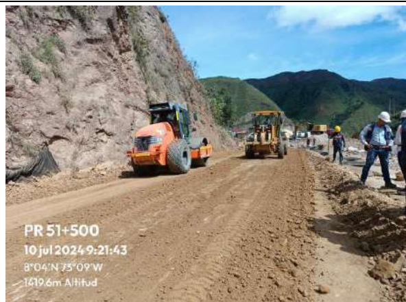
Fotografía 1: Instalación de material y cereo de terraplén estabilizado con cemento en el frente PR51+0500.
