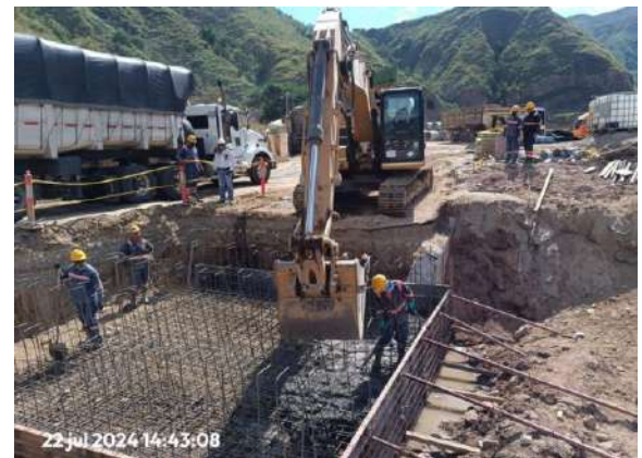
Fotografía 3: Encofrado y fundida de losa carril izq. de apoyo de tubería de alcantarilla del PR51+0440.
