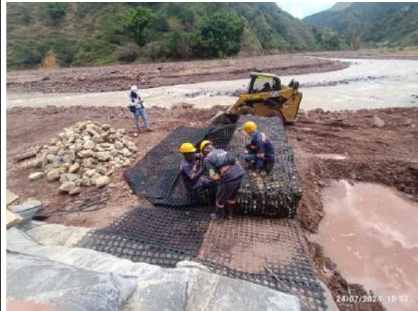
Fotografía 6: Instalación de geoesteras en el frente del PR51+0500.
