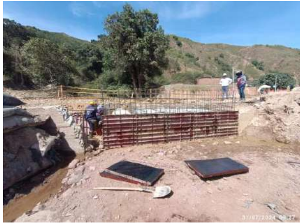
Fotografía 5: Instalación de acero y encofrado de alcantarilla en el PR51+0445.
