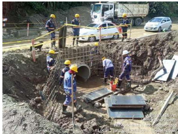
Fotografía 1: Amarre de acero de aletas de alcantarilla del PR52+241.
