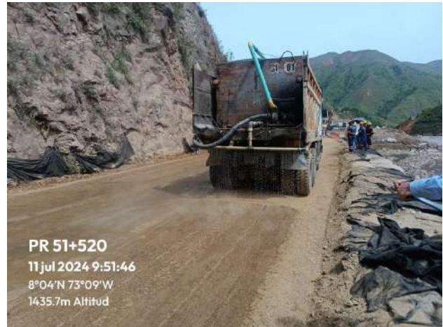
Imagen 2. Humectación de la vía PR51+0520
