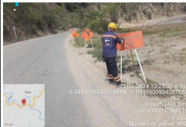
Imagen 13. Limpieza de señalización aproximación frente de obra.
