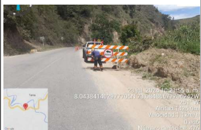
Imagen 14. Instalación de señal de desvío frente de obra.
