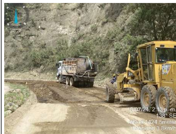
Fotografía 5: Instalación de material estabilizado con cemento para terraplén PR52+370.
