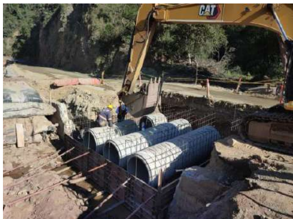
Fotografía 5: Instalación de tubería de 36" de batería de alcantarillas en el PR51+0445.
