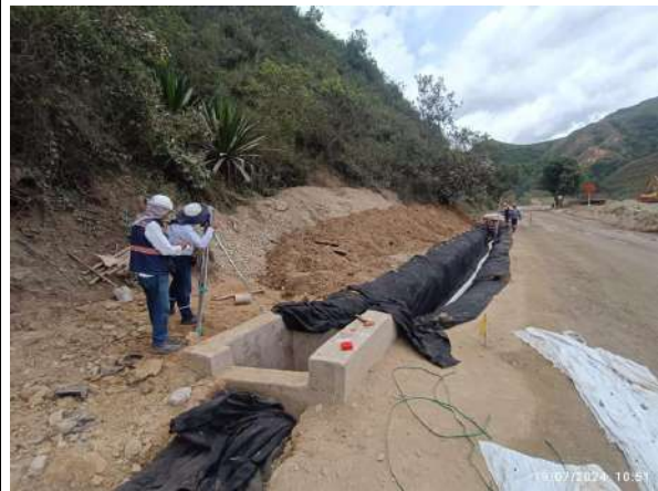
Fotografía 2: Construcción de filtro de 0.80x0.80m en el PR52+200.
