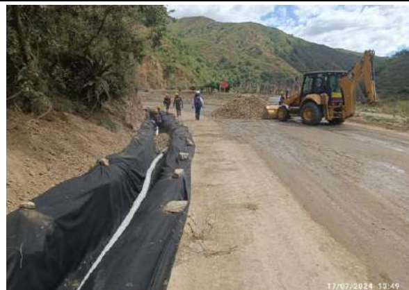
Fotografía 4: Construcción de filtro de 0.80x0.80m en el PR52+270.
