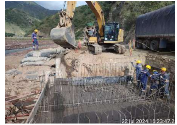
Fotografía 4: Encofrado y fundida de losa carril izq. de apoyo de tubería de alcantarilla del PR51+0440.
