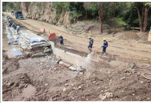
Fotografía 4: Demolición del muro para la construcción de alcantarilla en el PR 51+440.
