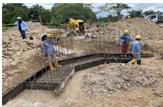
Figura 5. 2024-05-21. Instalación de acero de refuerzo en las abscisas K2+845, K2+645, K1+845, K1+645, K1+445.
