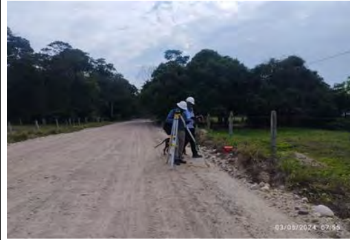
Figura 2. 2024-05-03. Verificación de niveles del K6+560 al K7+320.
