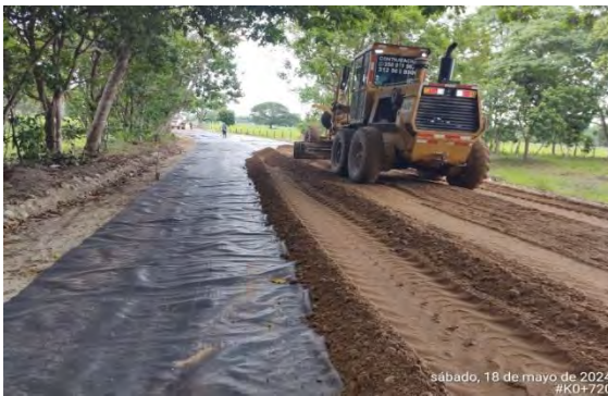
Figura 5. 2024-05-18. Instalación de sub-base granular clase A SBG-50 desde el K0+630; K0+680 hasta K1+160; K1+200 hasta K1+270, K1+400 hasta K1+510
