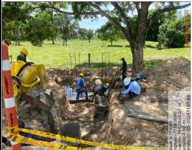
ELABORACION DE ESPECIMENS DE CONCRETO DEL ELEMENTO ESTRUCTURAL ZAPATAS DE ALCANTARILLA LOCALIZADA EN EL PR2+225
