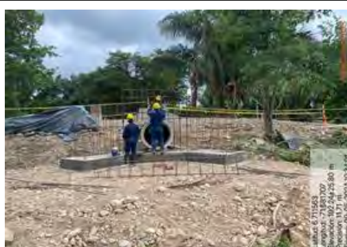
Figura 2. 2024-05-09. Instalación de acero de refuerzo en las abscisas K2+445, K2+225, K2+031, K1+845, K1+645
