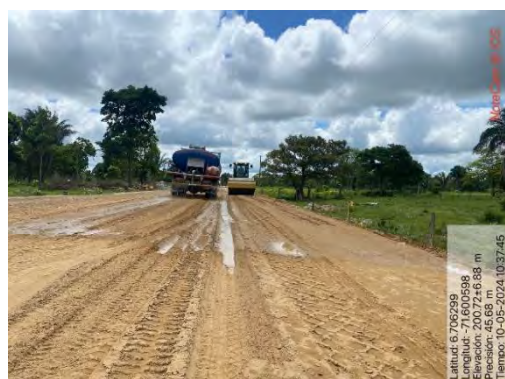
Figura 4. 2024-05-10. Construcción de terraplén (arena limosa) del K1+300 al K1+845 margen derecho.
