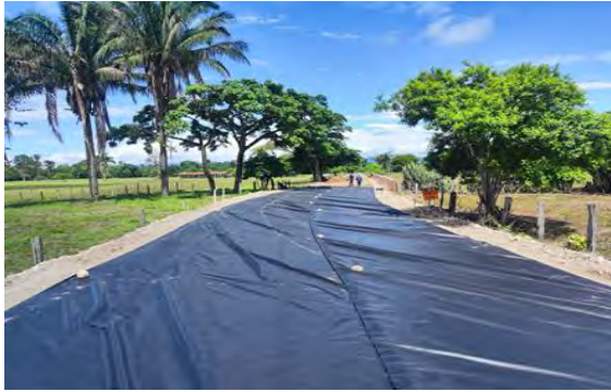
Figura 7. 2024-05-17. Instalación de geotextil para separación de suelos de subrasante y capas granulares desde el K0+260 hasta K0+630; K0+680 hasta K1+160; K1+200 hasta K1+270, K1+400 hasta K1+510.
