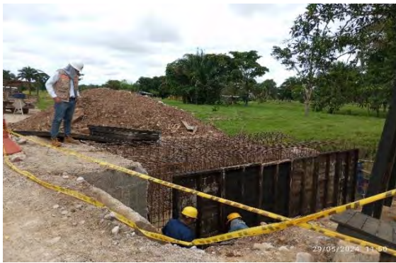
Figura 9. 2024-05-29. Instalación de acero de refuerzo y formaleta en la abscisa K2+031 Box culvert.
