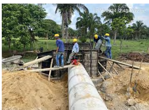
Figura 6. 2024-05-17. Vaciado de concreto reforzado de 21 Mpa para construcción de obras de drenaje en la abscisa K2+845.
