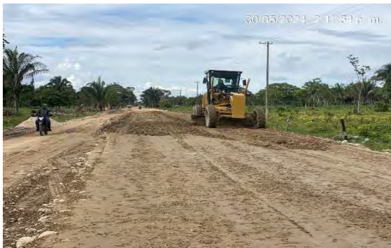
Figura 11. 2024-05-30. Construcción de terraplén (arena limosa) del K0+345 a la K0+756 margen derecho e izquierdo.
