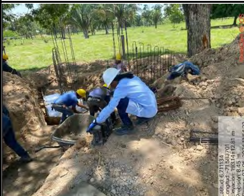
ELABORACION DE ESPECIMENS DE CONCRETO DEL ELEMENTO ESTRUCTURAL MUROS Y ALETAS DE ALCANTARILLA LOCALIZADA EN EL PR2+225
