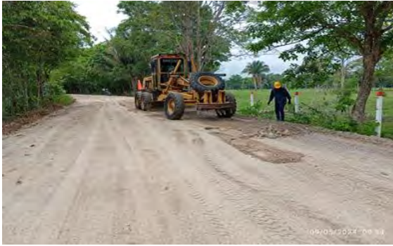
Figura 1. 2024-05-09. Mejoramiento de la subrasante con adición de materiales desde el K6+560 al K7+320.
