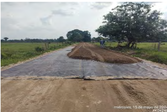
Figura 3. 2024-05-15. Instalación de geotextil para separación de suelos de subrasante y capas granulares desde el K0+020 al K0+260.
