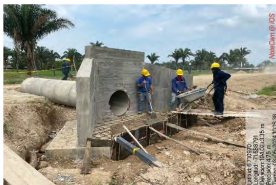
Figura 3. 2024-05-03. Vaciado de concreto reforzado de 21 Mpa para construcción de obras de drenaje K2+445.
