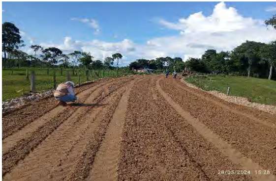
Figura 9. 2024-05-28. Instalación de sub-base granular clase A SBG-50 desde el K0+630; K0+680 hasta K1+160; K1+200 hasta K1+270, K1+400 hasta K1+510.
