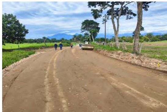
Figura 10. 2024-05-28. Instalación de sub-base granular clase A SBG-50 desde el K0+630; K0+680 hasta K1+160; K1+200 hasta K1+270, K1+400 hasta K1+510.
