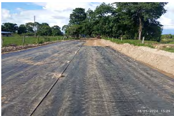
Figura 11. 2024-05-28. Instalación de geotextil para separación de suelos de subrasante y capas granulares desde el K0+260 hasta K0+630; K0+680 hasta K1+160; K1+200 hasta K1+270, K1+400 hasta K1+510.
