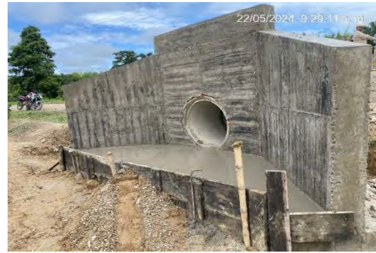
Figura 8. 2024-05-22. Vaciado de concreto reforzado de 21 Mpa para construcción de obras de drenaje en la abscisa K2+645.
