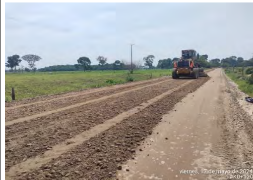
Figura 6. 2024-05-17. Instalación de sub-base granular clase A SBG-50 desde el K0+630; K0+680 hasta K1+160; K1+200 hasta K1+270, K1+400 hasta K1+510.
