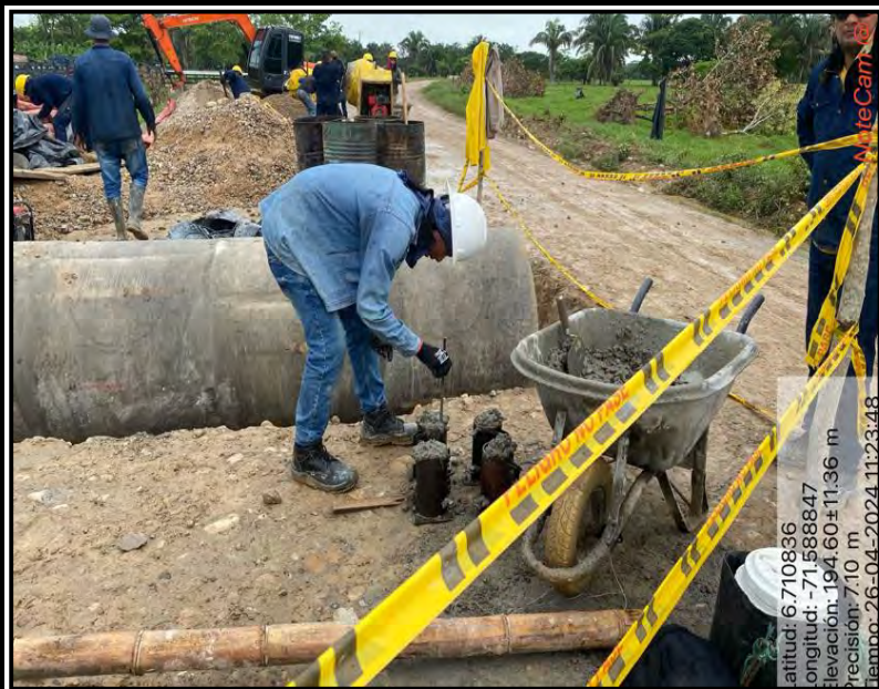
ELABORACION DE ESPECIMENS DE CONCRETO DEL ELEMENTO ESTRUCTURAL MUROS Y ALETAS DE ALCANTARILLA LOCALIZADA EN EL PR1+645
