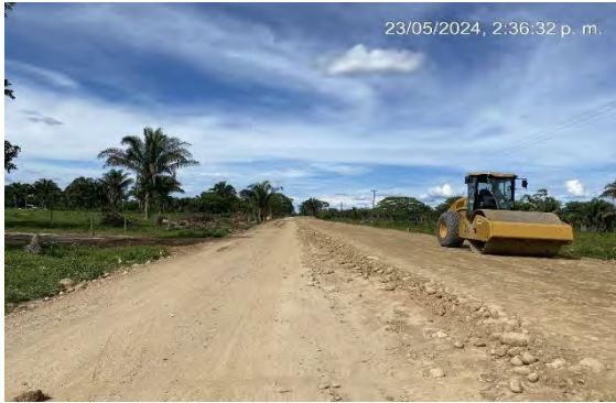
Figura 7. 2024-05-23. Construcción de terraplén (arena limosa) del K1+645 AL K1+845 margen derecho.
