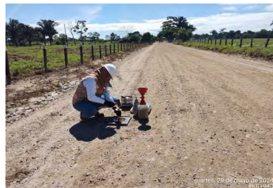
Figura 12. 2024-05-28. Ensayo de densidad de campo con el cono de arena.
