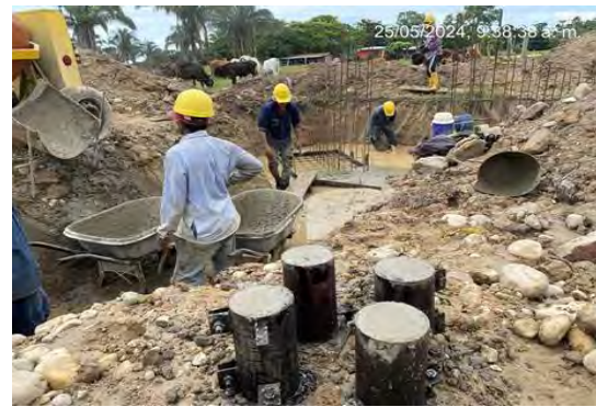
Figura 10. 2024-05-25. Vaciado de concreto reforzado de 21 Mpa para construcción de obras de drenaje en la abscisa K2+031.
