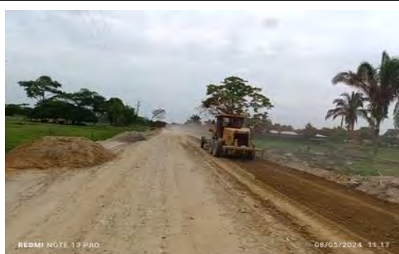
Figura 1. 2024-05-05. Construcción de terraplén (arena limosa) del K1+220 al K1+645
