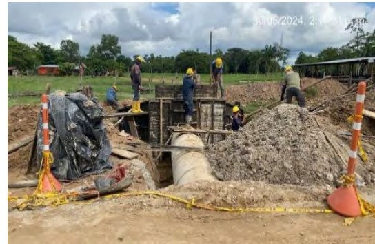
Figura 12. 2024-05-30. Vaciado de concreto reforzado de 21 Mpa para construcción de obras de drenaje en las abscisas K1+645.
