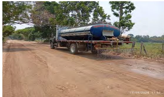
Humectación de vía para mitigar generación de material particulado
