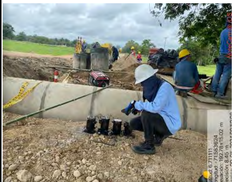
ELABORACION DE ESPECIMENS DE CONCRETO DEL ELEMENTO ESTRUCTURAL MUROS Y ALETAS DE ALCANTARILLA LOCALIZADA EN EL PR2+225
