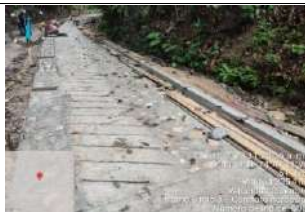
Suministro e instalación de concreto de 21 Mpa para placa huella K00+00 hasta K00+21 tramo Puente Frio
