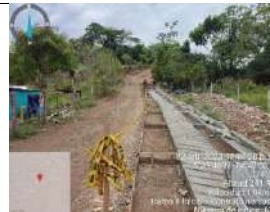
Suministro e instalación de concreto de 21 Mpa para placa huella K00+00 hasta K00+22 Tramo Quebrada la Esperanza
