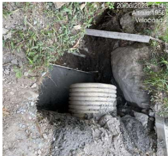
Instalación de solado de limpieza de la estructura de salida de la obra Transversal No 2 al Inicio del Tramo de San Gerardo.
