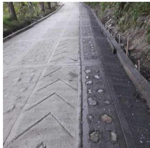
Construcción e Sección de cuneta y Bordillo MD en el Tramo de San Gerardo k8+150
