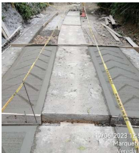
construcción de Huella de la sección de Placa huella k12+710 - La Maporita 1
