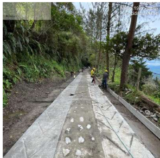
Construcción e Sección de cuneta y Bordillo MD en el Tramo de San Gerardo k8+130
