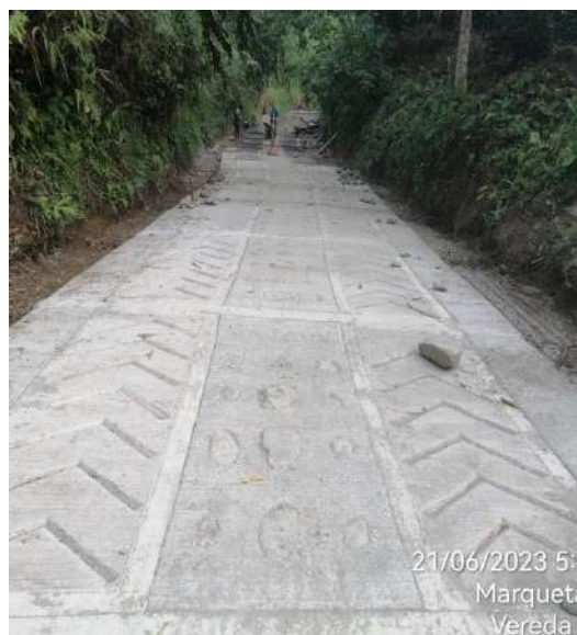
reconformación de capa de subbase granular de la sección de cuneta de la Placa huella k12+730 - La Maporita 1
