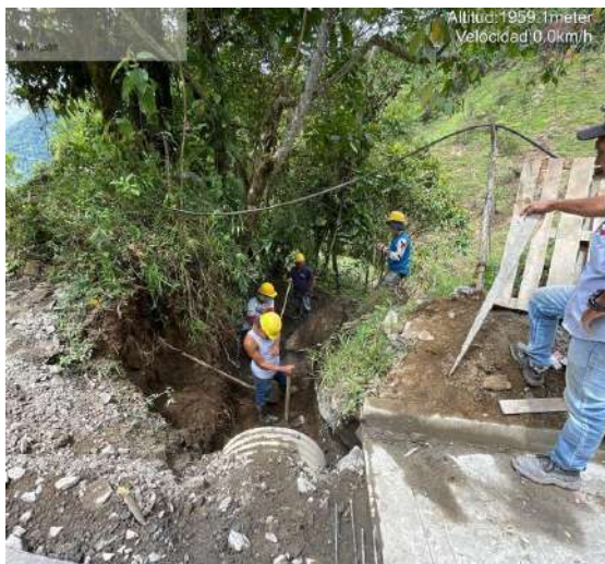
Excavación para construcción de estructura de salida de la obra Transversal No 2 al Inicio del Tramo de San Gerardo
