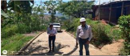
Se realizo visita de obra por parte de INVIAS a los tramos terminados y el tramo No 1 que se esta trabajando.
