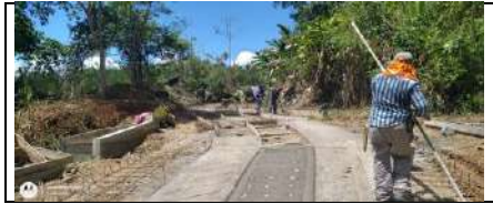
El contratista realiza la fundida de placa huella y centros en ciclopeo en concreto de 21 Mpa y 14 Mpa en el tramo No 1 L= 153 metros K2+166 K2+219
