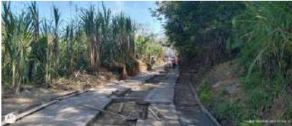
El contratista realiza la fundida de placa huella y centros en ciclopeo en concreto de 21 Mpa y 14 Mpa en el tramo No 1 L= 224 metros K2+166 K2+390
