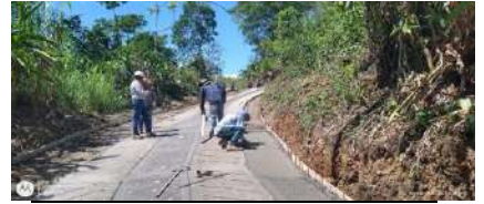
el contratista realiza la fundida para cuneta en concreto de 21 Mpa en el tramo No 2 en una longitud de 50 mt
