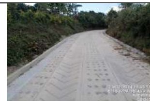
Bellavista se funden 30 metros de cunetas y se 40 metros de bordillo
