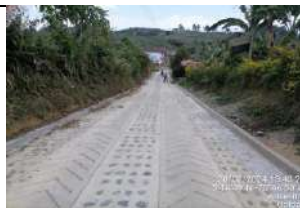
Bellavista se funden 30 metros de cunetas y se 40 metros de bordillo
