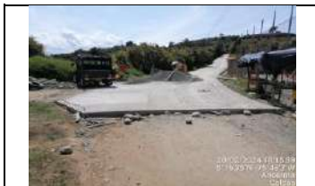
Bellavista se funden 30 metros de cunetas y se 40 metros de bordillo
