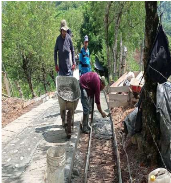
El contratista realiza la fundida para placa huella en concreto de 21 Mpa en el tramo No 3 - 25 mt K4+761 - k4+786
