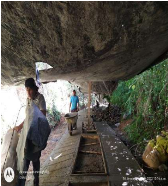
El contratista realiza la fundida para placa huella en concreto de 21 Mpa en el tramo No 3 58 mt K4+589 - K4+647
