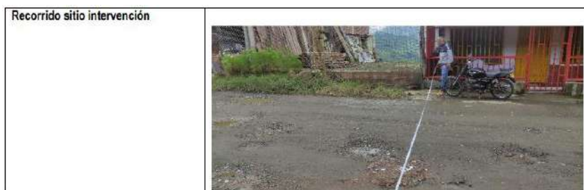
Imagen No.3 Tramo I Vereda el Pensil
