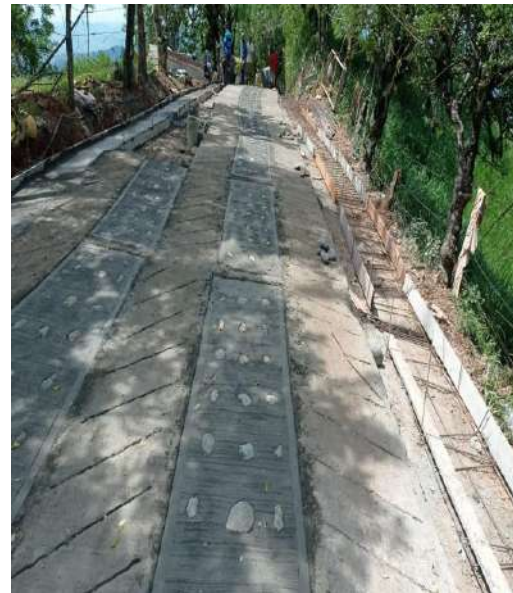
El contratista realiza la fundida para cuneta en concreto de 21 Mpa en el tramo No 3 - 25 mt K4+761 - k4+786
