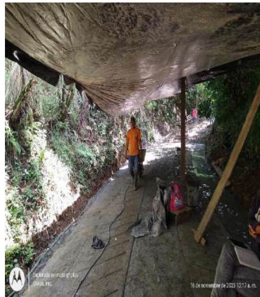
El contratista realiza la fundida para cuneta en concreto de 21 Mpa en el tramo No 3 58 mt K4+589 - K4+647
