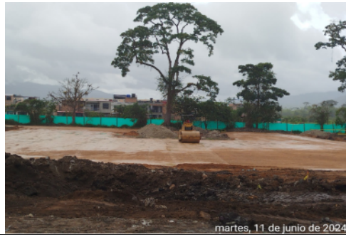
Instalación y compactación de relleno Tercera y Cuarta Capa Módulos Biblioteca, Laboratorio Aulas TIC y Restaurante/Aula Múltiple
