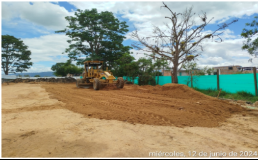
Fotografía No 19: Instalación y compactación de relleno Tercera y Cuarta Capa Módulos Biblioteca, Laboratorio Aulas TIC y Restaurante/Aula Múltiple
