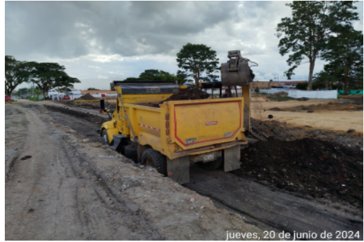
Cajeo Calle Primera y Retiro de material sobrante
