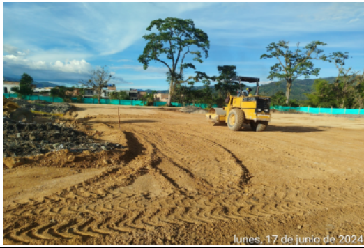
Instalación y compactación de relleno Tercera, Cuarta y Quinta Capa Módulos Biblioteca, Laboratorio Aulas TIC y Restaurante/Aula Múltiple
