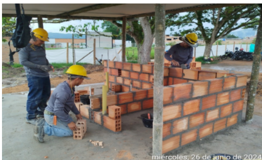
Fotografía No 43: INSTALACIÓN DE MAMPOSTERIA PARA BATERIAS SANITARIAS DE CAMPAMENTO
