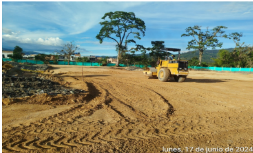
Fotografía No 29: Instalación y compactación de relleno Tercera, Cuarta y Quinta Capa Módulos Biblioteca, Laboratorio Aulas TIC y Restaurante/Aula Múltiple
