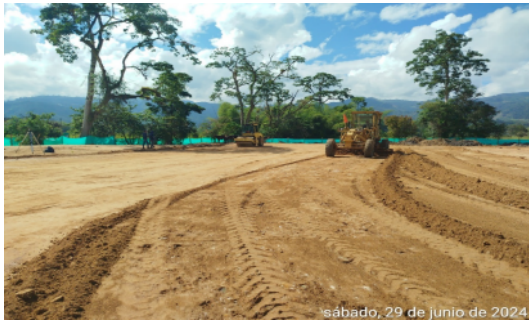
Fotografía No 37: MODULOS BIBLIOTECA, LABORATORIOS Y AULAS TIC: Se realizó nivelación y seriado de estos módulos
