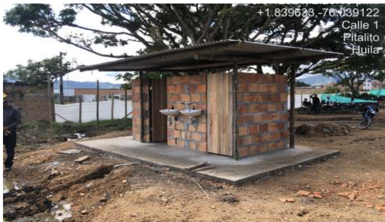
CONSTRUCCION DE BATERIAS SANITARIAS PARA EL PERSONAL
