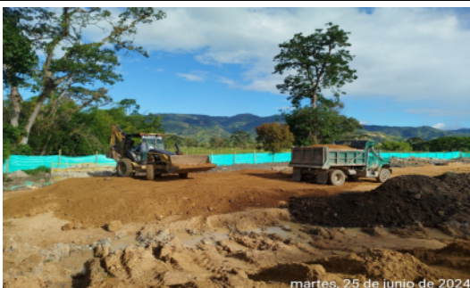
Fotografía No 45: ZONAS DURAS: Se dio inicio con el relleno y compactación en las áreas internas de circulación peatonal y zonas de concentración que se proyectan como zonas duras.
