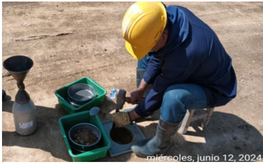
Fotografía No 21: Toma de densidades de Terreno para chequeo de grado de compactación (Contratista de Obra)
