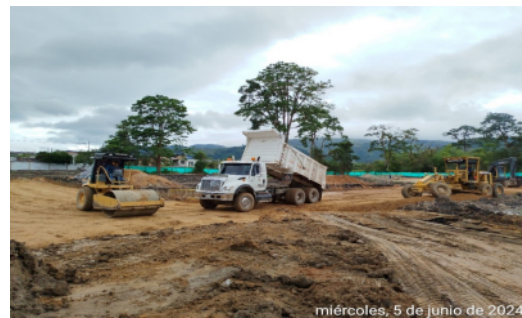
Fotografía No 5: INSTALACIÓN Y COMPACTACIÓN DE RELLENO: BLOQUE DE BIBLIOTECA, LABORATORIOS, AULAS TIC, Y AULA MÚLTIPLE
