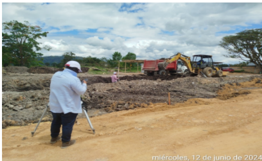
Fotografía No 17: Cajeo Calle Primera y Retiro de material sobrante
