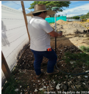
Fotografia No 39: CHEQUEOS TOPOGRAFICOS POR PARTE DE INTERVENTORIA
