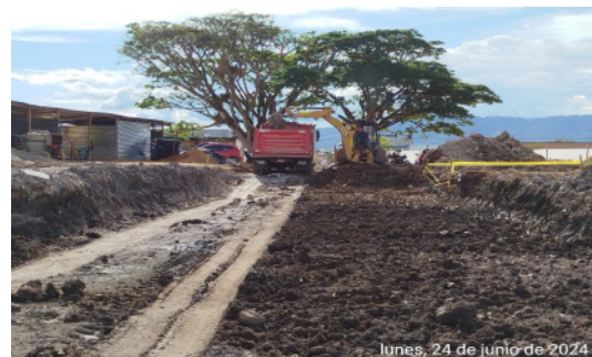
Fotografia No 42: Cajeo Calle Primera y Retiro de material sobrante. Control Topográfico
