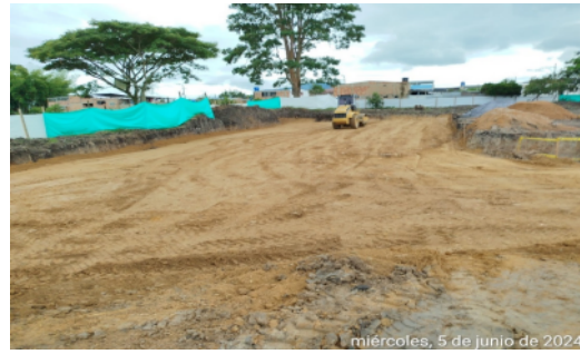
Fotografía No 6: INSTALACIÓN Y COMPACTACIÓN DE RELLENO: MODULO AULAS PRIMER PISO
