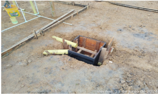
Fotografia No 37: ACTIVIDADES PARA CONSTRUCCIÓN DE BAÑOS CAMPAMENTO
