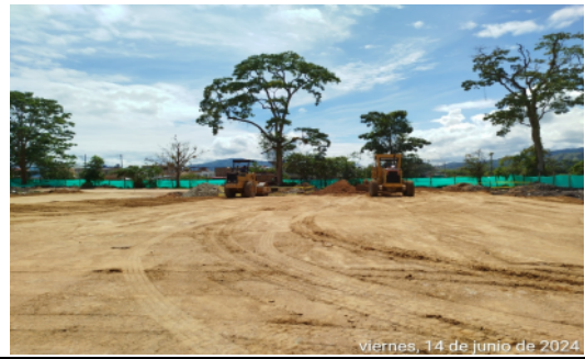
Fotografía No 20: Instalación y compactación de relleno Tercera y Cuarta Capa Módulos Biblioteca, Laboratorio Aulas TIC y Restaurante/Aula Múltiple
