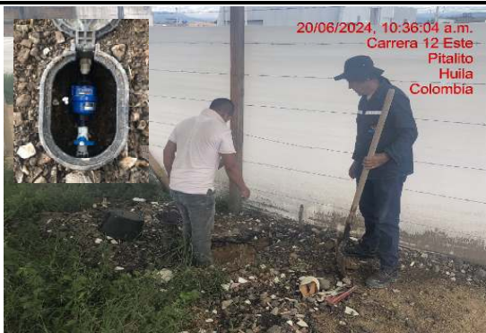
a.1. Agua potable - Instalacion red EMPITALITO
