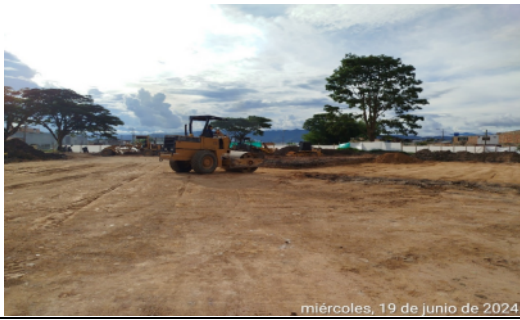
Fotografía No 31: Instalación y compactación de relleno Tercera, Cuarta y Quinta Capa Módulos Biblioteca, Laboratorio Aulas TIC y Restaurante/Aula Múltiple
