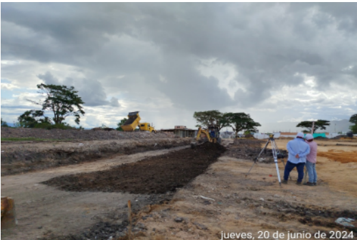
Cajeo Calle Primera y Retiro de material sobrante. Control Topográfico
