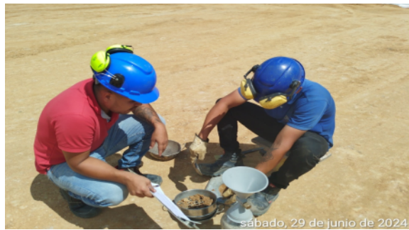
Fotografía No 39: TOMA DE DENSIDADES DE TERRENO A LOS RELLENOS POR PARTE DE INTERVENTORIA
