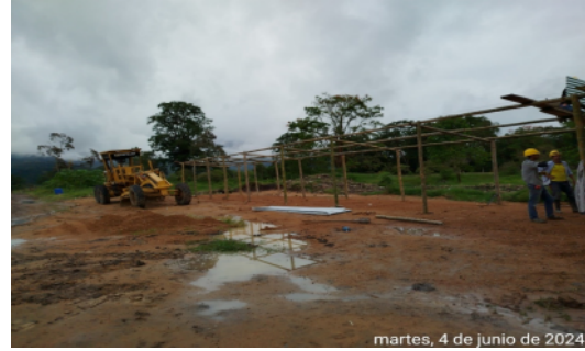
Fotografía No 2: INSTALACIÓN DE TEJAS DE ZINC PARA CUBIERTA DE CAMPAMENTO
