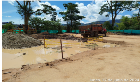
Fotografia No 38: EXTRACCIÓN DE AGUAS LLUVIAS CONTENIDAS EN POZOS DE ACHIQUE
