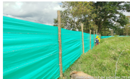
Fotografía No 22: Instalación de lona y alambre de púa - Cerramiento Provisional
