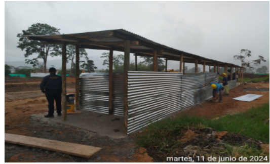
Fotografía No 14: INSTALACIÓN DE TEJAS EN ZINC PARA DIVISIONES DE CAMPAMENTO
