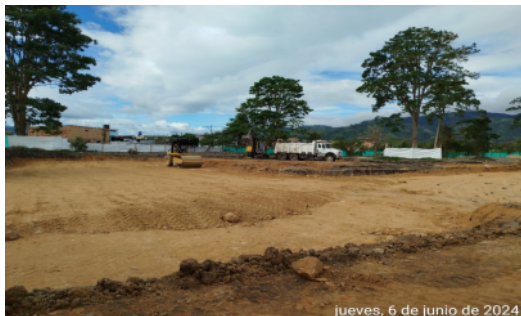
Fotografía No 7: INSTALACIÓN Y COMPACTACIÓN DE RELLENO: MODULO AULAS PRIMER PISO
