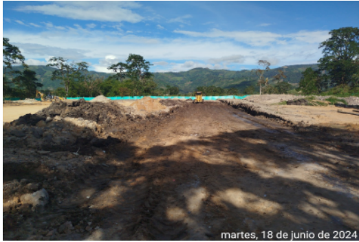
Cajeo Calle Primera y Retiro de material sobrante
