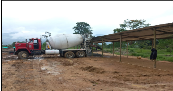
Fotografía No 12: FUNDIDA DE CONCRETO PARA PISO DE CAMPAMENTO
