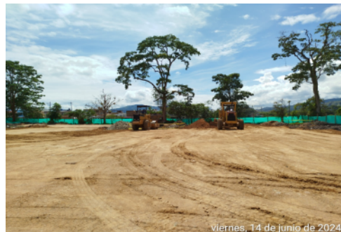
Instalación y compactación de relleno Tercera y Cuarta Capa Módulos Biblioteca, Laboratorio Aulas TIC y Restaurante/Aula Múltiple
