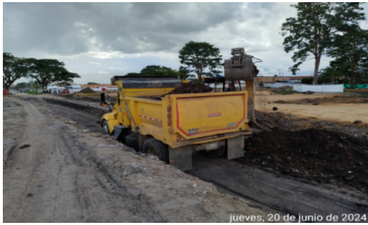
Fotografía No 33: Cajeo Calle Primera y Retiro de material sobrante
