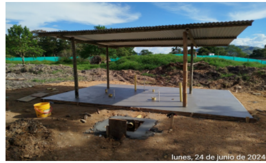
Fotografia No 40: FUNDIDA DE CONCRETO PARA PLACA DE PISO DE BATERIAS SANITARIAS - CAMPAMENTO
