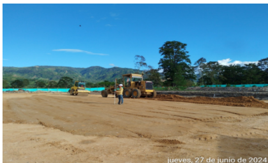
Fotografía No 47: EXCAVACIÓN E INSTALACION DE RELLENO DE ZONAS DURAS INTERMEDIA AL BLOQUE DE BIBLIOTECA, LABORATORIOS Y AULAS TIC
