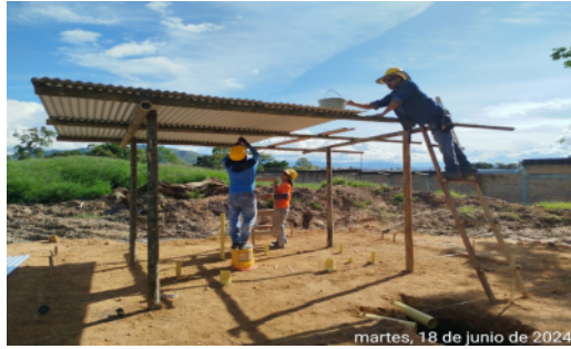
Fotografía No 30: ACTIVIDADES PARA CONSTRUCCIÓN DE BAÑOS CAMPAMENTO
