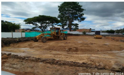
Fotografía No 9: INSTALACIÓN Y COMPACTACIÓN DE RELLENO: MODULO AULAS PRIMER PISO
