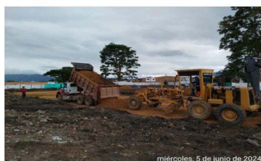
Fotografía No 4: INSTALACIÓN Y COMPACTACIÓN DE RELLENO: BLOQUE DE BIBLIOTECA, LABORATORIOS, AULAS TIC, Y AULA MÚLTIPLE
