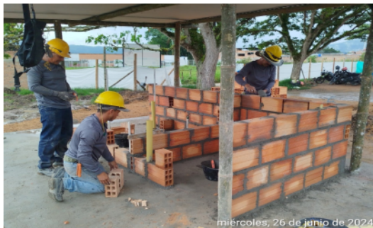
Fotografia No 41: INSTALACIÓN DE MAMPOSTERIA PARA BATERIAS SANITARIAS DE CAMPAMENTO
