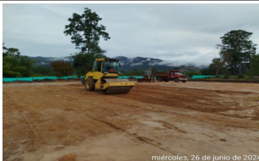
Fotografía No 46: ZONAS DURAS: Se dio inicio con el relleno y compactación en las áreas internas de circulación peatonal y zonas de concentración que se proyectan como zonas duras.
