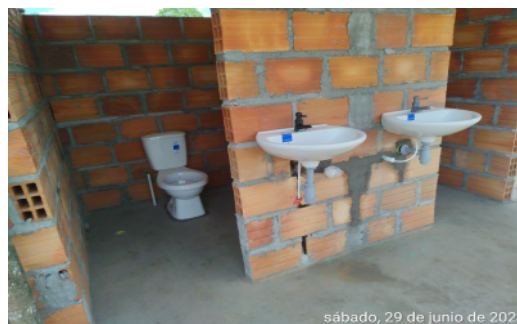
Fotografía No 44: INSTALACION DE APARARATOS SANITARIOS - BATERIAS CAMPAMENTO
