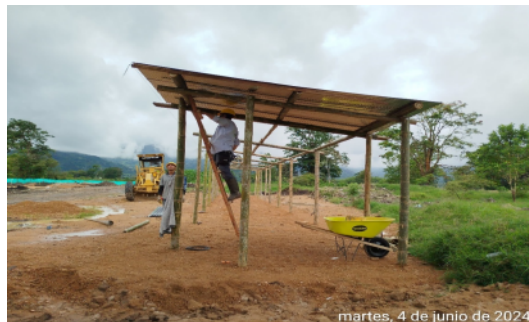
Fotografía No 3: INSTALACIÓN DE TEJAS EN ZINC PARA CUBIERTA DE CAMPAMENTO
