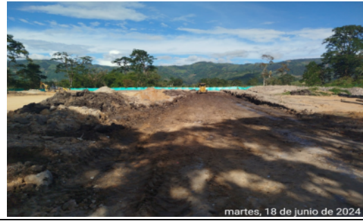
Fotografía No 32: Cajeo Calle Primera y Retiro de material sobrante
