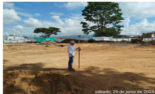
Fotografía No 40: CHEQUEOS TOPOGRAFICOS POR PARTE DE INTERVENTORIA
