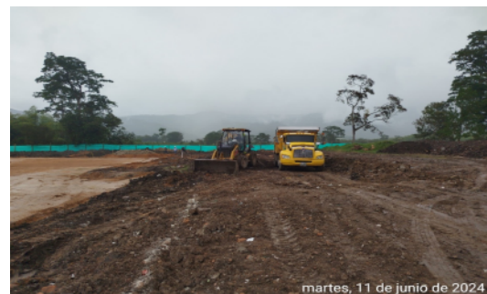
Fotografía No 16: Cajeo Calle Primera y Retiro de material sobrante
