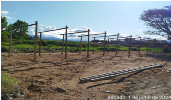
Fotografía No 1: INSTALACIÓN DE ESTRUCTURA EN GUADUA - CAMPAMENTO
