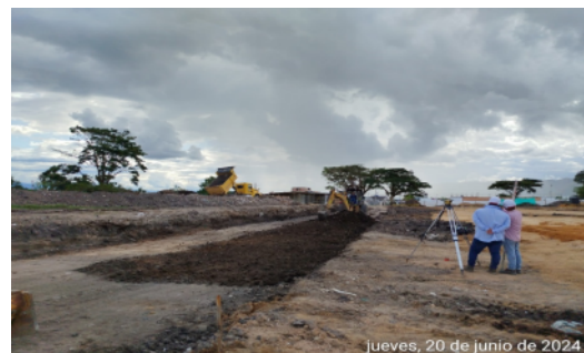
Fotografía No 34: Cajeo Calle Primera y Retiro de material sobrante. Control Topográfico
