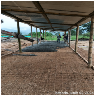
Fotografía No 13: FUNDIDA DE CONCRETO PARA PISO DE CAMPAMENTO
