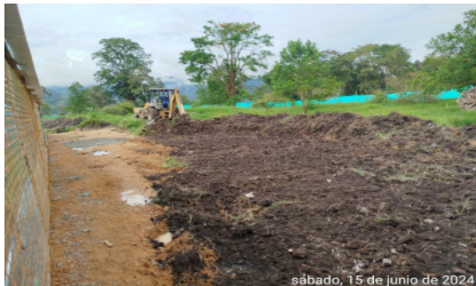
Fotografía No 23: Excavación mecánica para ampliación de Campamento
