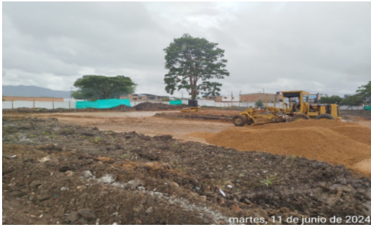
Fotografía No 15: Instalación y compactación de relleno Tercera y Cuarta Capa Módulos Biblioteca, Laboratorio Aulas TIC y Restaurante/Aula Múltiple
