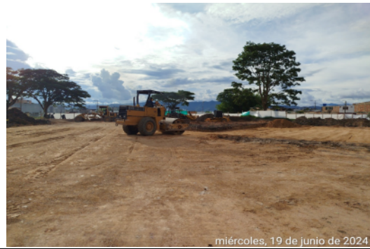
Instalación y compactación de relleno Tercera, Cuarta y Quinta Capa Módulos Biblioteca, Laboratorio Aulas TIC y Restaurante/Aula Múltiple
