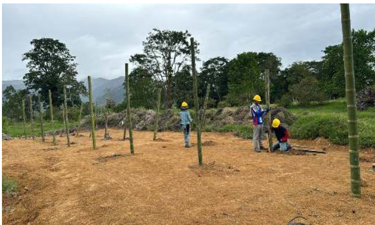
CONSTRUCCION DE CAMPAMENTO DE OBRA
