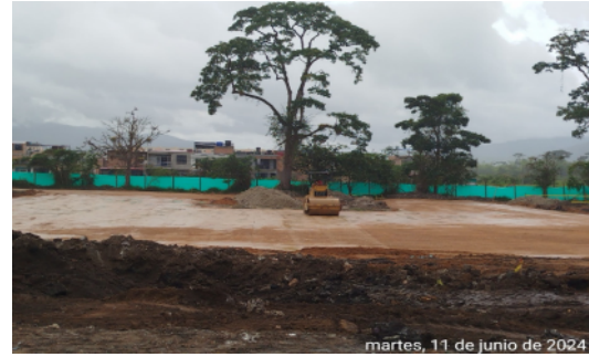
Fotografía No 18: Instalación y compactación de relleno Tercera y Cuarta Capa Módulos Biblioteca, Laboratorio Aulas TIC y Restaurante/Aula Múltiple
