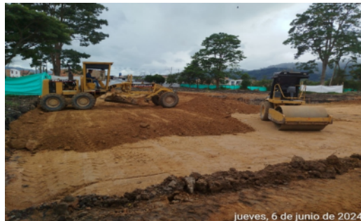
Fotografía No 8: INSTALACIÓN Y COMPACTACIÓN DE RELLENO: MODULO AULAS PRIMER PISO
