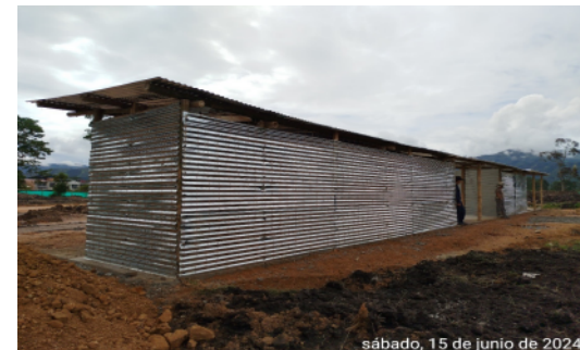
Fotografía No 24: INSTALACIÓN DE TEJAS EN ZINC PARA DIVISIONES DE CAMPAMENTO
