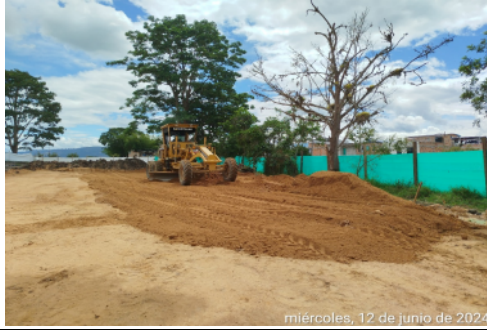
Instalación y compactación de relleno Tercera y Cuarta Capa Módulos Biblioteca, Laboratorio Aulas TIC y Restaurante/Aula Múltiple
