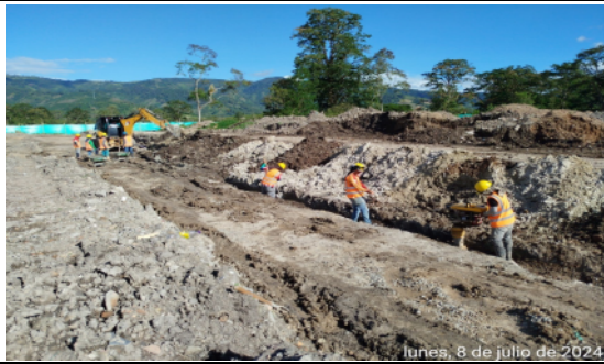
Fotografía No 19: EMPITALITO culmina actividades para la Instalación de la red sanitaria de 14", en la calle 1era.
