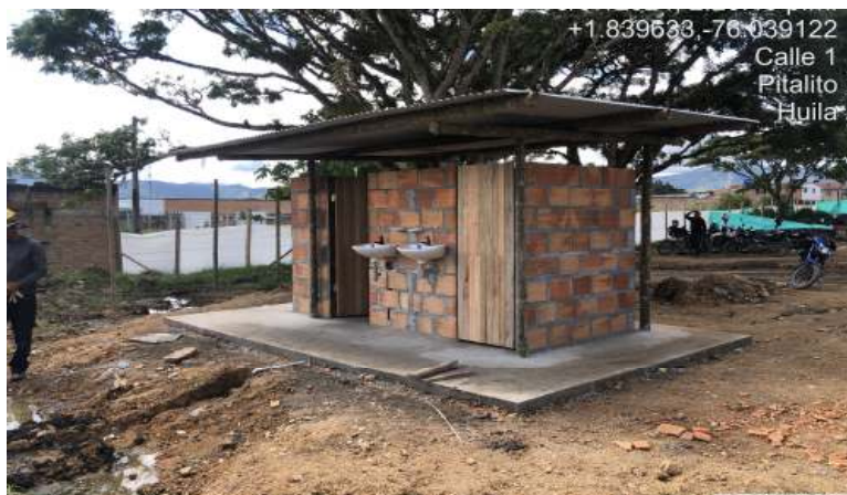
CONSTRUCCION DE BATERIAS SANITARIAS PARA EL PERSONAL
