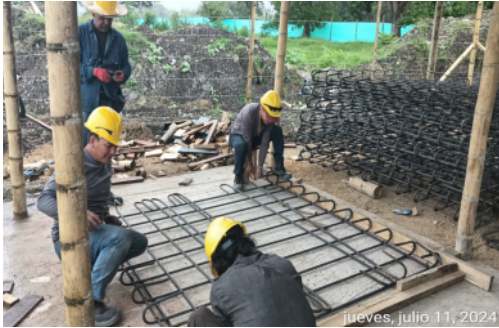
MODULO BIBLIOTECA: Amarre de acero de refuerzo para zapatas
