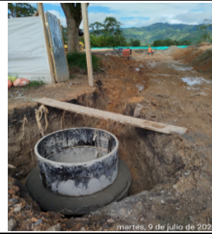
Fotografía No 20: EMPITALITO culmina actividades para la Instalación de la red sanitaria de 14", en la calle 1era.
