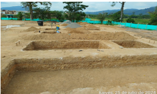
Fotografía No 35: PERFILADO MANUAL DE EXCAVACIONES PARA ZAPATAS DE CIMENTACIÓN - MÓDULO BIBLIOTECA
