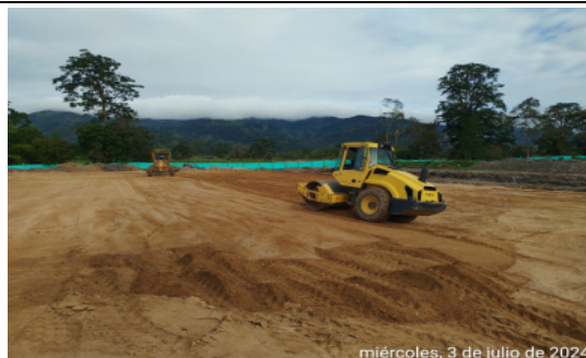
Fotografía No 2: MODULO SALA DE PROFESORES: Seriado y Compactación
