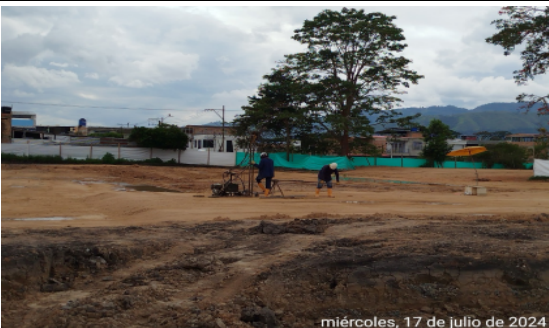
Fotografía No 23: Toma de sondeos en los diferentes módulos, para definición de niveles de fundación
