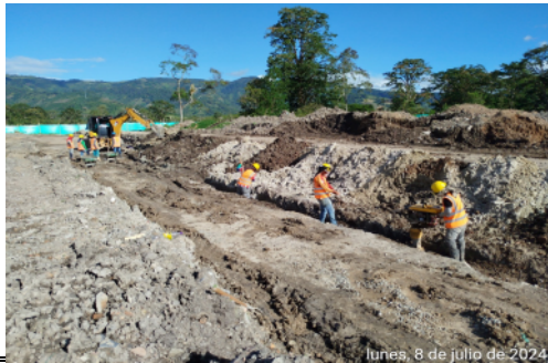
EMPITALITO culmina actividades para la Instalación de la red sanitaria de 14", en la calle 1era.
