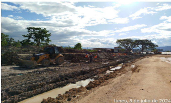
Fotografía No 17: EMPITALITO culmina actividades para la Instalación de la red sanitaria de 14", en la calle 1era.
