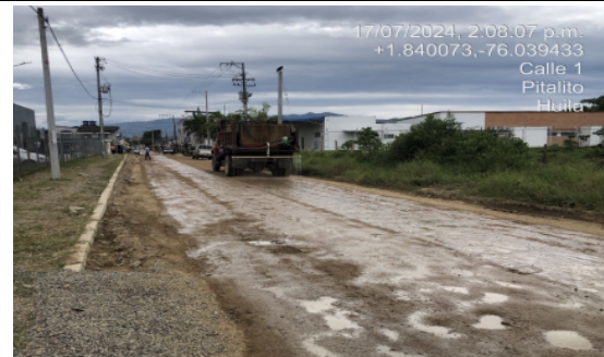
Fotografía No 24: El contratista realiza riego de la calle 1era, entre carrera 9 Este y 12 Este, como plan de contingencia y de acuerdo al compromiso establecido con la comunidad y el INTRA.
