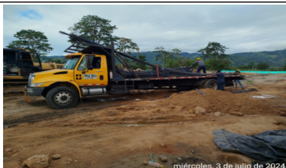
Fotografía No 9: Descarga y almacenamiento en Obra de Acero de Refuerzo para Cimentación Módulo Biblioteca
