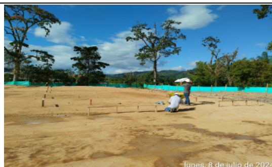
Fotografía No 12: MODULO BIBLIOTECA: Instalación de Puentes de replanteo
