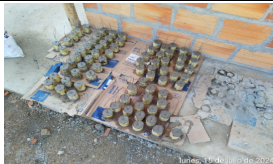
Fotografía No 21: Fabricación de panelas en concreto para recubrimiento - Cimentación Módulo Biblioteca
