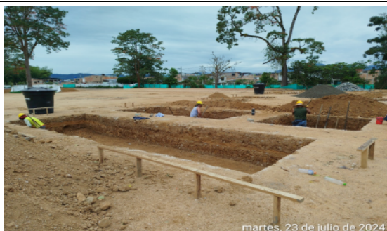
Fotografía No 33: PERFILADO MANUAL DE EXCAVACIONES PARA ZAPATAS DE CIMENTACIÓN - MÓDULO BIBLIOTECA
