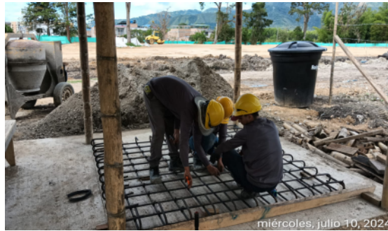
MODULO BIBLIOTECA: Amarre de acero de refuerzo para zapatas
