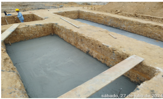
Fotografía No 37: FUNDICIÓN DE SOLADO DE LIMPIEZA PARA ZAPATAS DE CIMENTACIÓN - MÓDULO BIBLIOTECA
