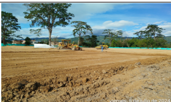
Fotografía No 3: MODULOS AULAS 1 Y 2 PISOS: Seriado y Compactación
