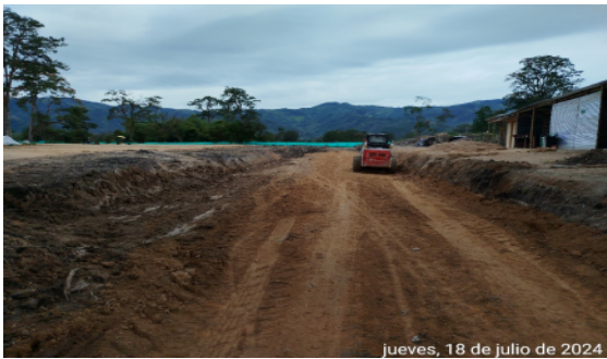
Fotografía No 29: EMPITALITO realizó instalación de relleno y nivelación de la vía Calle 1era, en el tramo donde se instaló la red de alcantarillado
