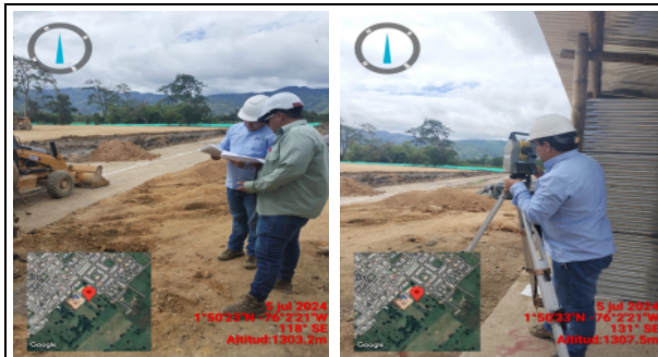
Fotografía No 8: CHEQUEOS TOPOGRAFICOS POR PARTE DE INTERVENTORIA
