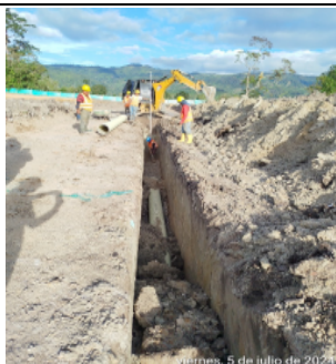
Fotografía No 7: EMPITALITO inicia actividades para la Instalación de la red sanitaria de 14", en la calle 1era.
