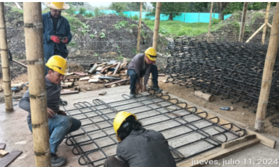
Fotografía No 15: MODULO BIBLIOTECA: Amarre de acero de refuerzo para zapatas
