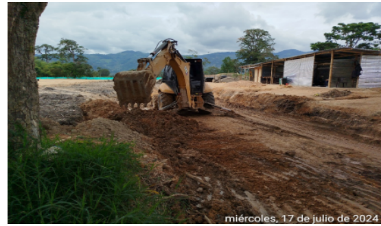
Fotografía No 28: EMPITALITO realizó instalación de relleno y nivelación de la vía Calle 1era, en el tramo donde se instaló la red de alcantarillado
