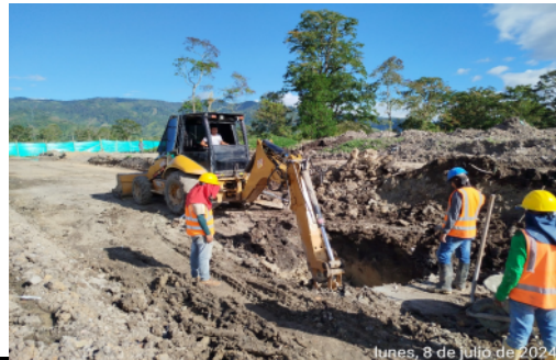
EMPITALITO culmina actividades para la Instalación de la red sanitaria de 14", en la calle 1era.
