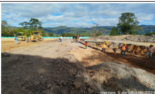
Fotografía No 6: EMPITALITO inicia actividades para la Instalación de la red sanitaria de 14", en la calle 1era.
