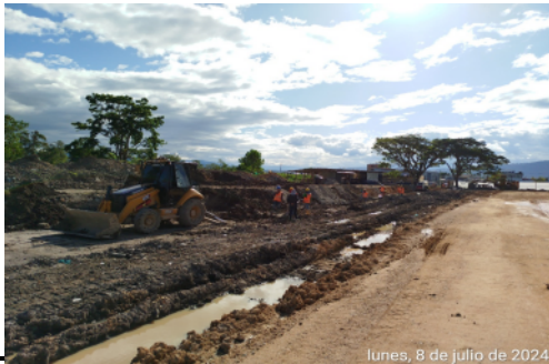
EMPITALITO culmina actividades para la Instalación de la red sanitaria de 14", en la calle 1era.
