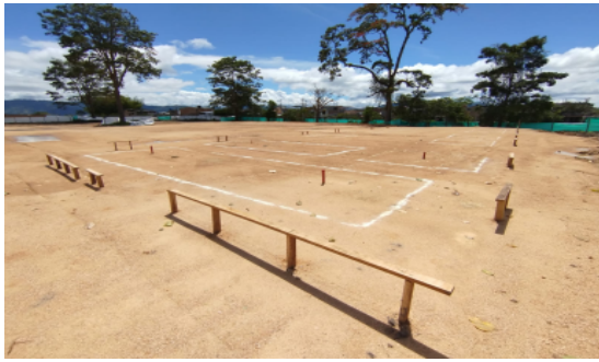
Fotografía No 13: MODULO BIBLIOTECA: Instalación de Puentes de replanteo y demarcación de Cimentación
