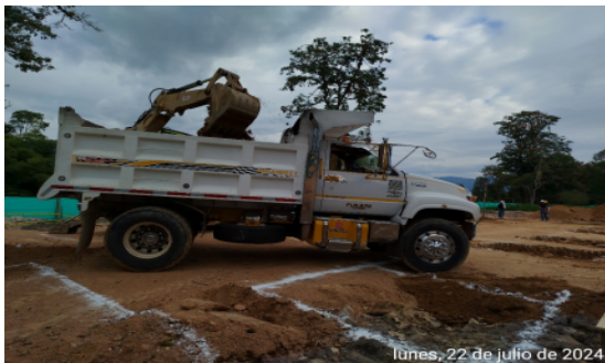
Fotografía No 31: EXCAVACIÓN MECÁNICA PARA ZAPATAS DE MÓDULO BIBLIOTECA Y RETIRO DE MATERIAL SOBRENTE
