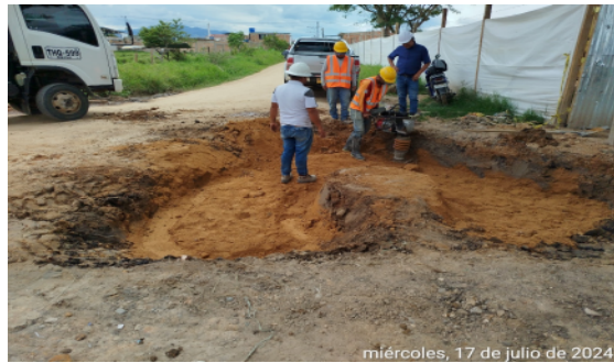
Fotografía No 27: EMPITALITO realizó instalación de relleno y nivelación de la vía Calle 1era, en el tramo donde se instaló la red de alcantarillado
