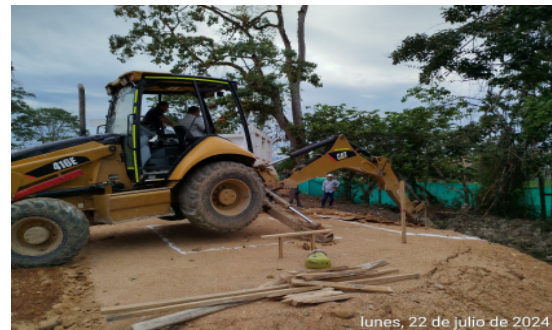
Fotografía No 30: EXCAVACIÓN MECÁNICA PARA ZAPATAS DE MÓDULO BIBLIOTECA
