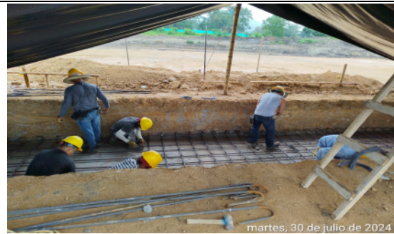
Fotografía No 40: MODULO BIBLIOTECA: Instalación de acero de refuerzo para zapatas
