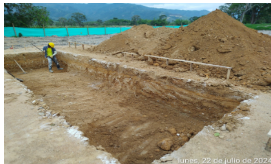
Fotografía No 32: PERFILADO MANUAL DE EXCAVACIONES PARA ZAPATAS DE CIMENTACIÓN - MÓDULO BIBLIOTECA
