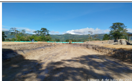
Fotografía No 4: Se finaliza excavación para vía Carrera 1era
