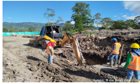
Fotografía No 18: EMPITALITO culmina actividades para la Instalación de la red sanitaria de 14", en la calle 1era.
