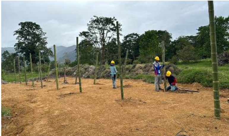
CONSTRUCCION DE CAMPAMENTO DE OBRA
