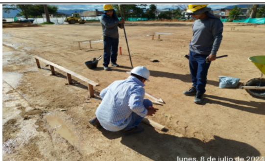
Fotografía No 11: MODULO BIBLIOTECA: Instalación de Puentes de replanteo
