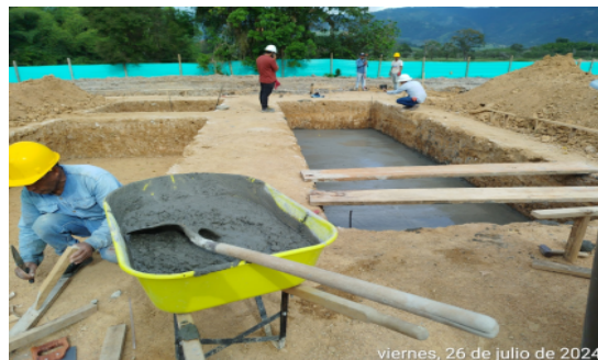
Fotografía No 36: FUNDICIÓN DE SOLADO DE LIMPIEZA PARA ZAPATAS DE CIMENTACIÓN - MÓDULO BIBLIOTECA
