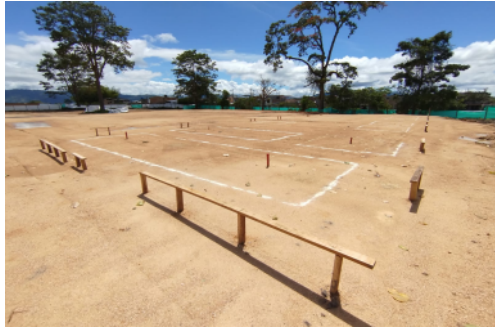
MODULO BIBLIOTECA: Instalación de Puentes de replanteo y demarcación de Cimentación
