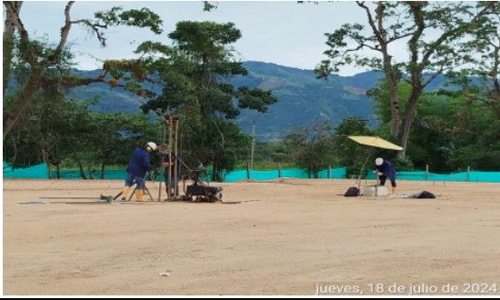
Fotografía No 25: Toma de sondeos en los diferentes módulos, para definición de niveles de fundación
