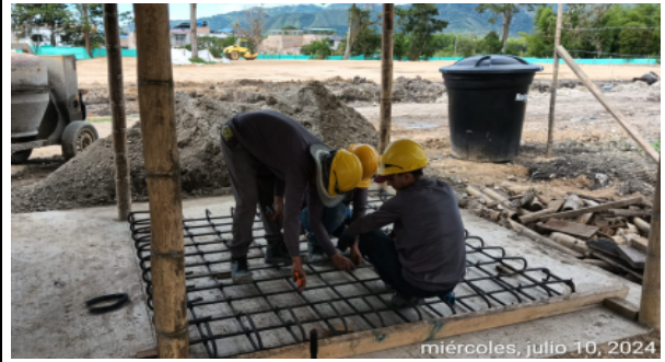
Fotografía No 14: MODULO BIBLIOTECA: Amarre de acero de refuerzo para zapatas
