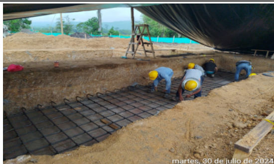
Fotografía No 39: MODULO BIBLIOTECA: Instalación de acero de refuerzo para zapatas
