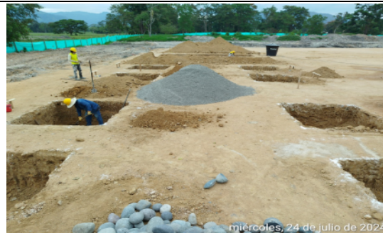
Fotografía No 34: PERFILADO MANUAL DE EXCAVACIONES PARA ZAPATAS DE CIMENTACIÓN - MÓDULO BIBLIOTECA
