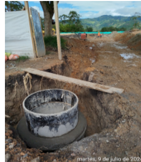
EMPITALITO culmina actividades para la Instalación de la red sanitaria de 14", en la calle 1era.
