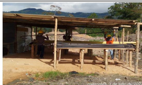
Fotografía No 10: Descarga y almacenamiento en Obra de Acero de Refuerzo para Cimentación Módulo Biblioteca
