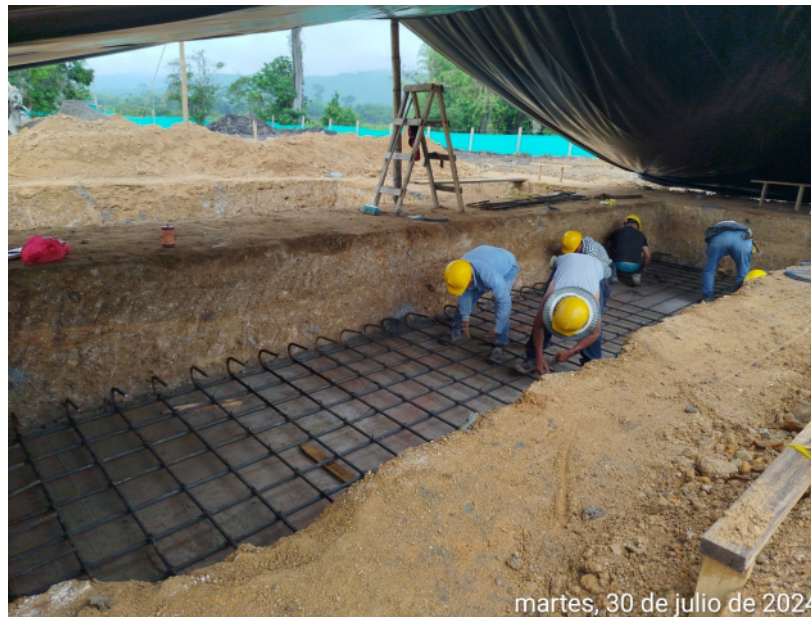
Instalación de acero de refuerzo para zapatas – Módulo Biblioteca
