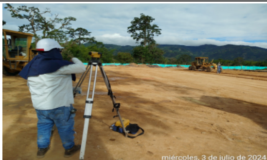
Fotografía No 1: MODULO SALA DE PROFESORES: Seriado y Compactación
