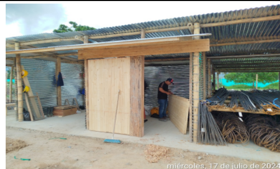
Fotografía No 22: Construcción de puertas en madera para Campamento de Obra
