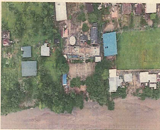
LOCALIZACIÓN Y REPLANTEO
