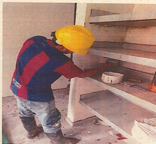
APLICACIÓN DE PINTURA TIPO I PARA INTERIORES
