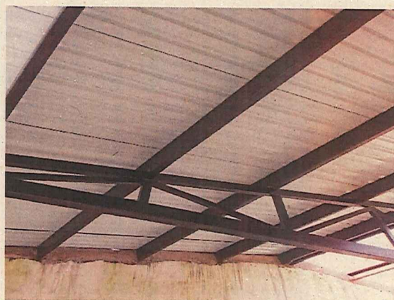
APLICACIÓN DE PINTURA 3 EN 1 PARA CARPINTERIA METÁLICA
