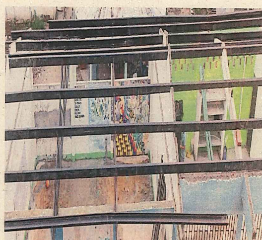
APLICACIÓN DE PINTURA 3 EN 1 PARA CARPINTERIA METÁLICA
