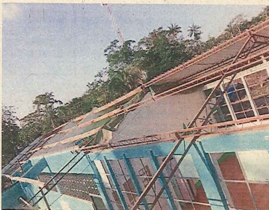
DESMONTE DE CUBIERTA Y ESTRUCTURA PORTANTE
