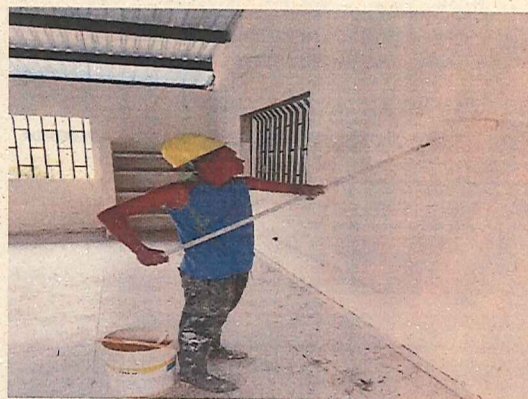
APLICACIÓN DE PINTURA TIPO I PARA INTERIORES
