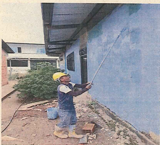
APLICACIÓN DE PINTURA TIPO I PARA EXTERIORES
