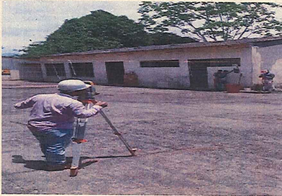
LOCALIZACION Y REPLANTEO
