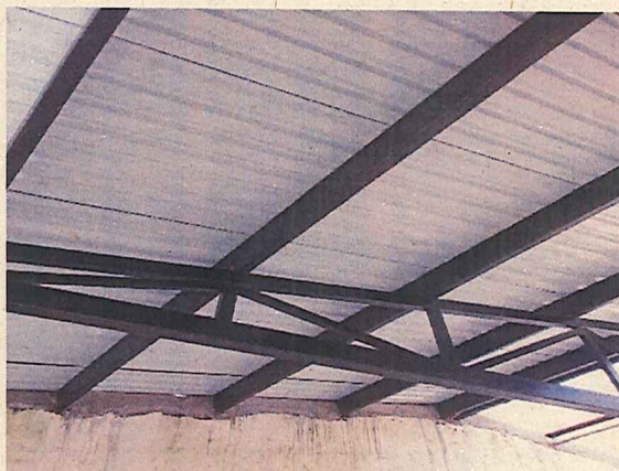
APLICACIÓN DE PINTURA 3 EN 1 PARA CARPINTERIA METÁLICA
