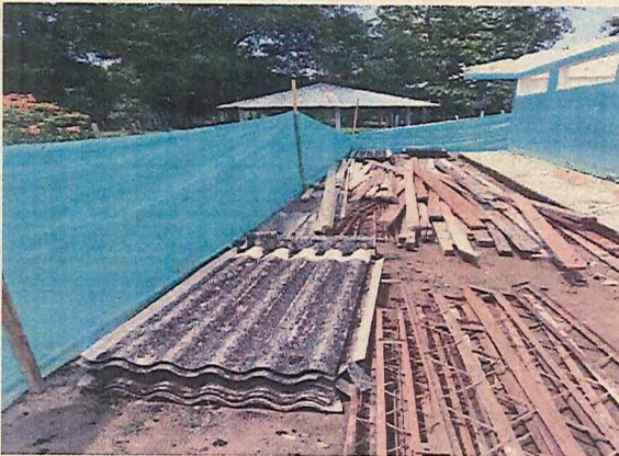
DESMONTE DE CUBIERTA Y ESTRUCTURA PORTANTE
