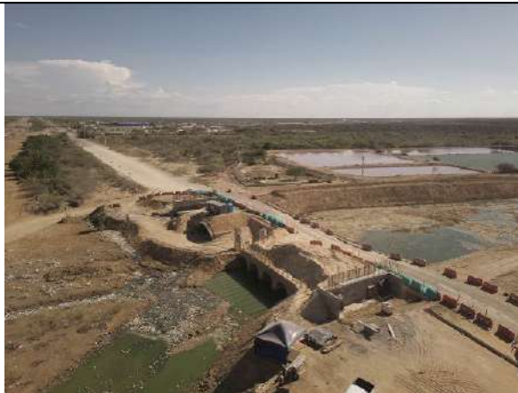
Fotografía 3: Estado del puente antes del inicio de la construcción de las vigas I. Puente Chemerrain Tramo Uribia - Puerto Bolívar
