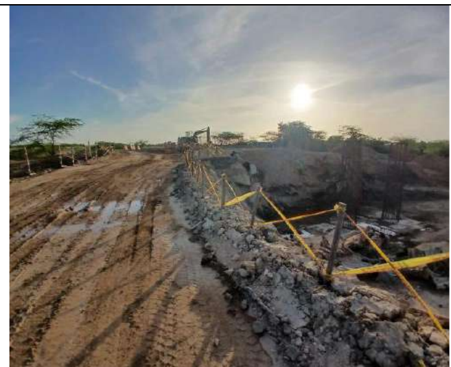
Ampliación de desvió km 110 PTE JAPURALAO.
