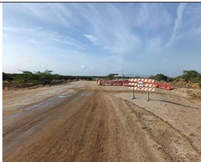
Señalización Puente Japuralao Pr 110+200
