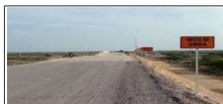
Señalización Puente Chemerrain Pr 78+040
