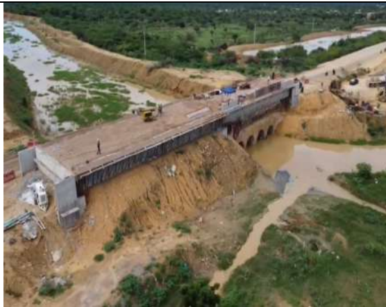
Fotografía 4: Estado del puente después de la construcción de las vigas I y tablero. Puente Chemerrain Tramo Uribia - Puerto Bolívar
