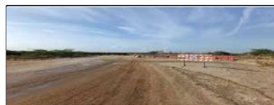
Señalización Puente Japuralao Pr 110+200
