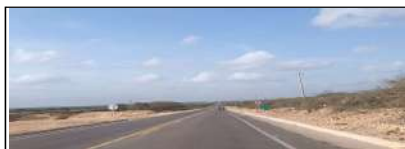
Capa de mezcla asfáltica Pr 93 + 000
