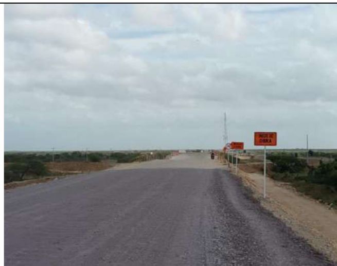
Señalización Puente Chemerrain Pr 78+040
