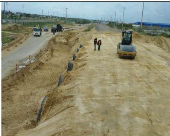
Fotografía 6: Estado actual colocación tubería metálica alcantarilla Pr 77+660, Tramo Uribia-Puerto Bolívar
