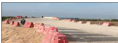
Señalización Puente Chemerrain Pr 78+040
