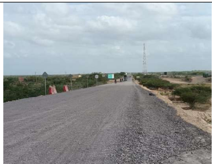
Base granular del Pr 78+100
