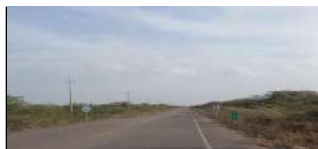
Capa de mezcla asfáltica Pr 82 + 000
