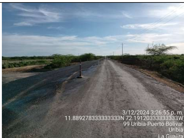
Fotografía 10: Estado de la vía después de la imprimación de la Subbase granular Pr 98+000 al Pr 98+350, Tramo Uribia - Puerto Bolívar.
