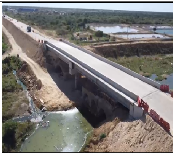
Fotografía 12: Estado final del tablero N1 y N2 del puente Chemerrain después de colocación de acero de refuerzo y fundida de concreto.
