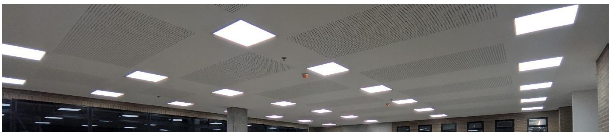
LUMINARIAS LED DE EMERGENCIA CON KIT BATERIA DE HASTA 9 MINS DE AUTONOMIA
