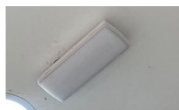
LUMINARIAS LED DE EMERGENCIA CON KIT BATERIA DE HASTA 9 MINS DE AUTONOMIA
