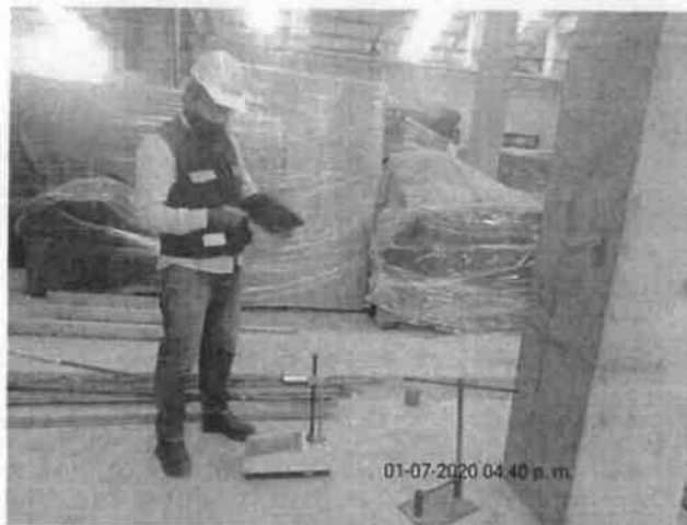
FOTO No 8: La interventoría ARQUITECTURA URBANA LTDA revisa y verifica que el contratista CONSORCIO PRUNI SEDES 04 realice el ensayo de densidades al recebo compactado B400, utilizado para conformar la placa de contrapiso del área de producción intervenido para reforzamiento estructural de la cimentación.
