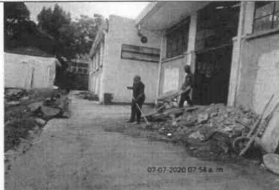
Foto No. 18. Se revisó y verificó la ejecución de limpieza - PROTOCOLO DE BIOSEGURIDAD, sede IMPRENTA DISTRITAL.
