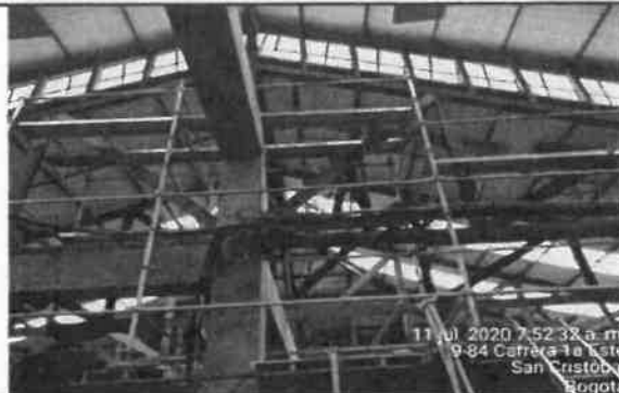
Foto No. 62. Se revisa y verifica las condiciones de seguridad industrial en el armado de los andamios, sede IMPRENTA DISTRITAL.
