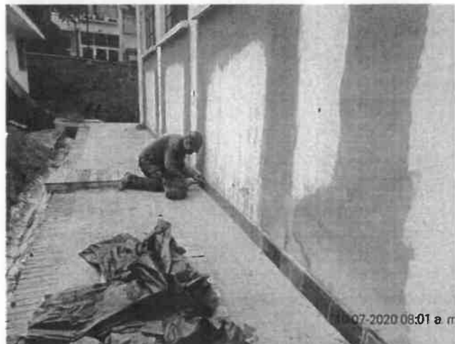
FOTO No 38: La interventoría ARQUITECTURA URBANA LTDA revisa y verifica que el contratista CONSORCIO PRUNI SEDES 04 continúe con la instalación de guarda escoba en tablón de gress.
