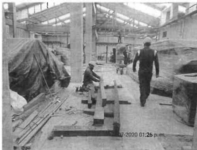
FOTO No 10: La interventoría ARQUITECTURA URBANA LTDA revisa y verifica que el contratista de obra CONSORCIO PRUNI SEDES 04 continúe con el cambio de elementos en madera de abarco en la cercha cuatro (4) ubicada en la cubierta del área de producción.
