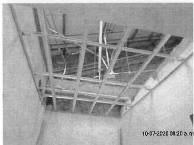
FOTO No 39: La interventoría ARQUITECTURA URBANA LTDA revisa y verifica que el contratista CONSORCIO PRUNI SEDES 04 continúe con la instalación de estructura para cielo raso en PVC en el área administrativa segundo nivel.
