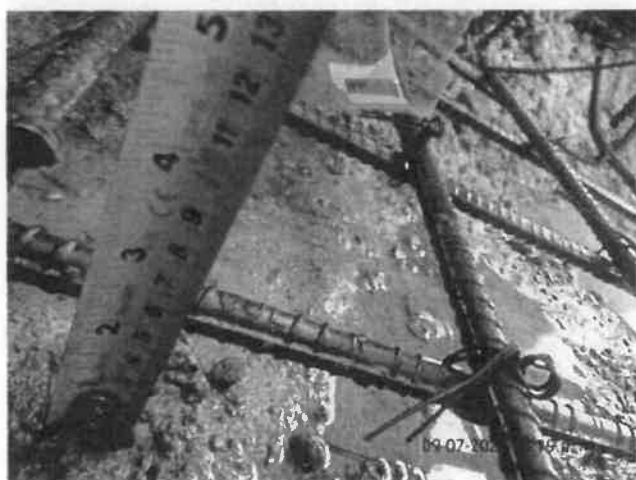
FOTO No 35: La interventoría ARQUITECTURA URBANA LTDA revisa y verifica que el contratista CONSORCIO PRUNI SEDES 04 realice el amarre de acero de refuerzo de la placa de fondo del pozo de inspección, se revisa y verifica el recubrimiento inferior el cual es de 6 cm de acuerdo a los planos de diseño.
