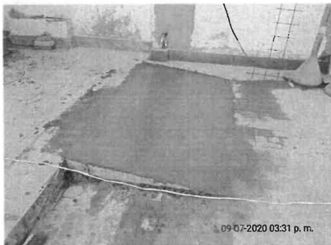
FOTO No 37: La interventoría ARQUITECTURA URBANA LTDA revisa y verifica el suministro, instalación y acabado de la rampa en concreto de 3000 PSI de acceso al cuarto sub estación eléctrica por parte del contratista CONSORCIO PRUNI SEDES 04
