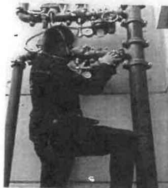
Actividad: Presurización de red
