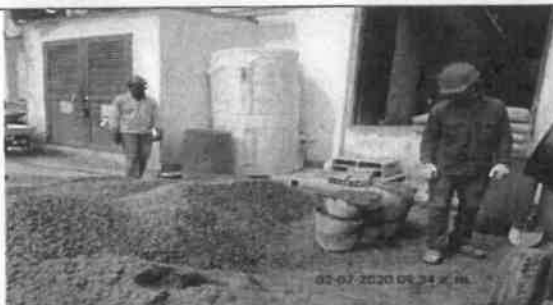
Foto No 5. La interventoría ARQUITECTURA URBANA LTDA reviso y verifico que el contratista de obra CONSORCIO PRUNI SEDES 04 realice la dosificación de agregado grava fina de acuerdo al diseño de mezclas aprobado.
