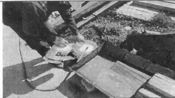
Foto No 8. La INTERVENTORIA ARQUITECTURA URBANA LTDA revisa y verifica el proceso de inmunización se por el método de inmersión, para lo cual se introduce la madera por 2 horas y luego se gira la viga de madera por la otra cara la cual no está sumergida durante otras 2 horas.
