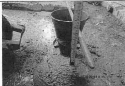
Foto No 2. La INTERVENTORIA ARQUITECTURA URBANA LTDA se realizado el ensayo se procede a realizar la lectura donde dio 7.2 pulgadas aprobando su vaciado debido que en el diseño de mezcla su dosificación exige 6.5 pulgadas con un margen de más o menos una pulgada 1(+/-) ".
