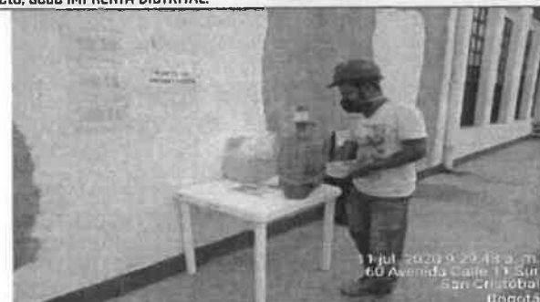
Foto No. 65. Se revisa y verifica el punto ecológico de la obra, sede IMPRENTA DISTRITAL
