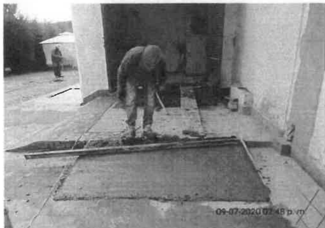
FOTO No 33: La interventoría ARQUITECTURA URBANA LTDA revisa y verifica el suministro e instalación de concreto de 3000 PSI en rampa de acceso
