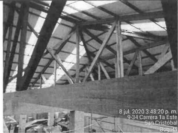
Foto No. 44. Se revisó y verificó la instalación de las piezas de madera de las cerchas de la cubierta sede IMPRENTA DISTRITAL.
