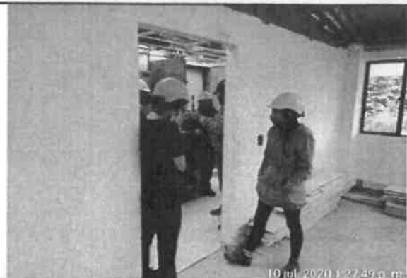
Foto No. 58. Se revisa y verifica las condiciones de seguridad industrial en el recorrido de obra. En la sede IMPRENTA DISTRITAL
