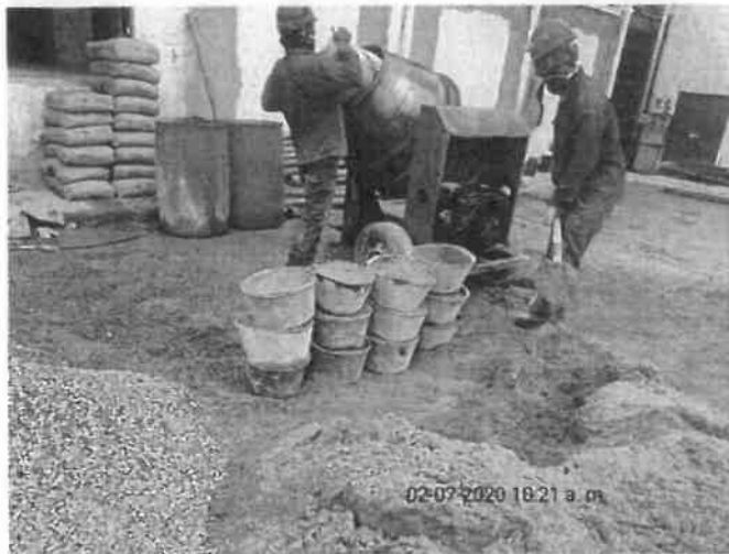
FOTO No 13: La interventoría ARQUITECTURA URBANA LTDA revisa y verifica que el contratista CONSORCIO PRUNI SEDES 04 realice la dosificación del agregado fino (arena de río) para elaborar concreto de 3000 PSI, utilizado para el vaciado en la placa de contrapiso del cuarto del generador eléctrico.
