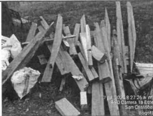
Foto No. 40 Se revisó y verificó que se esté almacenando las piezas de madera retiradas de la cercha para la disposición final sede IMPRENTA DISTRITAL
