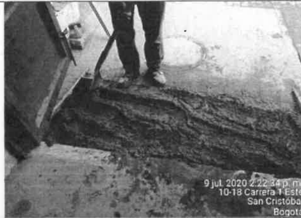
Foto No. 48. Se revisó y verificó que la rampa cumpla con las condiciones técnicas para el ingreso de máquinas y materiales sede IMPRENTA DISTRITAL
