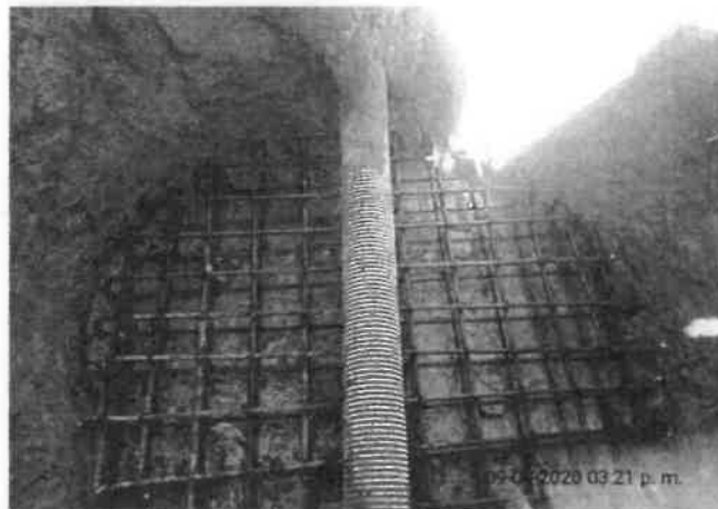
FOTO No 34: La interventoría ARQUITECTURA URBANA LTDA revisa y verifica que el contratista CONSORCIO PRUNI SEDES 04 realice el suministro y amarre de acero de refuerzo No cuatro (4) para construir placa de fondo del pozo de inspección.
