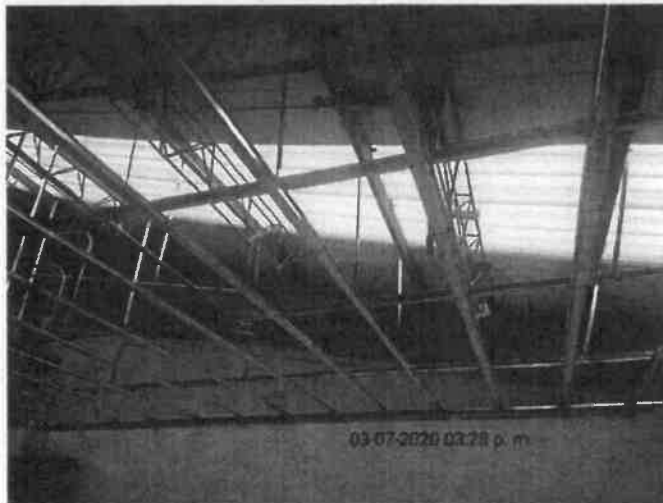
FOTO No 23: La interventoría ARQUITECTURA URBANA LTDA revisa y verifica que el contratista CONSORCIO PRUNI SEDES 04 realice la instalación de estructura para cielo raso en PVC en las oficinas y baños del área administrativa segundo nivel.
