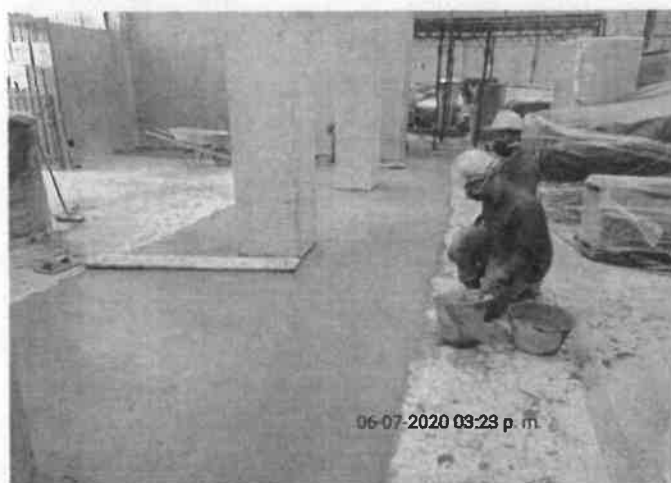
FOTO No 27: La interventoría ARQUITECTURA URBANA LTDA revisa y verifica que el contratista CONSORCIO PRUNI SEDES 04 realice la actividad de afinado del concreto de 3000 PSI vaciado en la placa de contrapiso del área de producción.
