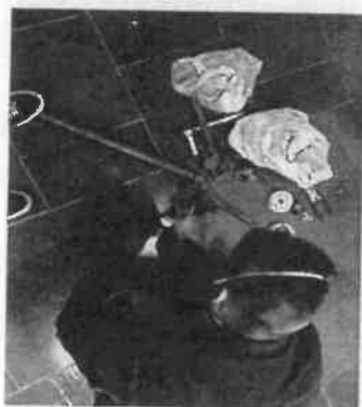
Actividad: Cambio de accesorio defectuoso (Caucho)
