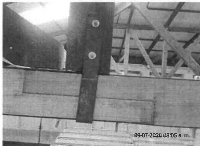
FOTO No 30: La interventoría ARQUITECTURA URBANA LTDA revisa y verifica que el contratista CONSORCIO PRUNI SEDES 04 realice la reinstalación de platinas existentes con su respectivos pernos, cambiado el elemento en madera de abarco en la cerchas número tres (3) y cuatro (4)
