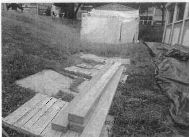
FOTO No 15: La interventoría ARQUITECTURA URBANA LTDA revisa y verifica las vigas en madera de abarco ingresadas por el contratista de obra CONSORCIO PRUNI SEDES 04 para actividad de reemplazo de elementos de madera existentes en las cerchas que componen la cubierta del área de producción.
