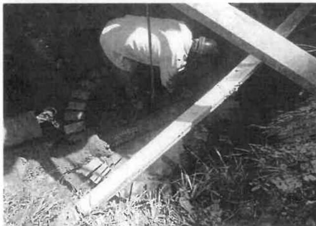
FOTO No 42: La interventoría ARQUITECTURA URBANA LTDA revisa y verifica que el contratista CONSORCIO PRUNI SEDES 04 continúe con la construcción del pozo de inspección en ladrillo tolete común recocido en la sede IMPRENTA DISTRITAL.
