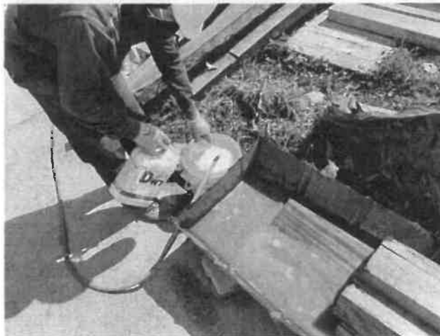
FOTO No 44: La interventoría ARQUITECTURA URBANA LTDA revisa y verifica que el contratista CONSORCIO PRUNI SEDES 04 realice inmunización de madera por el método de sumersión, la interventoría ARQUITECTURA URBANA LTDA revisa y verifica la dosificación del inmunizante DWT el cual es 100 ml por cada 20 lts de agua.
