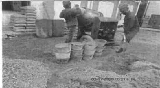
Foto No 6. La interventoría ARQUITECTURA URBANA LTDA reviso y verifico que el contratista de obra CONSORCIO PRUNI SEDES 04 realice la dosificación de agregado arena fina de acuerdo al diseño de mezclas aprobado.
