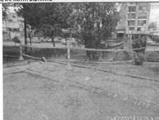
Foto No. 41. Se revisó y verificó la señalización de las áreas que se están interviniendo sede IMPRENTA DISTRITAL
