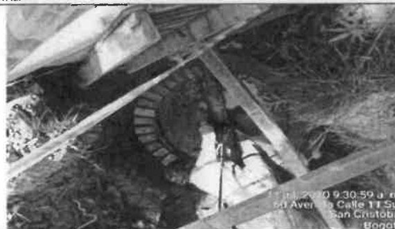
Foto No. 66. Se revisa y verifica las condiciones de seguridad industrial en la construcción del foso, sede IMPRENTA DISTRITAL
