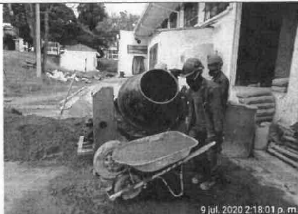
Foto No. 47. Se revisó y verificó los distanciamientos de seguridad sede IMPRENTA DISTRITAL
