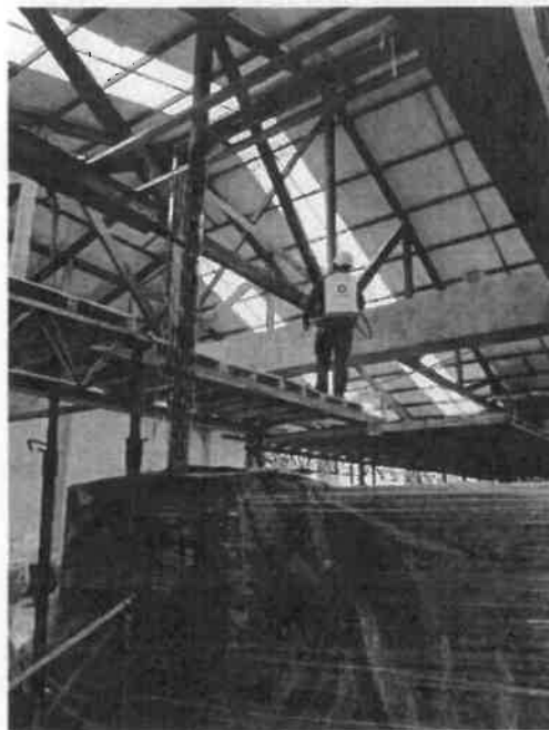
FOTO No 46: La interventoría ARQUITECTURA URBANA LTDA revisa y verifica que el contratista CONSORCIO PRUNI SEDES D4 realice la inmunización por medio de aspersión a la estructura en madera existente que conforma la cubierta del área de producción.
