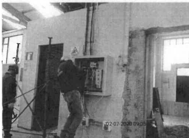
FOTO No 11: La interventoría ARQUITECTURA URBANA LTDA revisa y verifica que el contratista de obra CONSORCIO PRUNI SEDES 04 realice la reinstalación de tablero eléctrico de cuarenta y ocho (48) circuitos de alumbrado en el área de producción.
