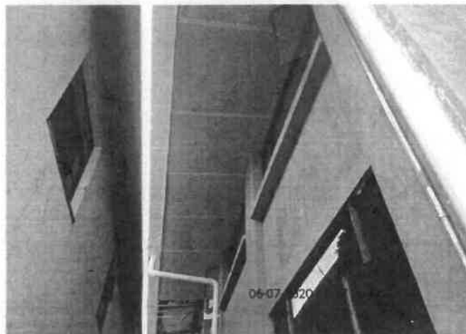
FOTO No 26: La interventoría ARQUITECTURA URBANA LTDA revisa y verifica que el contratista CONSORCIO PRUNI SEDES 04 realice la instalación de cielo raso en superboard localizado en el alero de la cubierta costado Nor-occidental de la sede IMPRENTA DISTRITAL
