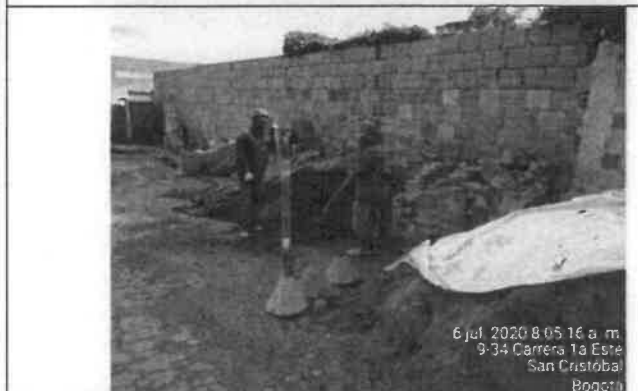
Foto No. 25. Se revisó y verificó las condiciones de seguridad para el cargue, sede IMPRENTA DISTRITAL.
