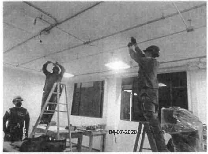
FOTO No 24: La interventoría ARQUITECTURA URBANA LTDA revisa y verifica que el contratista CONSORCIO PRUNI SEDES 04 inicie con la actividad de instalación de tubería EMT de diámetro " correspondiente al capítulo 3.0.5 sistema de detención de incendios.
