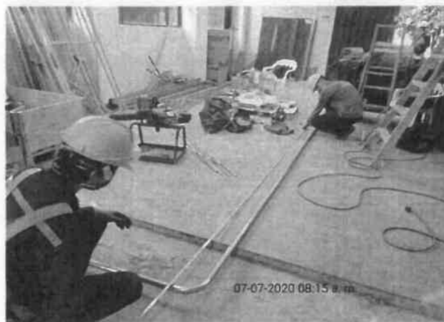
FOTO No 28: La interventoría ARQUITECTURA URBANA LTDA revisa y verifica que el contratista CONSORCIO PRUNI SEDES 04 realice la instalación de tubería en acero inoxidable de diámetro de 30 mm.
