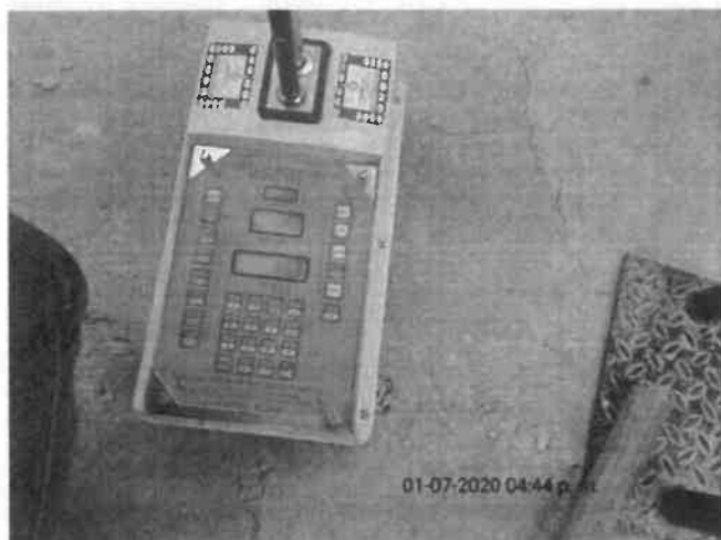
FOTO No 9: La interventoría ARQUITECTURA URBANA LTDA revisa y verifica que el contratista CONSORCIO PRUNI SEDES 04 realice el ensayo de densidades al recebo compactado B400, utilizado para conformar la placa de contrapiso del área de producción intervenido para reforzamiento estructural de la cimentación.
