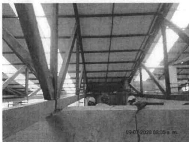
FOTO No 31: La interventoría ARQUITECTURA URBANA LTDA revisa y verifica que el contratista CONSORCIO PRUNI SEDES 04 realice la instalación de vigas en madera de abarco en la cercha No tres (3) de acuerdo a planos y especificaciones técnicas del proyecto.
