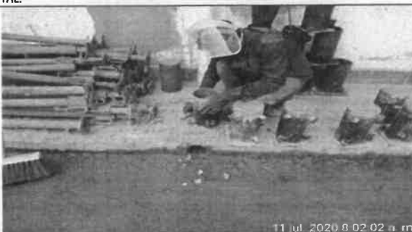
Foto No. 63. Se revisa y verifica el desencofrado de las camisas de la muestra de concreto, sede IMPRENTA DISTRITAL.
