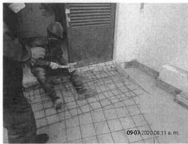
FOTO No 32: La interventoría ARQUITECTURA URBANA LTDA revisa y verifica que el contratista CONSORCIO PRUNI SEDES 04 realice limpieza a la malla electrosoldada Q-4 6mm para evitar que agentes patógenos o corrosión impidan la debida adherencia con el concreto utilizado en las rampas de acceso a la subestación eléctrica.
