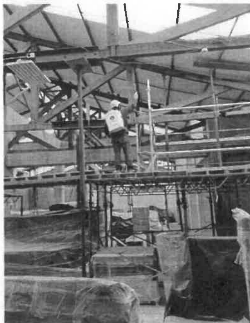
FOTO No 45: La interventoría ARQUITECTURA URBANA LTDA revisa y verifica que el contratista CONSORCIO PRUNI SEDES D4 realice la inmunización por medio de aspersión a la estructura en madera existente que conforma la cubierta del área de producción.
