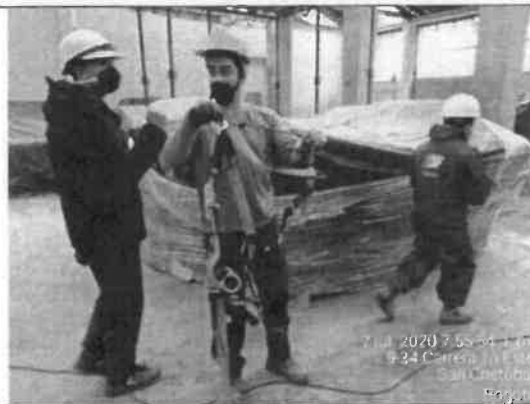
Foto No. 36. Se revisa y verifican las inspecciones por parte del personal los equipos de trabajo en alturas sede IMPRENTA DISTRITAL.
