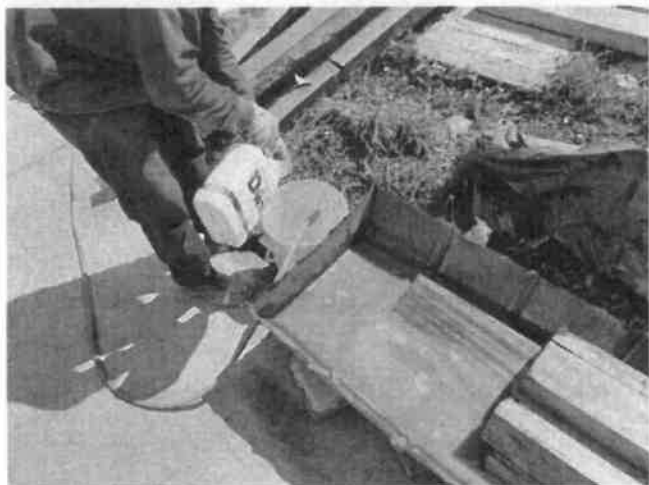
FOTO No 43: La interventoría ARQUITECTURA URBANA LTDA revisa y verifica que el contratista CONSORCIO PRUNI SEDES 04 realice inmunización de madera por el método de sumersión, la interventoría ARQUITECTURA URBANA LTDA revisa y verifica la dosificación del inmunizante DWT el cual es 100 ml por cada 20 lts de agua.
