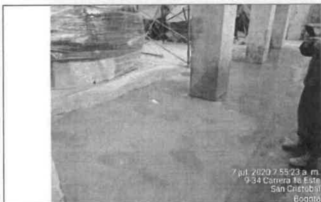
Foto No. 35. Se revisa y verifica el fraguado de la placa sede IMPRENTA DISTRITAL.
