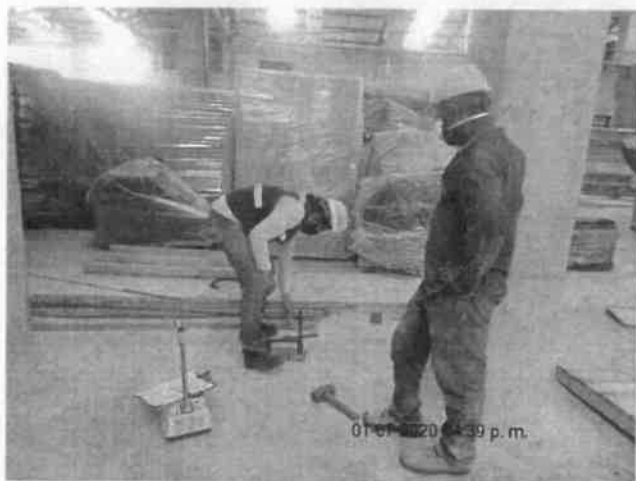
FOTO No 7: La interventoría ARQUITECTURA URBANA LTDA revisa y verifica que el contratista CONSORCIO PRUNI SEDES 04 realice el ensayo de densidades al recebo compactado B400, utilizado para conformar la placa de contrapiso del área de producción intervenido para reforzamiento estructural de la cimentación.
