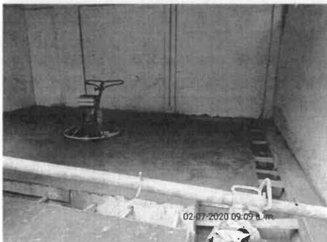
FOTO No 12: La interventoría ARQUITECTURA URBANA LTDA revisa y verifica que el contratista CONSORCIO PRUNI SEDES 04 realice el acabado de piso quemado con helicóptero en el cuarto generador eléctrico.
