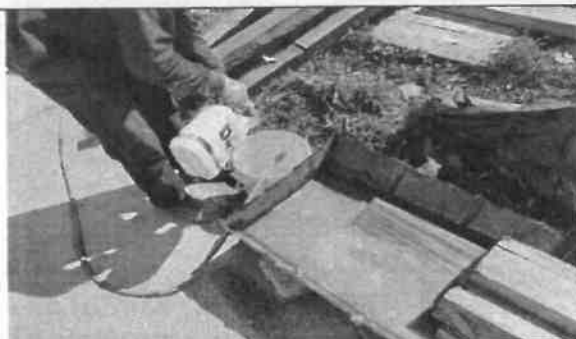
Foto No 7. La INTERVENTORIA ARQUITECTURA URBANA LTDA revisa y verifica el producto con el cual se va realizar la inmunización sea lo acordado de acuerdo a la ficha técnica entregada.
