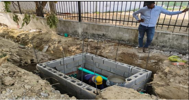
CONSTRUCCION DE REGISTRO DE BANCO DE DUCTOS ENTRE CALLES 82 Y 84
