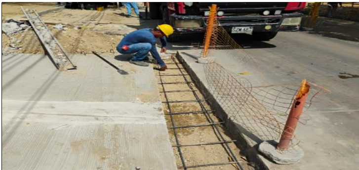
ACERO DE REFUERZO CENEFA VIA ENTRE CALLES 84 Y 85
