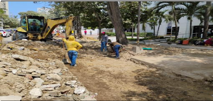
EXCAVACION PARA AMPLIACION VIA ENTRE CALLES 80 Y 82
