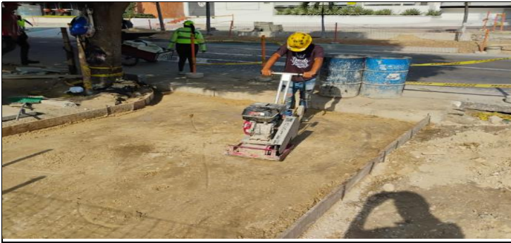
COMPACTACION RAMPA ACCESO A PREDIOS ENTRE CARRERAS 48 Y 49C
