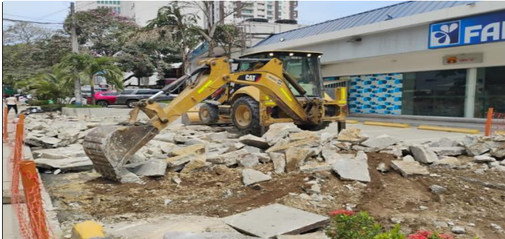
DEMOLICION ANDEN ENTRE CALLES 82 Y 84
