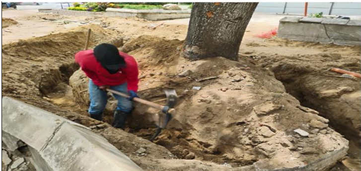
EXCAVACION PARA INSTALACION TUBERIA DE PEAD ENTRE CALLES 84 Y 84B
