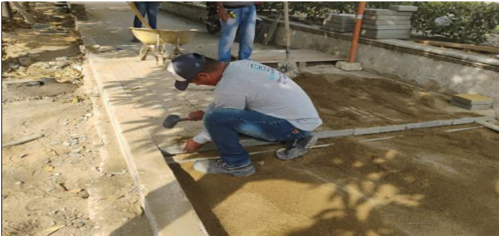
INSTALACION DE LOSETAS ENTRE CARRERAS 49C Y 50
