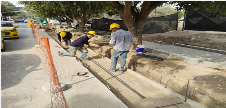
ACERO DE REFUERZO AMPLIACION VIA ENTRE CARRERAS 46 Y 47
