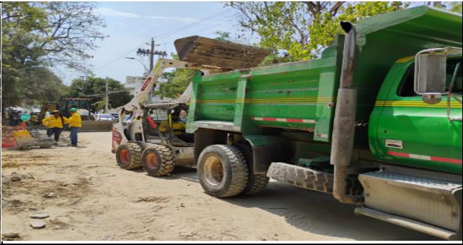
CARGUE Y RETIRO DE ESCOMBRO ENTRE CALLES 80 Y 82
