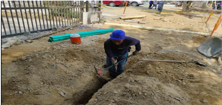
EXCAVACION PARA INSTALACION DUCTOS DE ALUMBRADO PUBLICO ENTRE CALLES 82 Y 84
