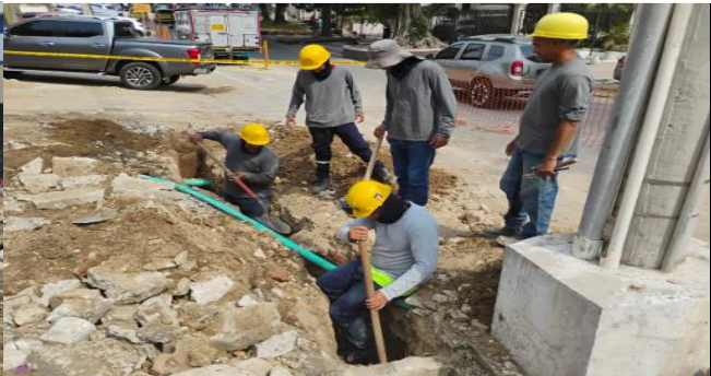
EXCAVACION PARA INSTALACION TUBERIA DE PEAD ENTRE CALLES 82 Y 84
