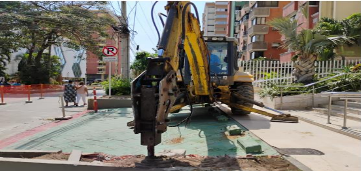
DEMOLICION ANDEN ENTRE CALLES 82 Y 84
