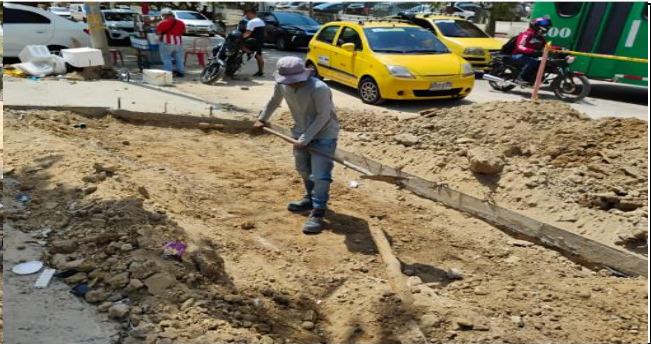
EXCAVACION BAHIA PARQUEADEROS ENTRE CALLES 80 Y 82
