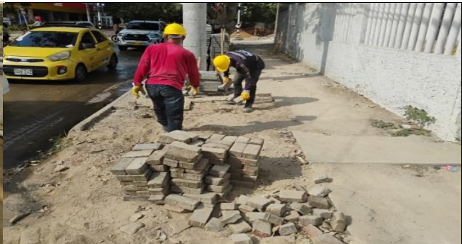
RETIRO DE ADOQUINES ENTRE CARRERAS 47 Y 48
