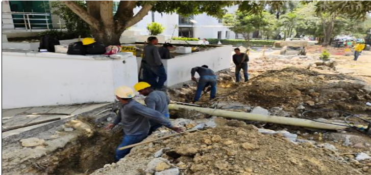
EXCAVACION PARA INSTALACION BANCO DE DUCTOS ENTRE CALLES 80 Y 82
