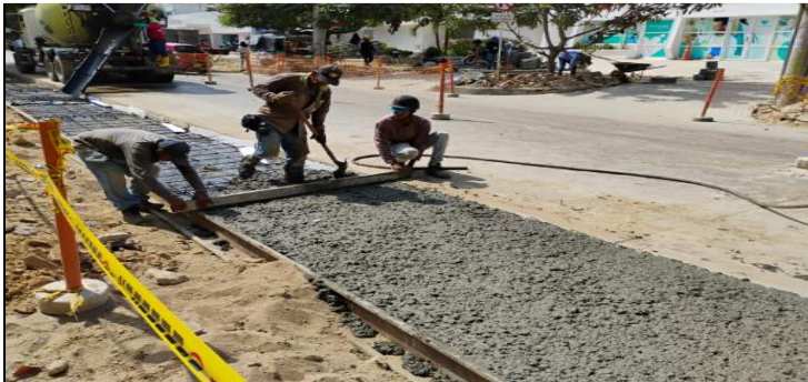
FUNDIDA AMPLIACION VIA ENTRE CALLES 84 Y 85
