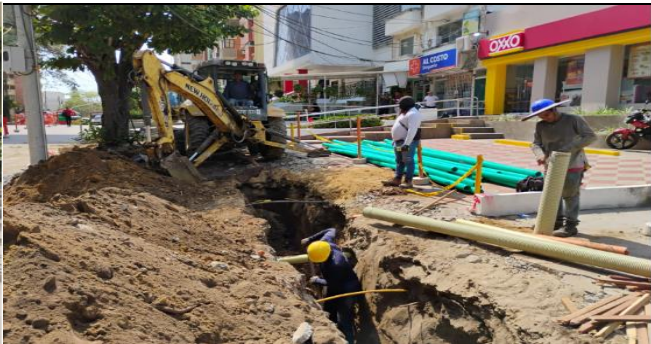
EXCAVACION PARA INSTALACION DE TUBERIA DE BANCO DE DUCTOS ENTRE CALLES 82 Y 84
