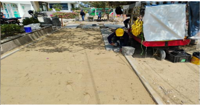
INSTALACION DE LOSETAS ENTRE CALLES 84 Y 85
