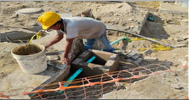
CONSTRUCCION REGISTRO SEMAFORO ENTRE CARRERAS 48 Y 49C
