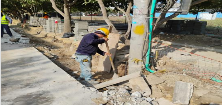
EXCAVACION PARA AMPLIACION VIA ENTRE CARRERAS 45 Y 47
