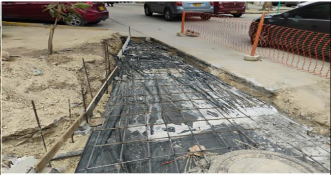
ACERO DE REFUERZO CARRIL DE DESACELERACION CALLE82
