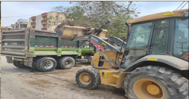
CARGUE Y RETIRO DE ESCOMBROS ENTRE CALLES 84 Y 85
