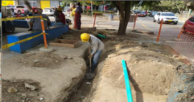
EXCAVACION PARA INSTALACION DUCTOS DE ALUMBRADO PUBLICO ENTRE CARRERAS 47 Y 48
