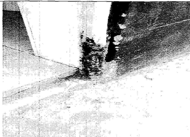
Evidencia N° 3: Sede olivos, marco de la puerta del shut de basuras en mal estado.
