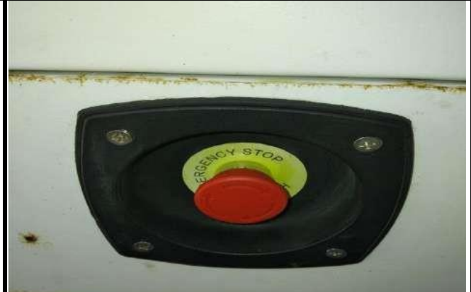
BOTON DE PARADA DE EMERGENCIA INSTALADO
