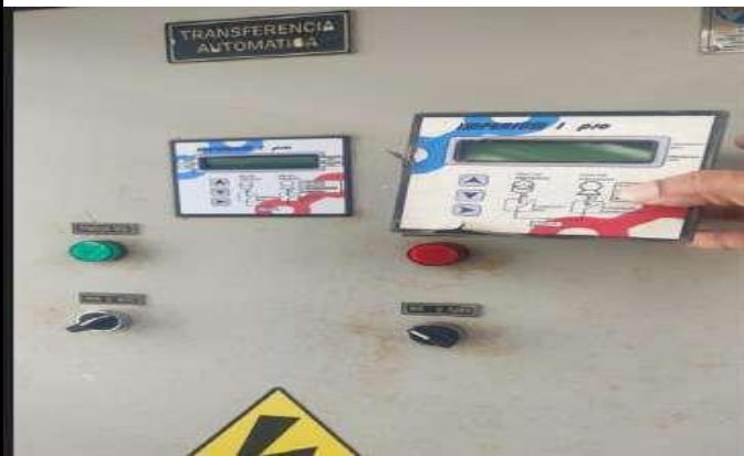
TARJETAS DE CONTROL INSTALADA E INST. DE BOTON DE EMERGENCIA
