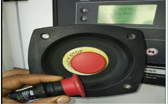
TARJETAS DE CONTROL INSTALADA E INST. DE BOTON DE EMERGENCIA
