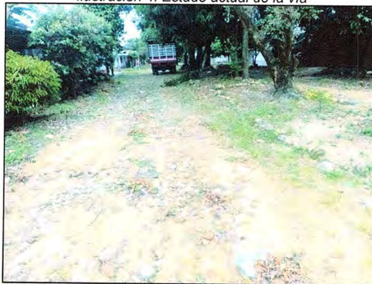
Ilustración 4. Estado actual de la vía
