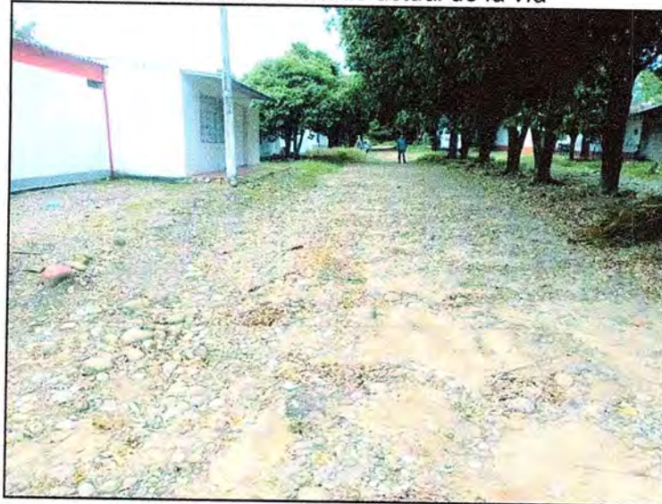
Ilustración 6. Estado actual de la vía
