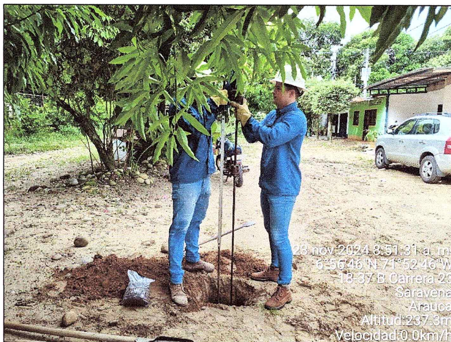
Foto 11. Ensayo de Penetración Dinámica de Cono (PDC) Apique A-04
