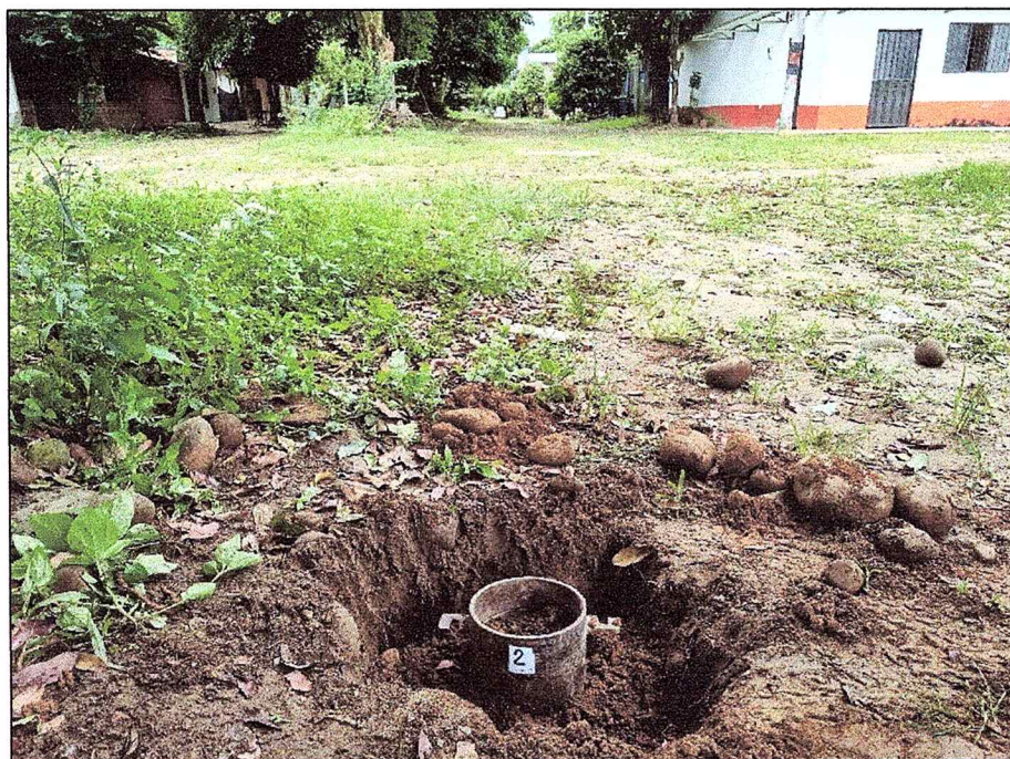
Foto 6. Toma de muestra en molde CBR, Apique A-02
