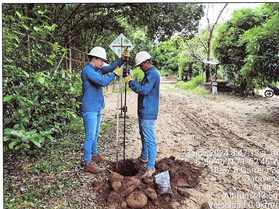
Foto 8. Ensayo de Penetración Dinámica de Cono (PCD) Apique A-03
