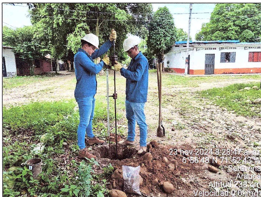
Foto 5. Ensayo de Penetración Dinámica de Cono (PDC) Apique A-02
