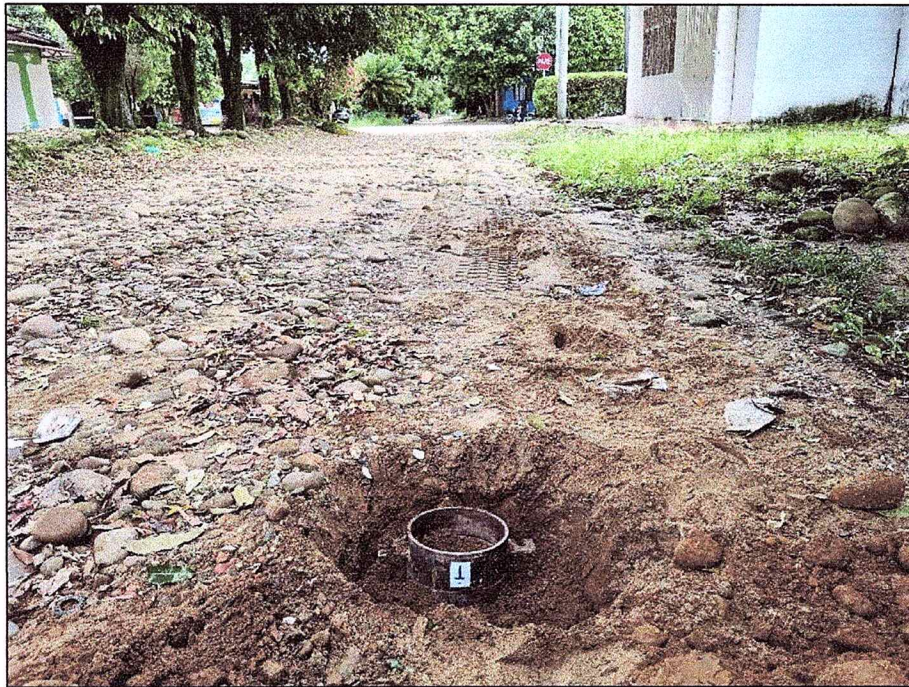
Foto 3. Toma de muestra en molde CBR, Apique A-01
