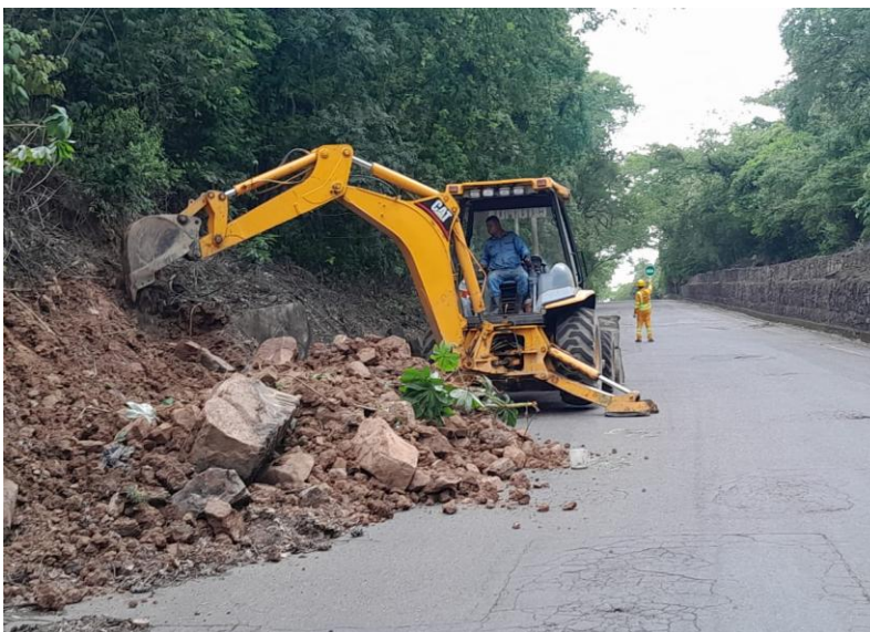
Figura 2. Vía 55ns09 Cúcuta - la china
