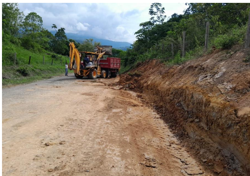
Figura 5. Vía 55ns09 Cúcuta - la china
