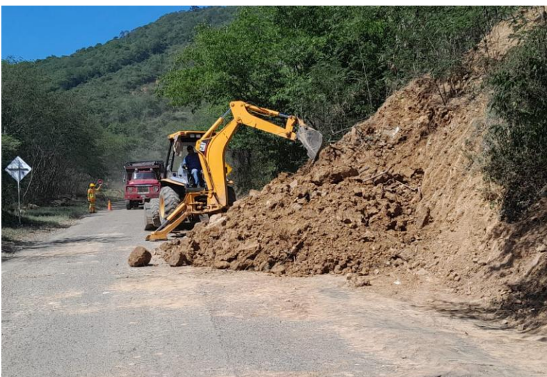
Figura 3. Vía 55ns09 Cúcuta - la china
