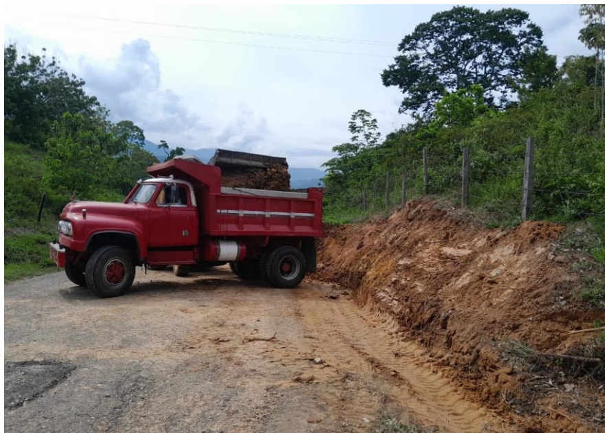
Figura 4. Vía 55ns09 Cúcuta - la china
