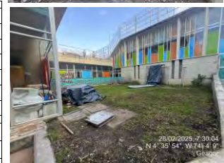
FOTO 7 Acopios de elementos retirados
