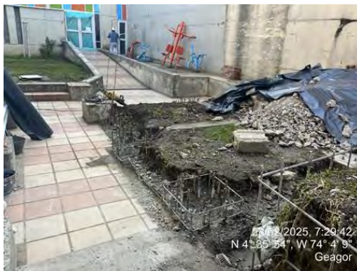
Actividades: uso de elementos de protección personal Fotografía tomada de interventoría GEAGOR
