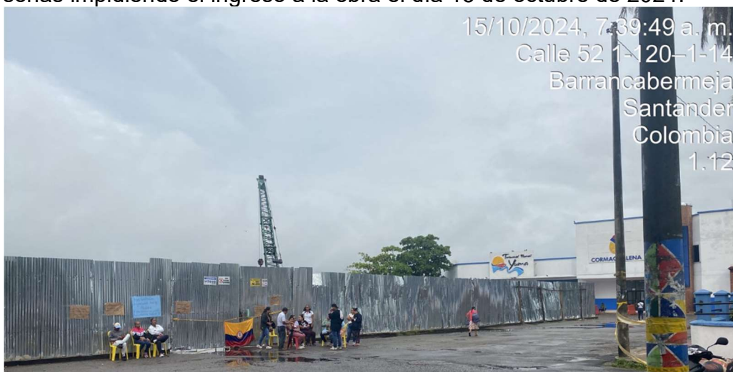
Personas impidiendo ingreso a obras el día 16 de octubre de 2024
