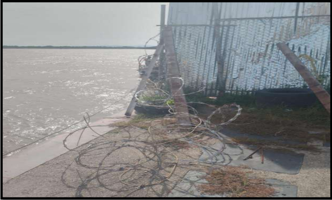
Obstáculos instalados para impedir el paso (lo han movido para poder pasar)
