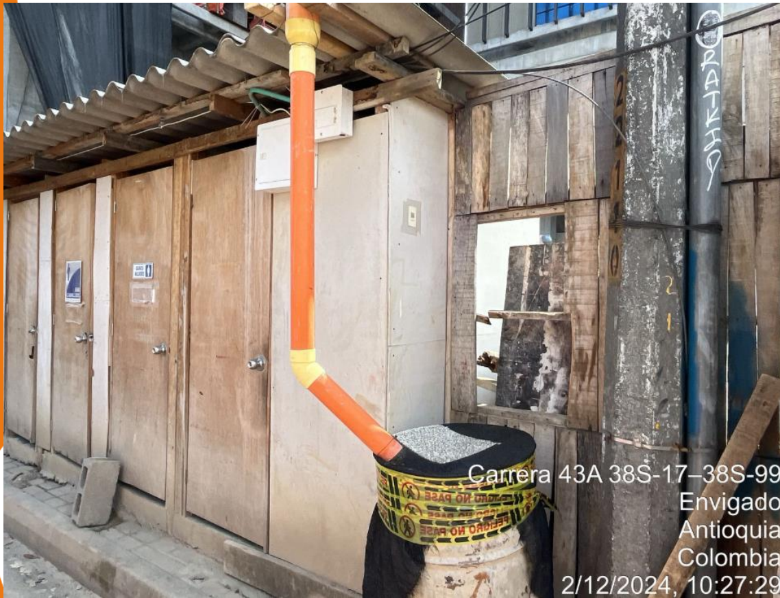
Sistema de recolección de aguas lluvias para reutilización en algunas actividades de la obra.
