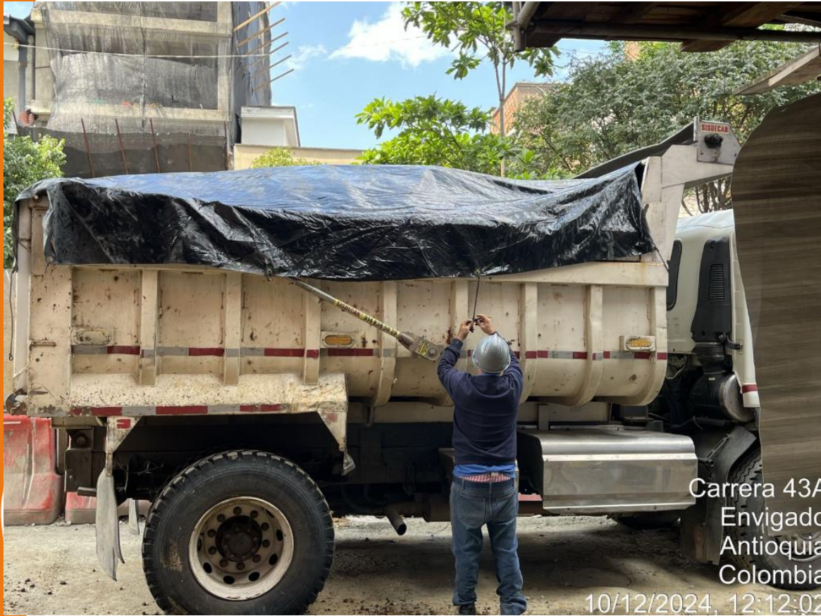
Protección del RCD en Volqueta para evitar dispersión del mismo.
