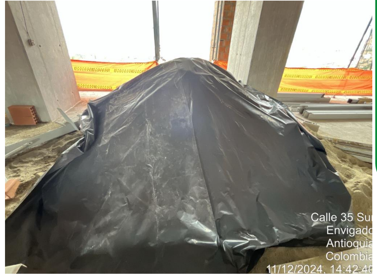
Protección de material pétreo para evitar dispersión por vientos en los diferentes niveles.
