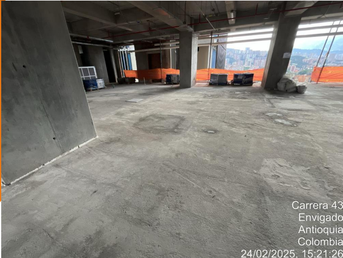
Orden y aseo en frentes de obra.
