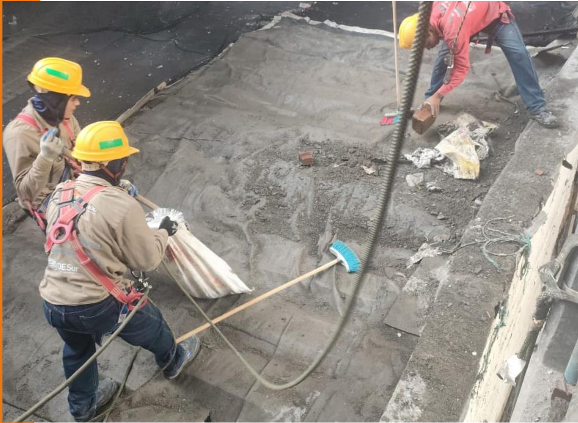
Mantenimiento de cubierta de la cárcel.
