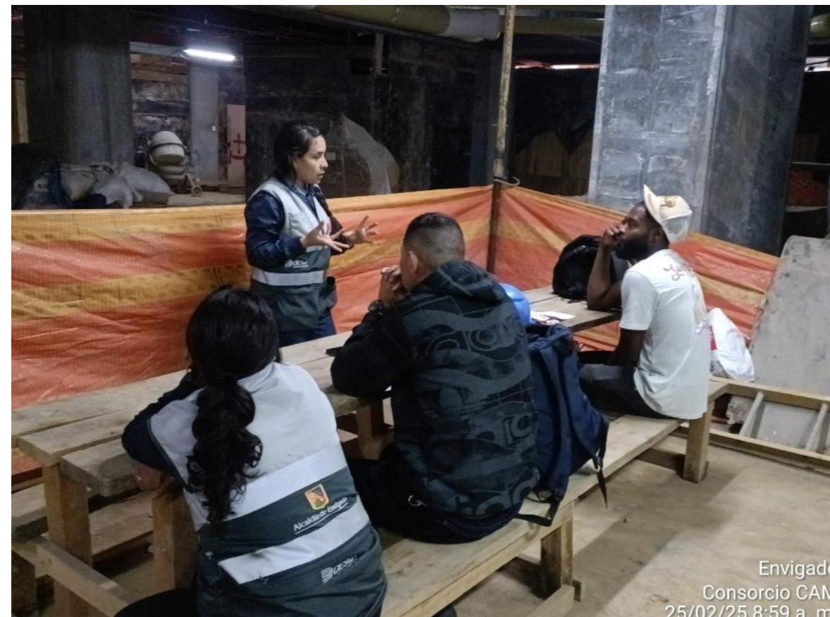
Inducción al personal que ingresa por primera vez a la obra.
