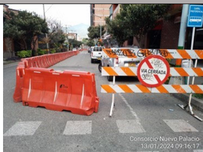
Demarcación y señalización en vías aledañas a la obra, contempladas dentro del PMT.
