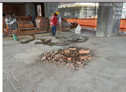
Recolección y separación de residuos generados en los frentes de obra.
