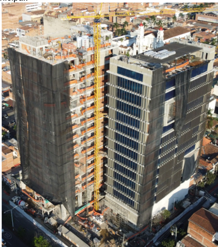
Ilustración 1. Foto Aérea del proyecto.
