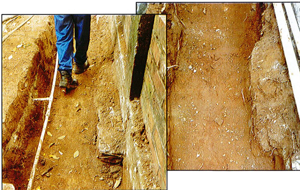
Figura 11. Cimientos enterrados para demolición
