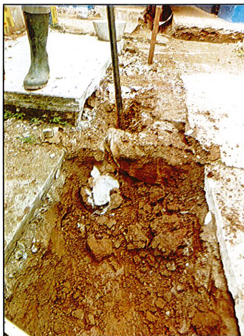
Figura 12. Bordillos a demoler
