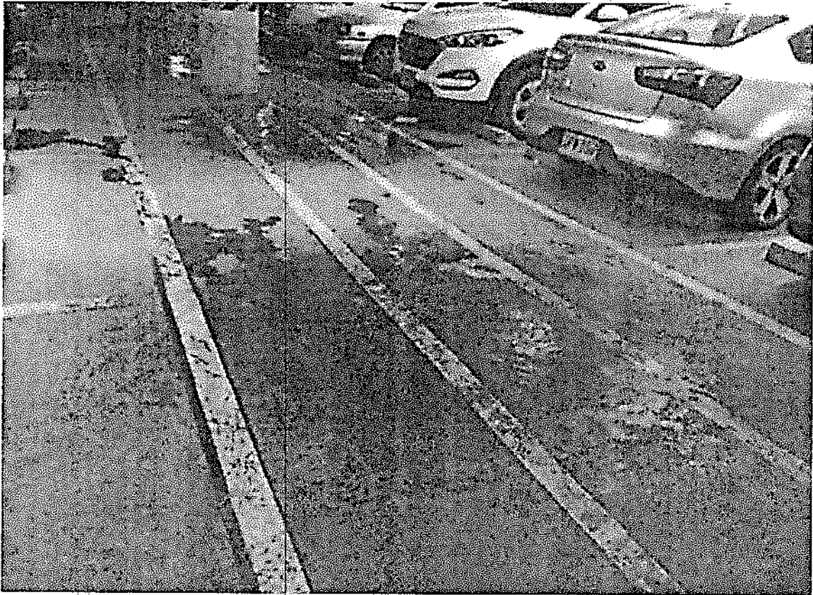
Foto 5. Filtraciones de agua de los vidrios de los ríos, sótano 1.
