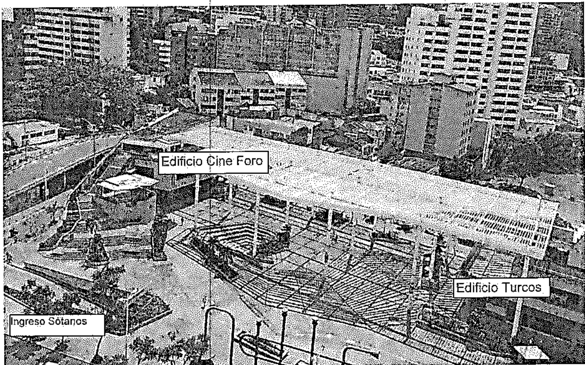
Fotografía 1. Panorámica de la Plazoleta La Calenidad (hoy Jairo Varela)
