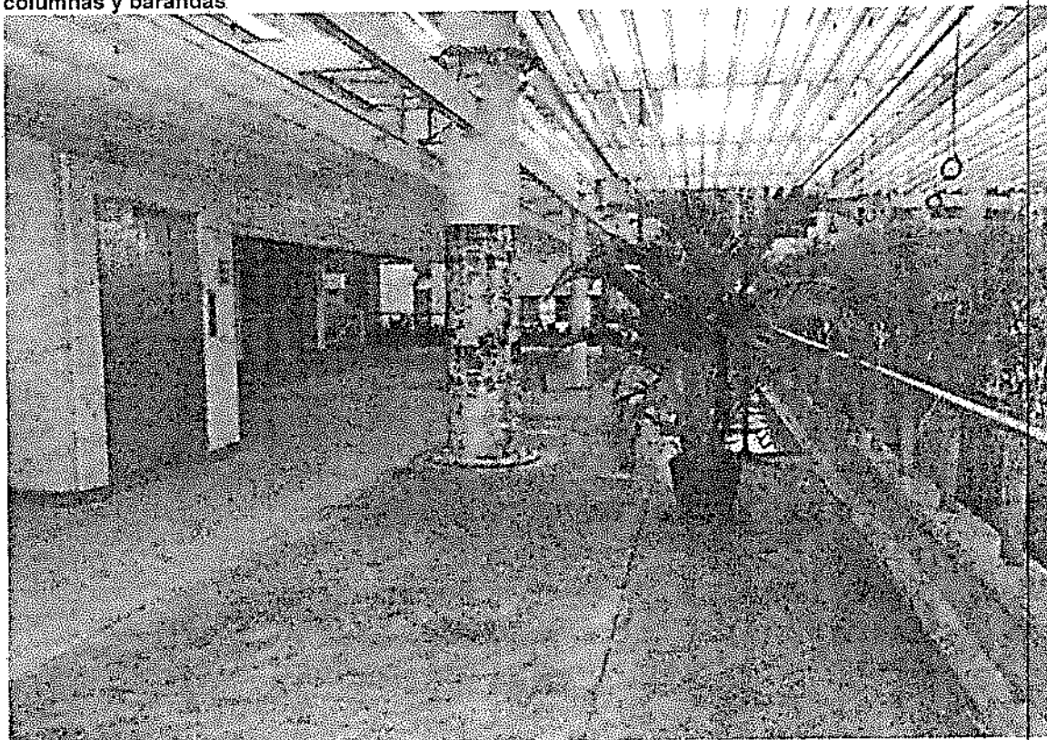
Foto 8. Restaurante ubicado en el sector plazoleta exterior, piso 2. Deterioro en pintura de las columnas y barandas
