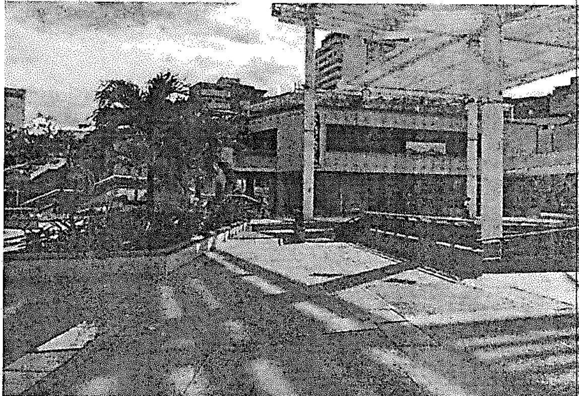
Foto 1. Panorámica del edificio Cine Foro
