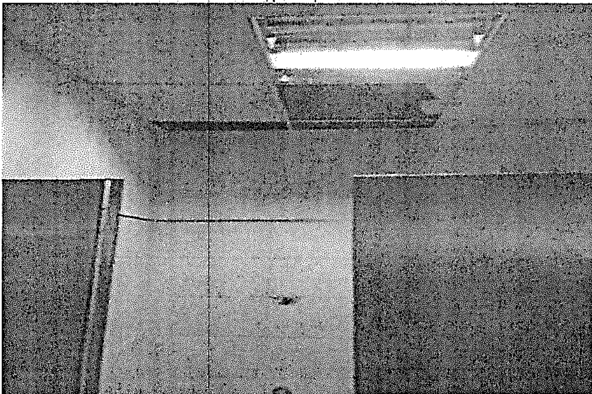
Foto 4. Humedad techo del baño de hombres, primer piso edificio Cine Foro.
