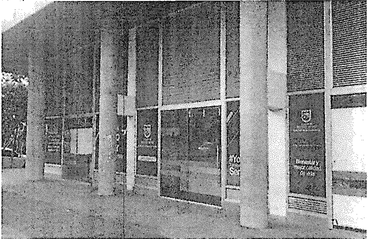
Foto 16. Exterior del edificio Los Turcos, primer piso locales que se inundan por desnivel de la plazoleta
