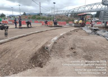
K 2+750 Construcción de acceso mantenimiento arco metalico, Glorieta de calle 8 - Variante de Zipaquira ruta 45ACN K 2+750 extension y compactacion de material granular para urbanismo rampa 1, Glorieta de calle 8 - Variante de Zipaquira ruta 45ACN
