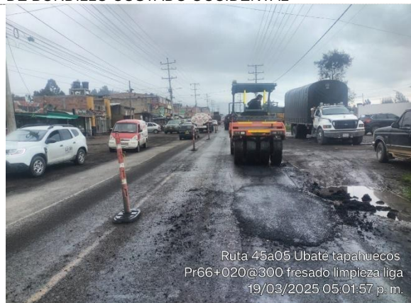
TAPAHUECOS RUTA 45 A 05, UBATÉ, PR66+0020 - PR66+0300, TAPAHUECOS CON MDC-19
