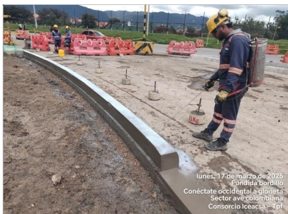
VARIANTE ZIPAQUIRÁ, ESPACIO PÚBLICO, FUNDIDA DE BORDILLO COSTADO OCCIDENTAL
