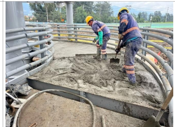
VARIANTE ZIPAQUIRÁ, PUENTE PEATONAL, FUNDIDA DE PLACA DE CURVA 1 DE RAMPA 2
