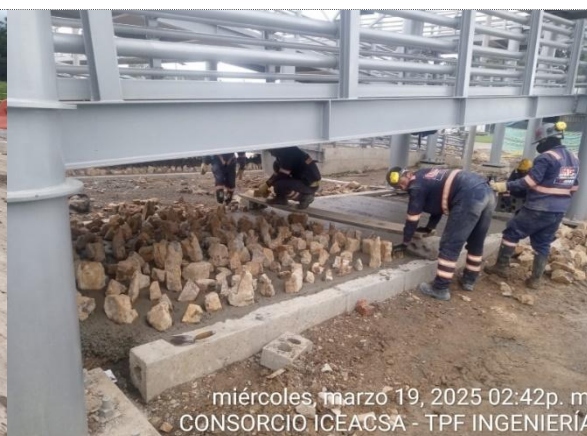
VARIANTE ZIPAQUIRÁ, ESPACIO PÚBLICO, INSTALACIÓN DE CONCRETO Y PIEDRA BAJO RAMPA 1
