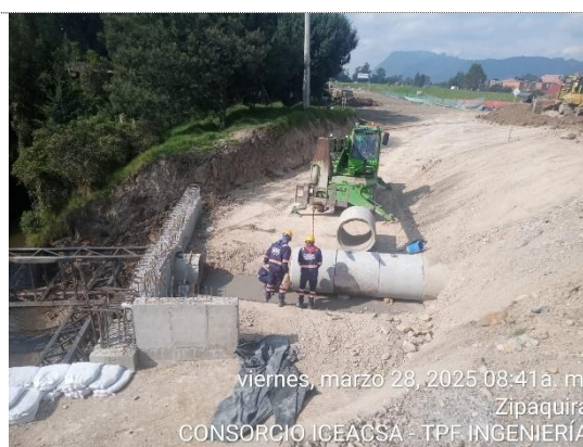
Obra No 19, instalación de tubería 900mm para desagüe de sumideros (28/03/25)
