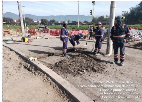
VARIANTE ZIPAQUIRÁ, ESPACIO PÚBLICO, EXCAVACIÓN PARA INSTALACIÓN DE BORDILLO
