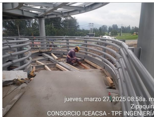
Puente peatonal, armado de formaleta en curva 3 de rampa 2 (27/03/25)
