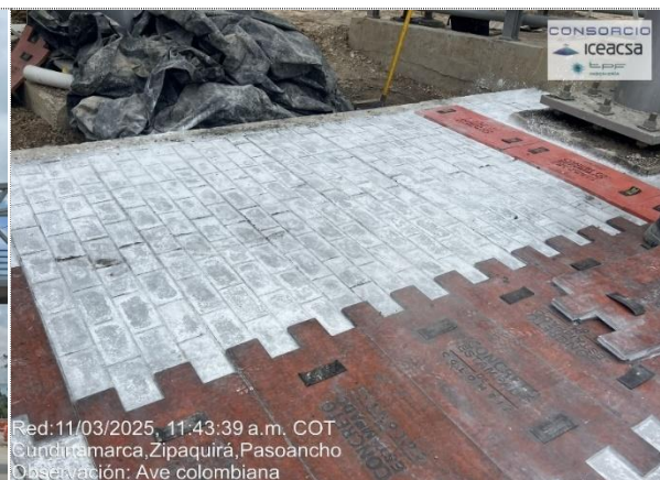
VARIANTE ZIPAQUIRÁ, ESPACIO PÚBLICO AVE COLOMBIANA, FUNDIDA DE CONCRETO ESTAMPADO EN RAMPA 1.
