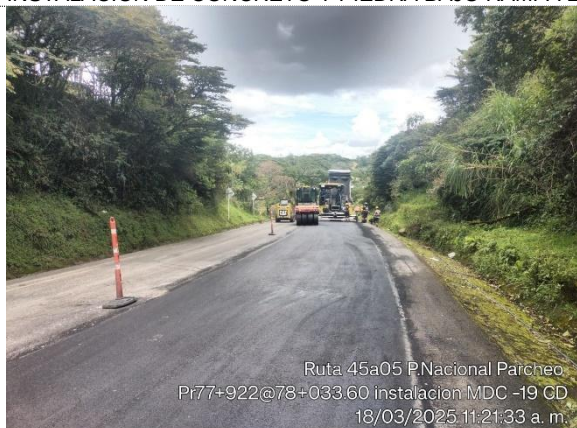
PARCHEO RUTA 45 A 05, PUENTE NACIONAL, PR77+0922 - PR78+0033, FRESADO E INSTALACIÓN DE MDC-19
