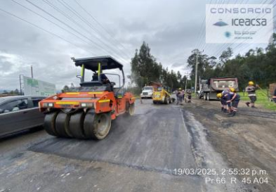
PR 66+300 Mantenimiento vial mediante parcheo. Sector de Ubaté. Ruta 45A04
