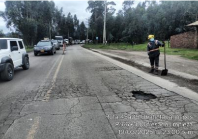
PR 66+300 Mantenimiento vial mediante parcheo. Sector de Ubaté. Ruta 45A04
