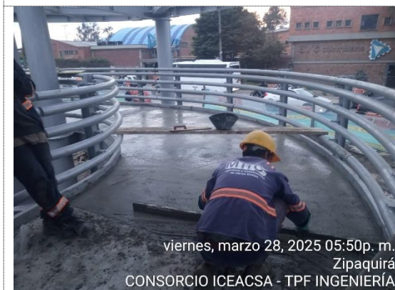
Puente peatonal, fundida de curva 2 de rampa 2 (28/03/25)
