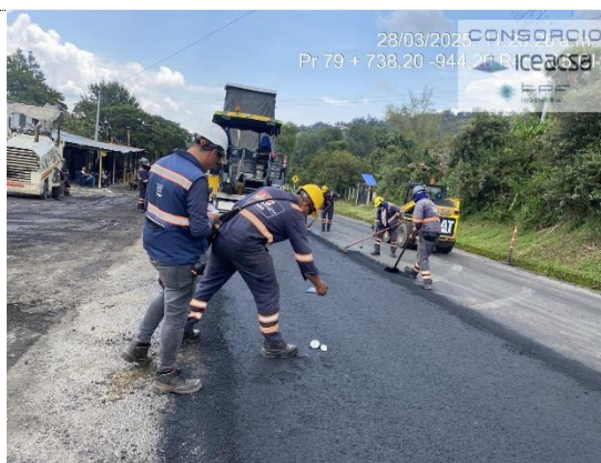
PR79+0738 – PR79+0944, Puente Nacional, fresado e instalación de BTA y MDC-19 (28/03/25)
