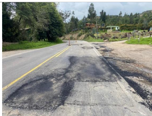
Ruta 45 A 05 Puquene Tapahuecos - Pr 22+000 @ 24+000 instalación liga MDC-19 CI 21/03/2025 02:48 c.o.p.m.
