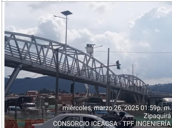
VARIANTE ZIPAQUIRÁ, PUENTE PEATONAL, INSTALACIÓN DE LUMINARIAS EN PASARELA
