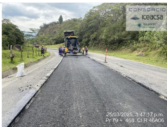
PR79+0468 – PR79+0587, Puente Nacional, fresado e instalación de BTA y MDC-19 (25/03/25)
