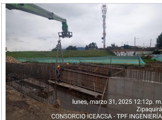
Obra No 19, fundida de 2da sección de muros de módulo 4 de canal de acceso (31/03/25)
