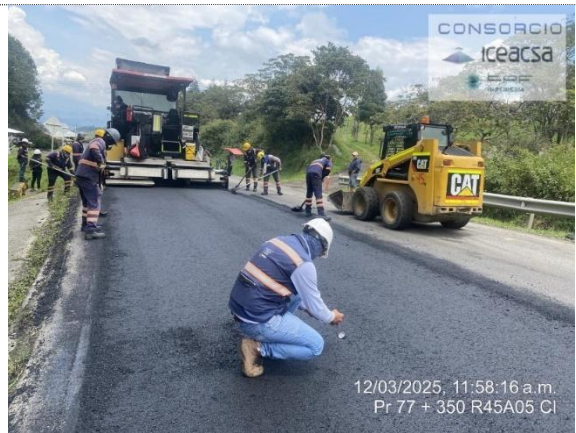
PARCHEO RUTA 45 A 05, PUENTE NACIONAL, PR77+0350 - PR77+0456, FRESADO E INSTALACIÓN DE MDC-19
