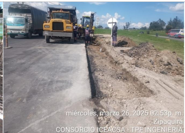
VARIANTE ZIPAQUIRÁ, CONECTANTE NORTE, CORTE DE ASFALTO Y EXCAVACIÓN PARA CONSTRUCCIÓN DE CUNETA
