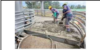
VARIANTE ZIPIQUIRÁ, PUENTE PEATONAL, FUNDIDA DE PLACA DE CURVA 1 DE RAMPA 2
