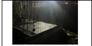
VARIANTE ZIPIQUIRÁ, OBRA No 19, FUNDIDA DE PLACA INFERIOR DE MÓDULOS 3 Y 4 DE CANAL DE ACCESO
