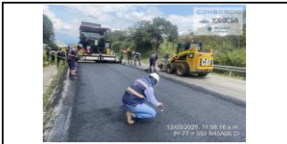
PARCHEO RUTA 45 A 05, PUENTE NACIONAL, PR77+0350 - PR77+0456, FRESADO E INSTALACIÓN DE MDC-19
