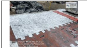
VARIANTE ZIPIQUIRÁ, ESPACIO PÚBLICO AVE COLOMBIANA, FUNDIDA DE CONCRETO ESTAMPADO EN RAMPA 1
