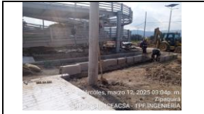
VARIANTE ZIPIQUIRÁ, ESPACIO PÚBLICO, INSTALACIÓN DE BORDILLOS COSTADO ORIENTAL DE RAMPA 1
