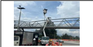
VARIANTE ZIPIQUIRÁ, PUENTE PEATONAL, INSTALACIÓN DE LUMINARIAS EN PASARELA
