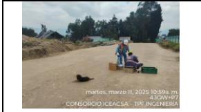
TRAMO 2, K44+130 - K44+190 LIBERACIÓN POR DENSIDADES DE CAPA DE TERRAPLEN
