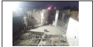
VARIANTE ZIPIQUIRÁ, OBRA No 19, FUNDIDA DE PLACA DE MÓDULO DE ALETAS DE CIERRE PÓRTICO NORTE
