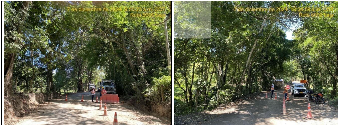
Registro fotográfico N.º 35 y 36: Ubicación de controladores de tráfico frentes de obra 6006 baja
