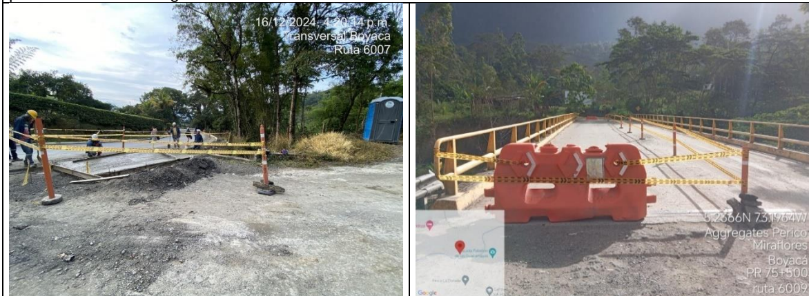
Registro fotográfico N.º 27 y 28: Señalización con cintas de peligro en los frentes de obras actividades constructivas
