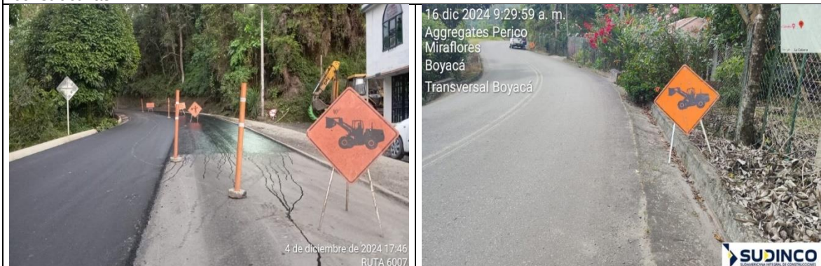
Registro fotográfico N° 29 y 30: Se realiza verificación a instalación de kits de señalización móviles preventivas instaladas en el corredor vial.
