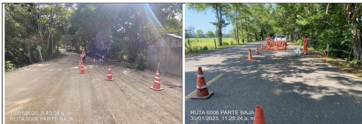
Registro fotográfico N.º 35 y 36: Ubicación de controladores de tráfico frentes de obra 6006 baja
