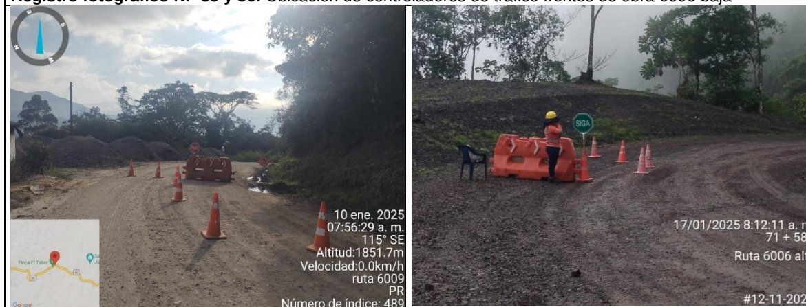
Registro fotográfico N.º 37 y 38: Ubicación de controladores de tráfico frentes de obra 6006 alta
