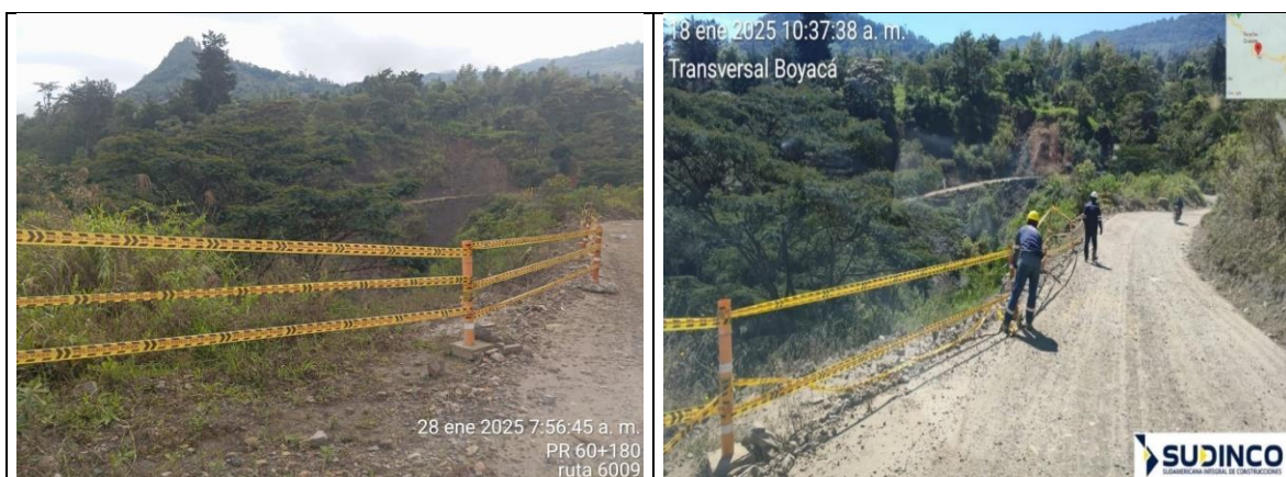
Registro fotográfico N° 25 y 26: Ubicación de señalización con delineadores y cintas de peligro en los puntos críticos a lo largo del corredor vial.
