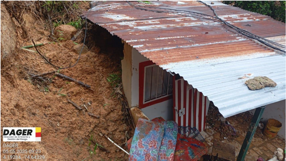
Daño en muro perimetral por deslizamiento de tierra, sector Rojas, el muro Señora DELFINA TAPIERO
