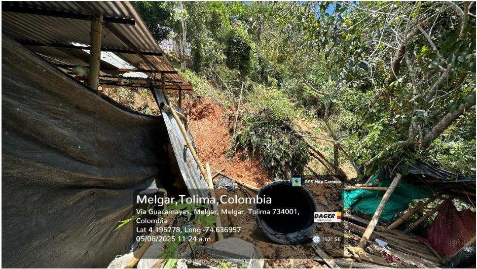
Daño en muro perimetral por deslizamiento de tierra, sector Rojas, el muro Señora DELFINA TAPIERO
