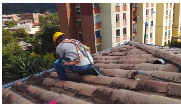
Reparacion de techo
