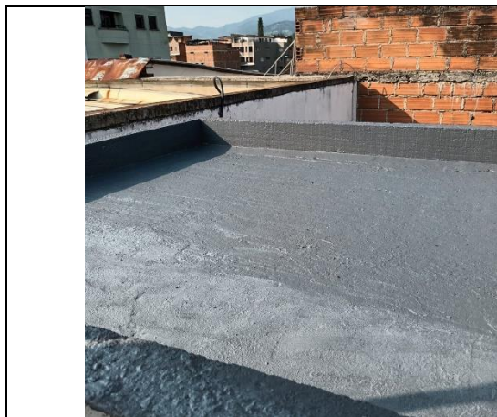
Impermeabilización de losa
