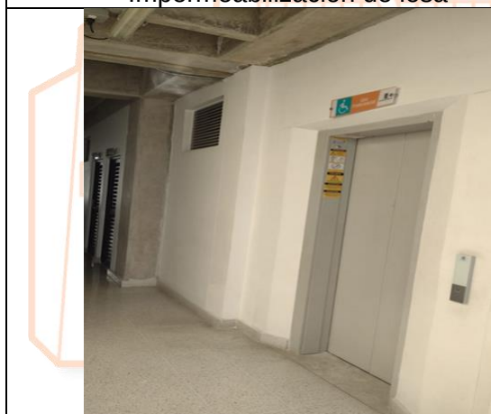
Estuco y pintura interior
