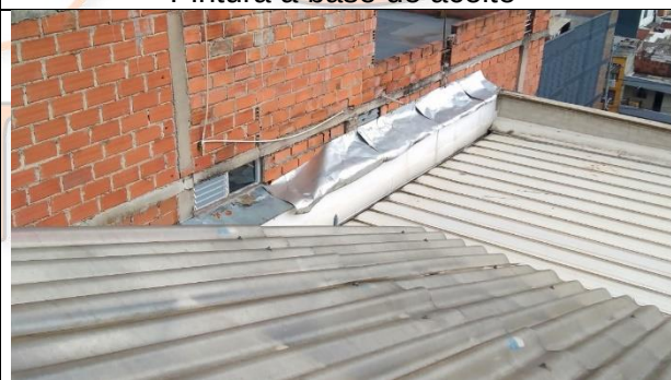
Mantenimiento de cubierta
