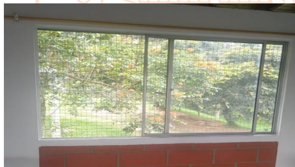
Mantenimiento de ventanas
