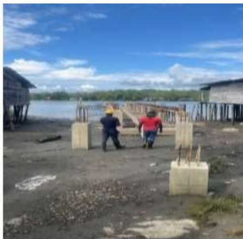
Construcción de puente central Papayal 1
