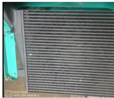
▲ Frente 2. Se realizo el mantenimiento preventivo de dos plantas eléctrica PLANTA ELECTICA QSX15-G9 (DFEK-5601632) (625KVA) y PLANTA ELECTICA 6CT (200DGF-26989) (250KVA). ▲
