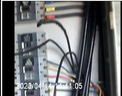
▲ Frente 2. Limpieza y mantenimiento de tablero de distribución principal existente. Incluye tapa, cambio de Breakers requeridos, organización, identificación y marcación de circuitos.. ▲
