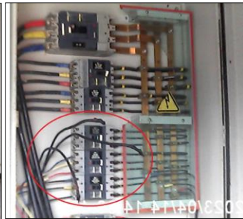
▲ Frente 2. Limpieza y mantenimiento de tablero de distribución principal existente. Incluye tapa, cambio de Breakers requeridos, organización, identificación y marcación de circuitos.. ▲
