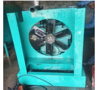
▲ Frente 2. Se realizo el mantenimiento preventivo de dos plantas eléctrica PLANTA ELECTICA QSX15-G9 (DFEK-5601632) (625KVA) y PLANTA ELECTICA 6CT (200DGF-26989) (250KVA). ▲
