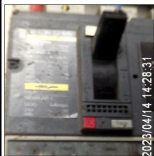
▲ Frente 2. Suministro e instalación interruptor automático tripolar con unidad de disparo termomagnética de 150A, 240 V, UL-489. Incluye su montaje y todos los elementos y accesorios necesarios para su correcto funcionamiento.. ▲
