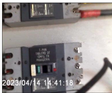
▲ Frente 2. Suministro e instalación interruptor automático tripolar con unidad de disparo termomagnética de 150A, 240 V, UL-489. Incluye su montaje y todos los elementos y accesorios necesarios para su correcto funcionamiento.. ▲
