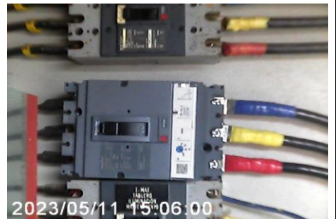
▲ Frente 2. Suministro e instalación interruptor automático tripolar con unidad de disparo termomagnética de 150A, 240 V, UL-489. Incluye su montaje y todos los elementos y accesorios necesarios para su correcto funcionamiento.. ▲
