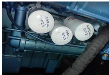
▲ Frente 2. Se realizo el mantenimiento preventivo de una planta eléctrica PLANTA ELECTICA GS800 MOTOR TGSA/ MODELO 12M26G720/6E2TALO49C. ▲
