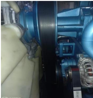
▲ Frente 2. Se realizo el mantenimiento preventivo de una planta eléctrica PLANTA ELECTICA GS800 MOTOR TGSA/ MODELO 12M26G720/6E2TALO49C. ▲
