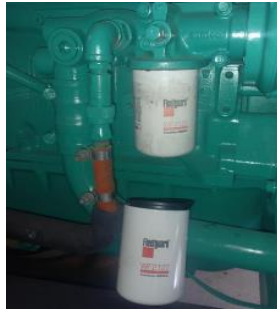
▲ Frente 2. Se realizo el mantenimiento preventivo de dos plantas eléctrica PLANTA ELECTICA QSX15-G9 (DFEK-5601632) (625KVA) y PLANTA ELECTICA 6CT (200DGF-26989) (250KVA). ▲
