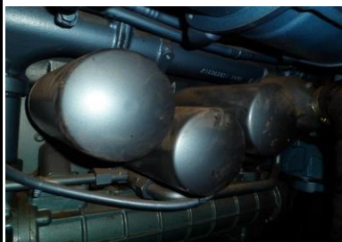
▲ Frente 2. Se realizo el mantenimiento preventivo de una planta eléctrica PLANTA ELECTICA GS800 MOTOR TGSA/ MODELO 12M26G720/6E2TALO49C. ▲
