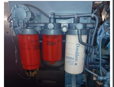
▲ Frente 2. Se realizo el mantenimiento preventivo de una planta eléctrica PLANTA ELECTICA GS800 MOTOR TGSA/ MODELO 12M26G720/6E2TALO49C. ▲
