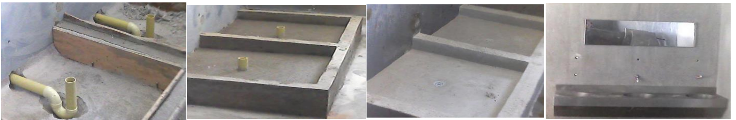
▲ Frente 2.SE REALIZO INSTALACIÓN DE DUCHAS ZONA COMÚN PABELLÓN 13 CAMPS GIRÓN ▲
