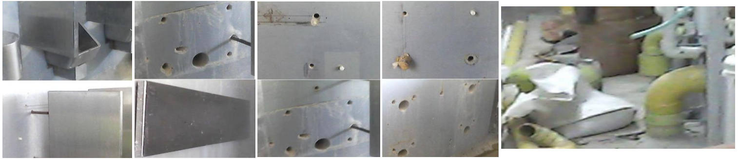
▲ Frente 2.SE REALIZO INSTALACIÓN DE DUCHAS ZONA COMÚN PABELLÓN 13 CAMPS GIRÓN ▲
