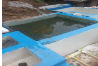
Descripción: RELLENO DE MATERIAL FILTRANTE
