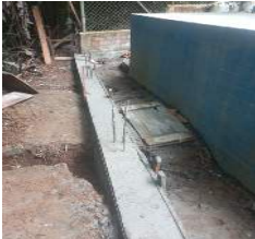
Descripción: CIMENTACION PARA CERRAMIENTO
