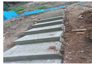
Descripción: CONSTRUCCION DE 6RADAS
